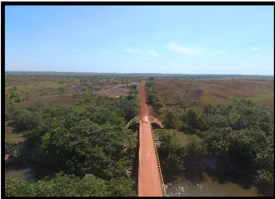
ACCESO SALIENDO DEL PUENTE
