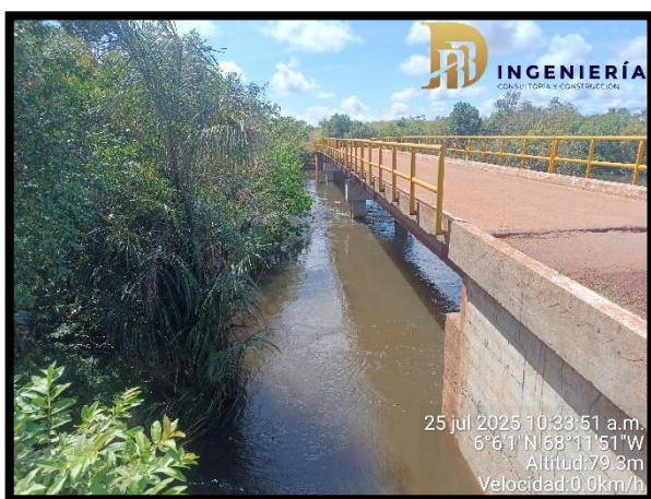
PUENTE DE TRES LUCES
