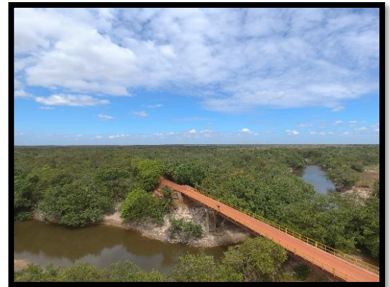
ACCESO ENTRANDO AL PUENTE
