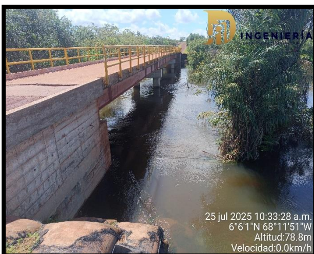
ESTRUCTURA DE PLACA Y VIGA METALICA
