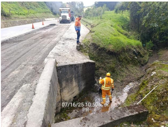
CARRETERA: BARBOSA-TUNJA(6209) SITIO: PR48+0802 DESCRIPCIÓN: SUPERVISION TRABAJOS MANTENIMIENTO RUTINARIO FECHA: 16 de julio de 2025
