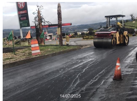
CARRETERA: BARBOSA-TUNJA (6209) SITIO: PR63+0500 DESCRIPCIÓN: SEGUIMIENTO CONTRATOS EN EJECUCION FECHA: 14 de julio de 2025
