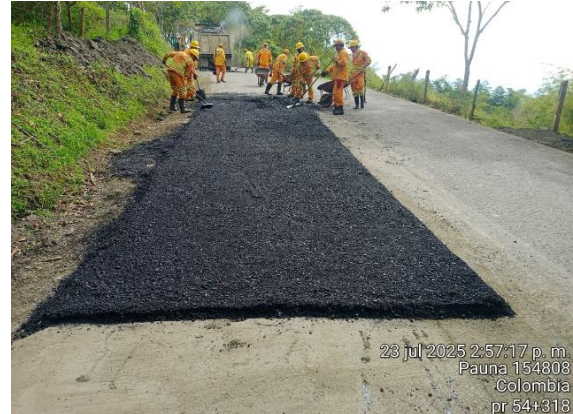
CARRETERA: OTANCHE - CHIQUINQUIRA (6007) SITIO: PR54+0318 DESCRIPCIÓN: INSTALACIÓN DE MEZCLA ASFÁLTICA FECHA: 23 de julio de 2025
