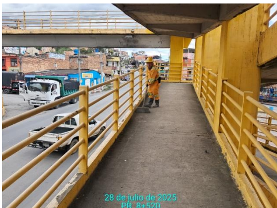
CARRETERA: BARBOSA-TUNJA (6209) SITIO: PR08+0250 DESCRIPCIÓN: LIMPIEZA DE PUENTE FECHA: 28 de julio de 2025
