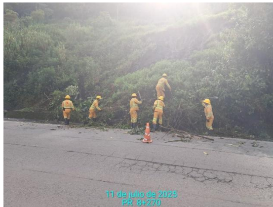
CARRETERA: BARBOSA-TUNJA (6209) SITIO: PR08+0270 DESCRIPCIÓN: RETIRO DE DERRUMBE MENOR FECHA: 11 de julio de 2025
