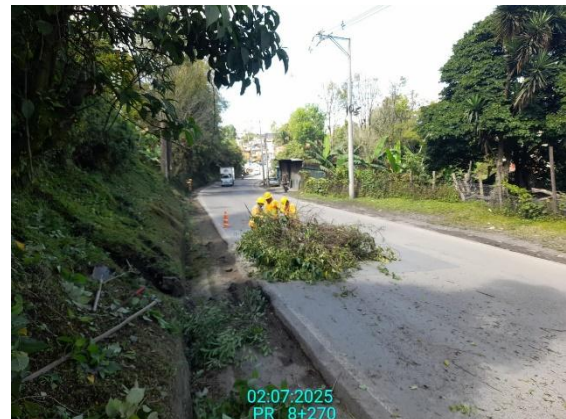
CARRETERA: BARBOSA-TUNJA (6209) SITIO: PR08+0270 DESCRIPCIÓN: DESMONTE MANUAL FECHA: 02 de julio de 2025
