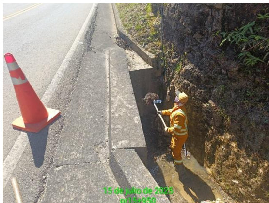
CARRETERA: CHIQUINQUIRÁ - TUNJA (6008) SITIO: PR15+0950 DESCRIPCIÓN: LIMPIEZA DE OBRAS DE DRENAJE FECHA: 15 de julio de 2025
