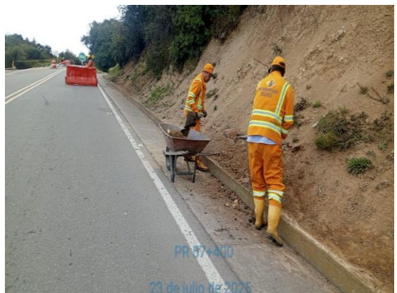
CARRETERA: BARBOSA-TUNJA (6209) SITIO: PR57+0400 DESCRIPCIÓN: LIMPIEZA DE CUNETAS REVESTIDAS FECHA: 23 de julio de 2025
