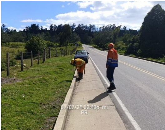
CARRETERA: CHIQUINQUIRÁ - TUNJA (6008) SITIO: PR4+0300 DESCRIPCIÓN: SUPERVISION TRABAJOS MANTENIMIENTO RUTINARIO FECHA: 07 de julio de 2025
