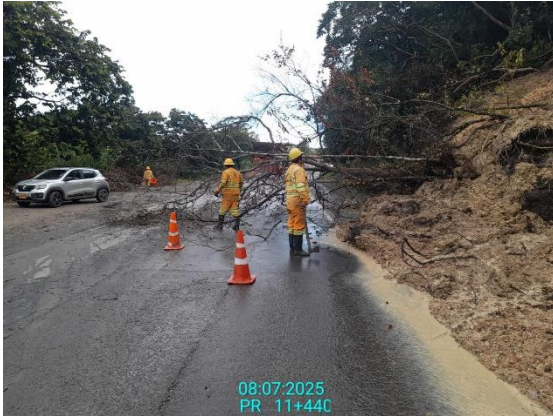
CARRETERA: BARBOSA-TUNJA (6209) SITIO: PR11+0440 DESCRIPCIÓN: RETIRO DE DERRUMBE MENOR FECHA: 08 de julio de 2025
