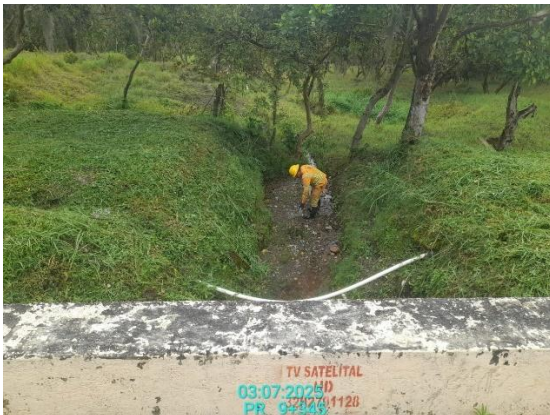
CARRETERA: BARBOSA-TUNJA (6209) SITIO: PR09+0345 DESCRIPCIÓN: LIMPIEZA DESCOLE OBRA DE DRENAJE FECHA: 03 de julio de 2025
