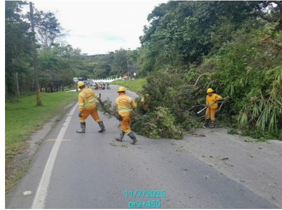
CARRETERA: BARBOSA-TUNJA (6209) SITIO: PR09+0450 DESCRIPCIÓN: RETIRO DERRUMBE MENOR FECHA: 11 de julio de 2025
