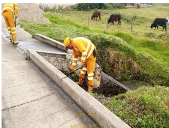
CARRETERA: BARBOSA-TUNJA (6209) SITIO: PR25+0950 DESCRIPCIÓN: LIMPIEZA OBRA DE DRENAJE FECHA: 08 de julio de 2025
