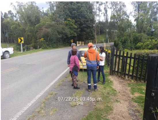
07/22/25 03:45p. m. PR CARRETERA: CHIQUINQUIRA - TUNJA (6008) SITIO: PR11+0220 DESCRIPCIÓN: INSPECCIÓN TECNICA A SOLICITUD FECHA: 22 de julio de 2025
