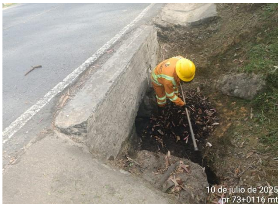
CARRETERA: OTANCHE - CHIQUINQUIRÁ (6007) SITIO: PR73+0116 DESCRIPCIÓN: LIMPIEZA DE OBRAS DE DRENAJE FECHA: 10 de julio de 2025
