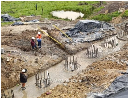
CARRETERA: BARBOSA-TUNJA SITIO: PR57+0500 DESCRIPCIÓN: SEGUIMIENTO CONTRATOS EN EJECUCION FECHA: 16 de julio de 2025
