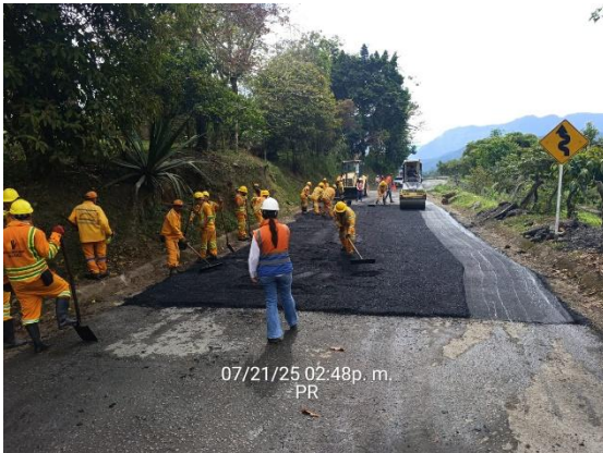
07/21/25 02:48p. m. PR CARRETERA: OTANCHE - CHIQUINQUIRA (6007) SITIO: PR54+0030 DESCRIPCIÓN: SUPERVISION COMPACTACION MEZCLA ASFALTICA FECHA: 21 de julio de 2025
