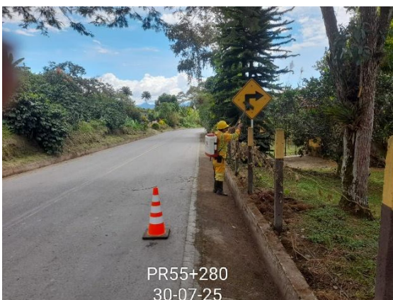
CARRETERA: OTANCHE - CHIQUINQUIRA (6007) SITIO: PR55+0280 DESCRIPCIÓN: LIMPIEZA DE SEÑALIZACIÓN VERTICAL FECHA: 30 de julio de 2025
