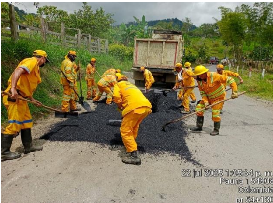
CARRETERA: OTANCHE - CHIQUINQUIRÁ (6007) SITIO: PR54+0130 DESCRIPCIÓN: INSTALACIÓN DE MEZCLA ASFÁLTICA FECHA: 22 de julio de 2025
