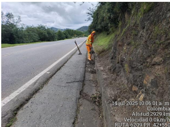
CARRETERA: BARBOSA-TUNJA (6209) SITIO: PR42+0550 DESCRIPCIÓN: LIMPIEZA DE CUNETA REVESTIDA FECHA: 14 de julio de 2025
