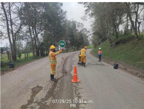
CARRETERA: OTANCHE- CHIQUINQUIRA (6007) SITIO: PR 69+0800 DESCRIPCIÓN: SUPERVISION CORTE PAVIMENTO FECHA: 29 de julio de 2025
