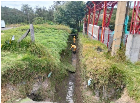
CARRETERA: OTANCHE - CHIQUINQUIRA (6007) SITIO: PR85+0350 DESCRIPCIÓN: LIMPIEZA DESCOLE OBRA DE DRENAJE FECHA: 30 de julio de 2025
