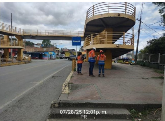
CARRETERA: BARBOSA-TUNJA(6209) SITIO: PR 1+0950 DESCRIPCIÓN: INVENTARIO PUENTE PEATONAL MONIQUIRÁ FECHA: 28 de julio de 2025
