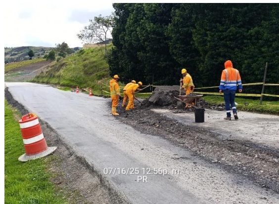
CARRETERA: BARBOSA - TUNJA (6209) SITIO: PR51+0400 DESCRIPCIÓN: SUPERVISIÓN RENIVELACIÓN CON AFIRMADO FECHA: 16 de julio de 2025
