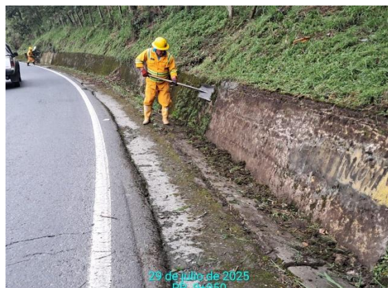
CARRETERA: BARBOSA-TUNJA (6209) SITIO: PR09+0950 DESCRIPCIÓN: LIMPIEZA MURO FECHA: 29 de julio de 2025
