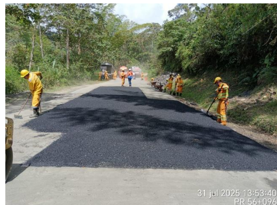
CARRETERA: OTANCHE - CHIQUINQUIRA (6007) SITIO: PR56+0096 DESCRIPCIÓN: INSTALACIÓN DE MEZCLA ASFÁLTICA FECHA: 31 de julio de 2025
