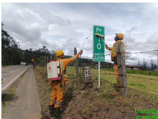
CARRETERA: CHIQUINQUIRÁ - TUNJA (6008) SITIO: PR14+0300 DESCRIPCIÓN: LIMPIEZA DE SEÑALIZACION VERTICAL FECHA: 10 de julio de 2025
