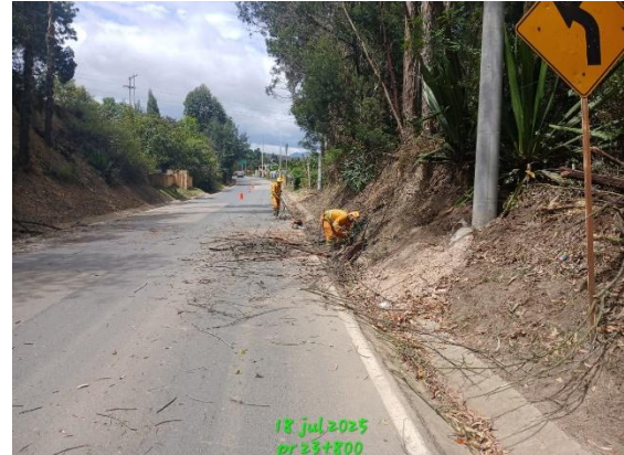
CARRETERA: CHIQUINQUIRÁ - TUNJA (6008) SITIO: PR23+0800 DESCRIPCIÓN: LIMPIEZA DE CALZADA Y CUNETETA FECHA: 18 de julio de 2025
