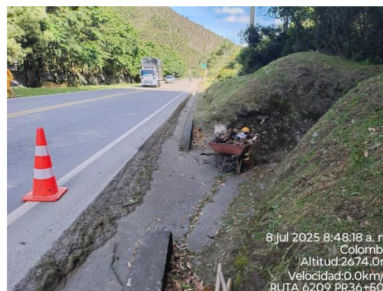
CARRETERA: BARBOSA-TUNJA (6209) SITIO: PR36+0500 DESCRIPCIÓN: LIMPIEZA OBRA DE DRENAJE FECHA: 08 de julio de 2025
