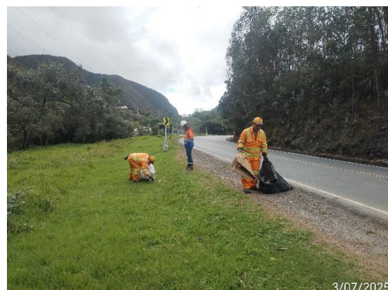
CARRETERA: BARBOSA - TUNJA (6209) SITIO: PR37+0000 DESCRIPCIÓN: SUPERVISION TRABAJOS MANTENIMIENTO RUTINARIO FECHA: 03 de julio de 2025
