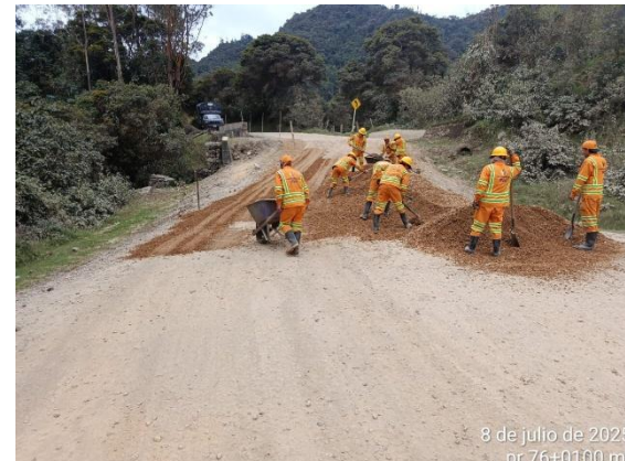
CARRETERA: OTANCHE - CHIQUINQUIRÁ (6007) SITIO: PR76+0100 DESCRIPCIÓN: NIVELACIÓN CON MATERIAL DE AFIRMADO FECHA: 08 de julio de 2025
