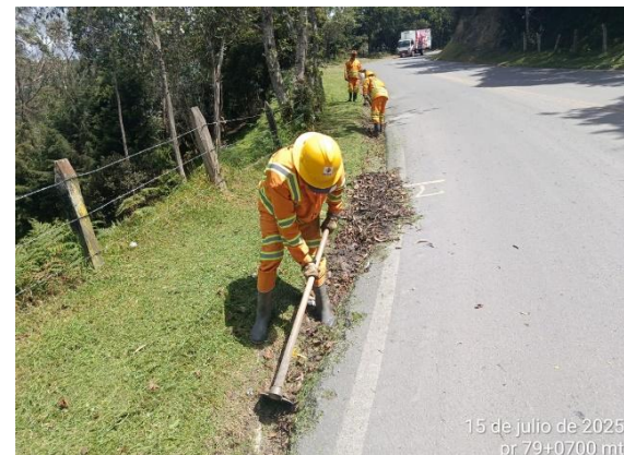
CARRETERA: OTANCHE - CHIQUINQUIRÁ (6007) SITIO: PR79+0700 DESCRIPCIÓN: CONFORMACIÓN CUNETAS EN TIERRA FECHA: 15 de julio de 2025
