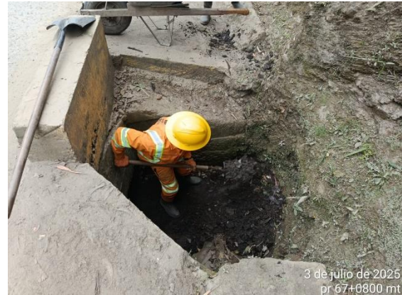
CARRETERA: OTANCHE - CHIQUINQUIRÁ (6007) SITIO: PR32+0763 DESCRIPCIÓN: LIMPIEZA OBRAS DE DRENAJE FECHA: 01 de julio de 2025
