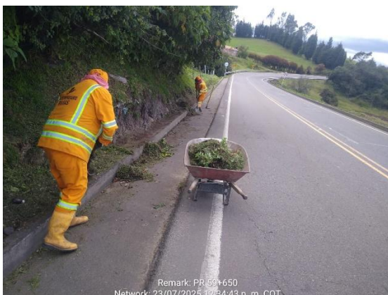
CARRETERA: BARBOSA-TUNJA (6209) SITIO: PR59+0650 DESCRIPCIÓN: LIMPIEZA DE CUNETAS REVESTIDAS FECHA: 23 de julio de 2025
