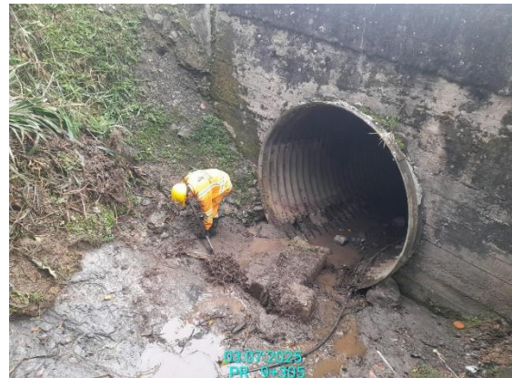
CARRETERA: BARBOSA-TUNJA (6209) SITIO: PR09+0305 DESCRIPCIÓN: LIMPIEZA OBRA DE DRENAJE FECHA: 03 de julio de 2025
