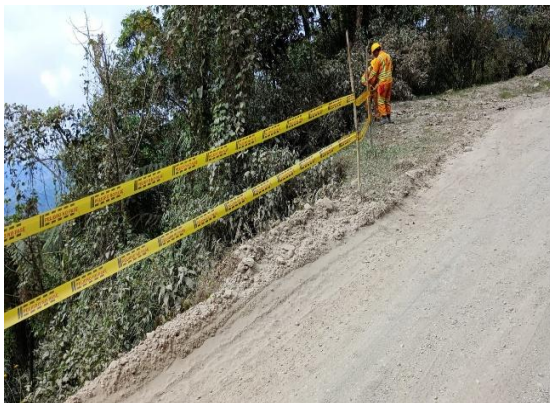
CARRETERA: OTANCHE - CHIQUINQUIRÁ (6007) SITIO: PR60+0700 DESCRIPCIÓN: SEÑALIZACIÓN PUNTO CRÍTICO FECHA: 29 de julio de 2025
