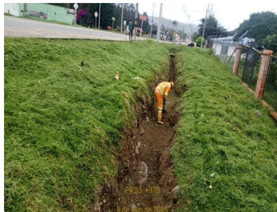
CARRETERA: BARBOSA-TUNJA (6209) SITIO: PR33+0970 DESCRIPCIÓN: LIMPIEZA DESCOLE OBRA DE DRENAJE FECHA: 08 de julio de 2025
