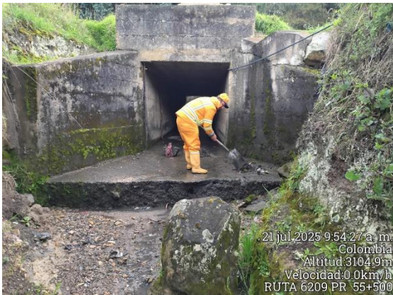
CARRETERA: BARBOSA-TUNJA (6209) SITIO: PR55+0500 DESCRIPCIÓN: LIMPIEZA OBRA DE DRENAJE FECHA: 21 de julio de 2025
