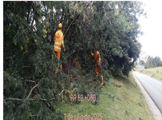
CARRETERA: BARBOSA-TUNJA (6209) SITIO: PR62+0000 DESCRIPCIÓN: DESMONTE MANUAL FECHA: 01 de julio de 2025
