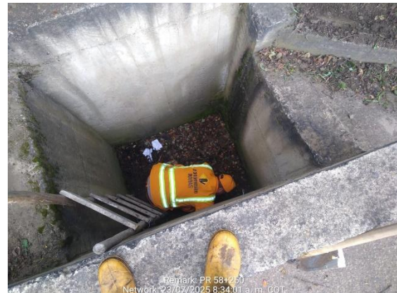
CARRETERA: BARBOSA-TUNJA (6209) SITIO: PR 58+0250 DESCRIPCIÓN: LIMPIEZA OBRA DE DRENAJE FECHA: 21 de julio de 2025
