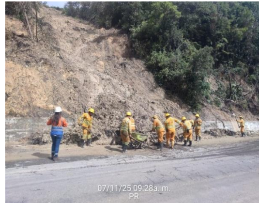
CARRETERA: BARBOSA - TUNJA (6209) SITIO: PR11+0440 DESCRIPCIÓN: SUPERVISION TRABAJOS MANTENIMIENTO RUTINARIO FECHA: 11 de julio de 2025
