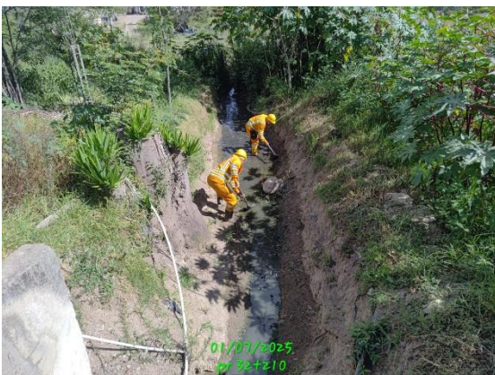
CARRETERA: CHIQUINQUIRÁ - TUNJA (6008) SITIO: PR32+0210 DESCRIPCIÓN: LIMPIEZA OBRAS DE DRENAJE FECHA: 07 de julio de 2025
