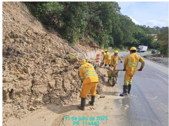
CARRETERA: BARBOSA-TUNJA (6209) SITIO: PR11+0440 DESCRIPCIÓN: RETIRO DERRUMBE MENOR FECHA: 11 de julio de 2025
