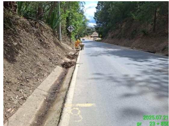
CARRETERA: CHIQUINQUIRÁ - TUNJA (6008) SITIO: PR 23+0850 DESCRIPCIÓN: LIMPIEZA DE CUNETAS REVESTIDAS FECHA: 21 de julio de 2025
