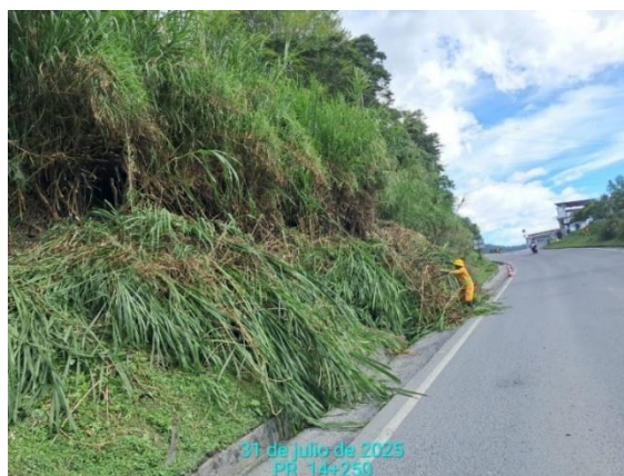
CARRETERA: BARBOSA-TUNJA (6209) SITIO: PR14+0250 DESCRIPCIÓN: DESMONTE MANUAL FECHA: 31 de julio de 2025
