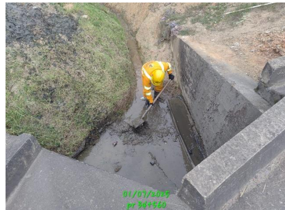
CARRETERA: CHIQUINQUIRÁ - TUNJA (6008) SITIO: PR34+0560 DESCRIPCIÓN: LIMPIEZA OBRAS DE DRENAJE FECHA: 01 de julio de 2025
