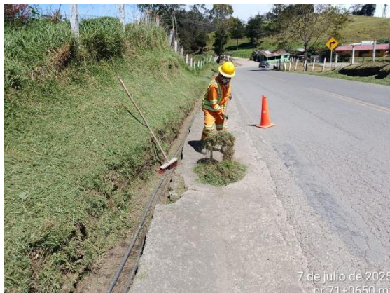
CARRETERA: OTANCHE - CHIQUINQUIRÁ (6007) SITIO: PR71+0650 DESCRIPCIÓN: LIMPIEZA DE CUNETAS FECHA: 07 de julio de 2025
