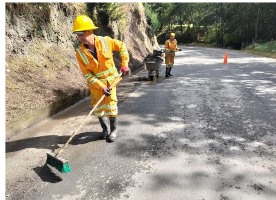
CARRETERA: OTANCHE - CHIQUINQUIRA (6007) SITIO: PR84+0700 DESCRIPCIÓN: LIMÍEZA DE CALZADA Y CUNETETA FECHA: 30 de julio de 2025
