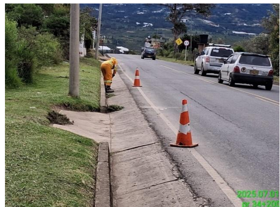
CARRETERA: CHIQUINQUIRÁ - TUNJA (6008) SITIO: PR34+0200 DESCRIPCIÓN: LIMPIEZA DE CUNETAS REVESTIDAS FECHA: 01 de julio de 2025
