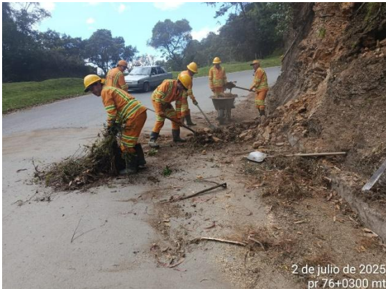
CARRETERA: OTANCHE - CHIQUINQUIRÁ (6007) SITIO: PR44+0300 DESCRIPCIÓN: RETIRO DE DERRUMBES MENORES FECHA: 09 de julio de 2025
