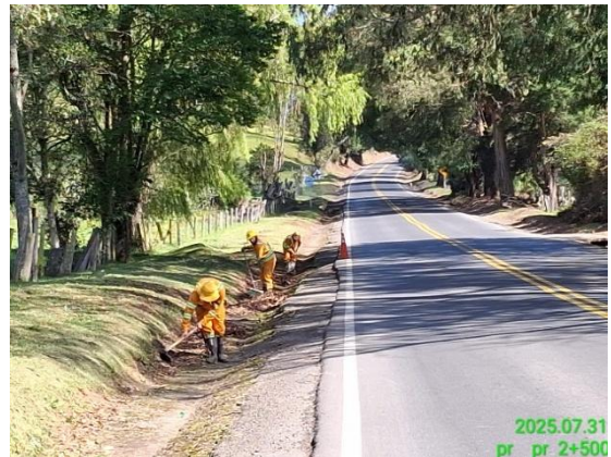
CARRETERA: CHIQUINQUIRÁ - TUNJA (6008) SITIO: PR02+0500 DESCRIPCIÓN: LIMPIEZA DE CUNETAS FECHA: 31 de julio de 2025
