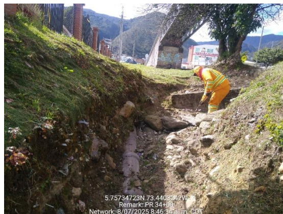
CARRETERA: BARBOSA-TUNJA (6209) SITIO: PR34+0000 DESCRIPCIÓN: LIMPIEZA DESCOLE DE OBRA DE DRENAJE FECHA: 08 de julio de 2025
