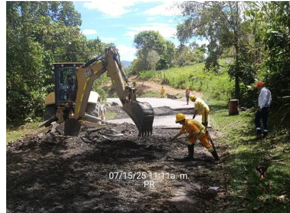
CARRETERA: OTANCHE - CHIQUINQUIRA (6007) SITIO: PR 1+0950 DESCRIPCIÓN: SUPERVISION COMPACTACION MEZCLA ASFALTICA FECHA: 15 de julio de 2025
