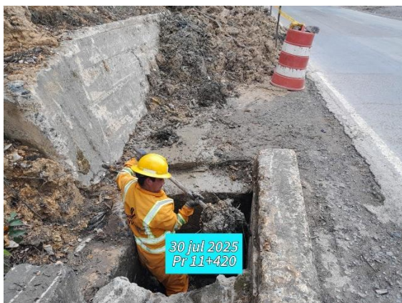
CARRETERA: BARBOSA-TUNJA (6209) SITIO: PR11+0420 DESCRIPCIÓN: LIMPIEZA OBRA DE DRENAJE FECHA: 30 de julio de 2025
