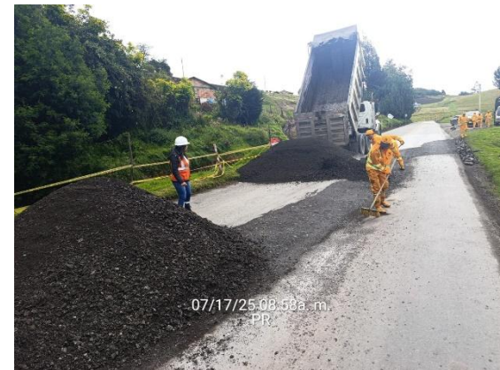
CARRETERA: BARBOSA - TUNJA (6209) SITIO: PR51+0400 DESCRIPCIÓN: SUPERVISIÓN RENIVELACIÓN CON AFIRMADO FECHA: 17 de julio de 2025
