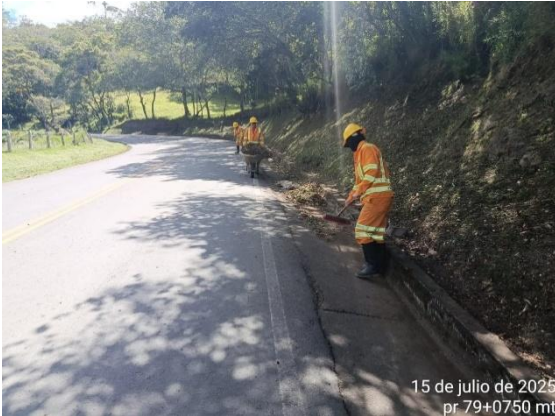
CARRETERA: OTANCHE - CHIQUINQUIRÁ (6007) SITIO: PR79+0750 DESCRIPCIÓN: LIMPIEZA DE CUNETAS REVESTIDAS FECHA: 15 de julio de 2025
