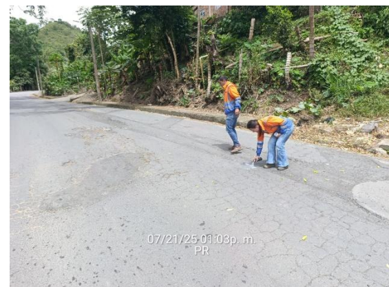
CARRETERA: OTANCHE - CHIQUINQUIRA (6007) SITIO: PR 11+0300 DESCRIPCIÓN: DEMARCACIÓN PARA CORTE DE ASFALTO FECHA: 21 de julio de 2025
