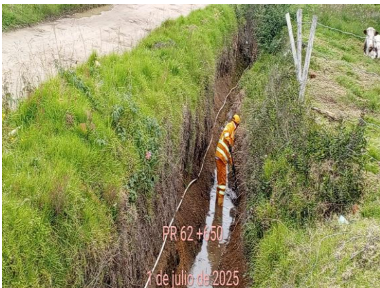
CARRETERA: BARBOSA-TUNJA (6209) SITIO: PR62+0650 DESCRIPCIÓN: LIMPIEZA DESCOLE OBRA DE DRENAJE FECHA: 01 de julio de 2025
