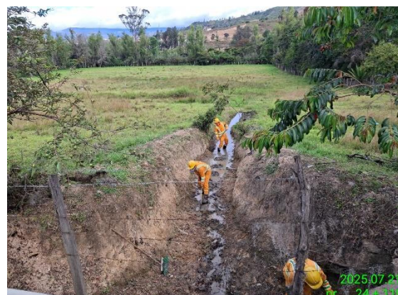
CARRETERA: CHIQUINQUIRÁ - TUNJA (6008) SITIO: PR24+0100 DESCRIPCIÓN: LIMPIEZA DESCOLE OBRA DE DRENAJE FECHA: 21 de julio de 2025
