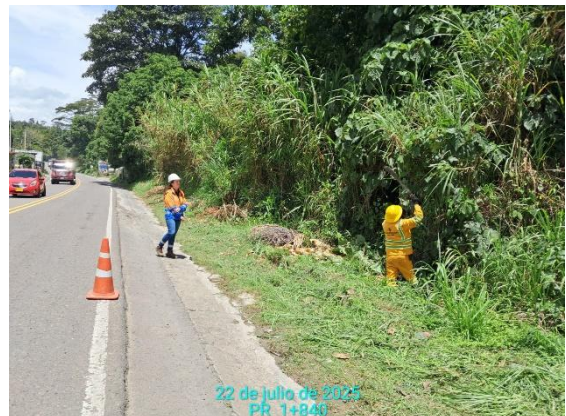
22 de julio de 2025 PR 1+940 CARRETERA: BARBOSA - TUNJA (6209) SITIO: PR01+0840 DESCRIPCIÓN: SUPERVISION TRABAJOS MANTENIMIENTO RUTINARIO FECHA: 22 de julio de 2025
