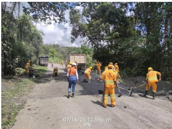
CARRETERA: OTANCHE - CHIQUINQUIRA (6007) SITIO: PR53+0380 DESCRIPCIÓN: SUPERVISIÓN COMPACTACION MEZCLA ASFALTICA FECHA: 16 de julio de 2025
