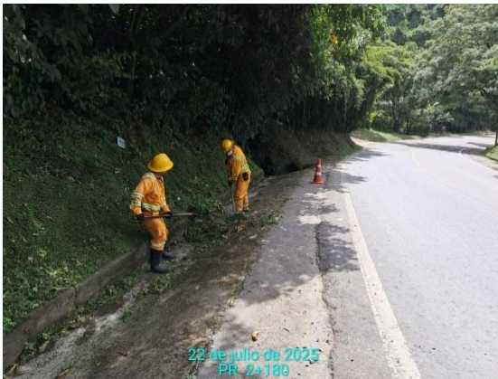
CARRETERA: BARBOSA-TUNJA (6209) SITIO: PR02+0180 DESCRIPCIÓN: LIMPIEZA DE CUNETAS FECHA: 22 de julio de 2025
