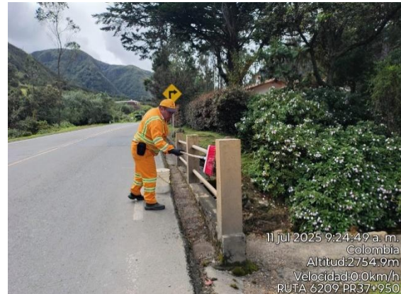
CARRETERA: BARBOSA-TUNJA (6209) SITIO: PR37+0950 DESCRIPCIÓN: LIMPIEZA BARANDAS FECHA: 11 de julio de 2025
