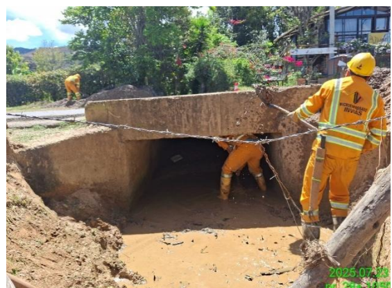
CARRETERA: CHIQUINQUIRÁ - TUNJA (6008) SITIO: PR28+1050 DESCRIPCIÓN: LIMPIEZA OBRA DE DRENAJE FECHA: 23 de julio de 2025
