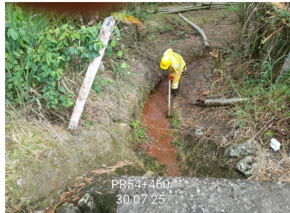
CARRETERA: OTANCHE - CHIQUINQUIRA (6007) SITIO: PR 54+0460 DESCRIPCIÓN: LIMPIEZA DESCOLES Y ENCOLES FECHA: 30 de julio de 2025
