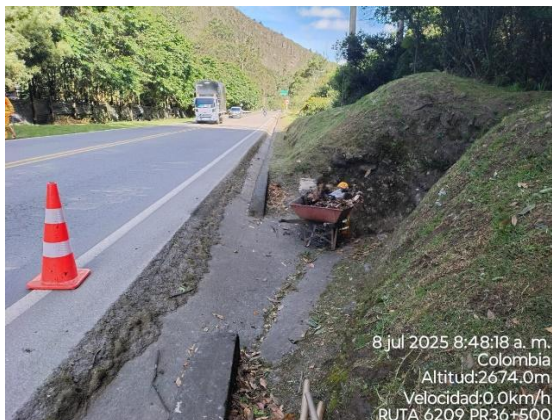
CARRETERA: BARBOSA-TUNJA (6209) SITIO: PR36+0500 DESCRIPCIÓN: LIMPIEZA DE OBRAS DE DRENAJE FECHA: 08 de julio de 2025
