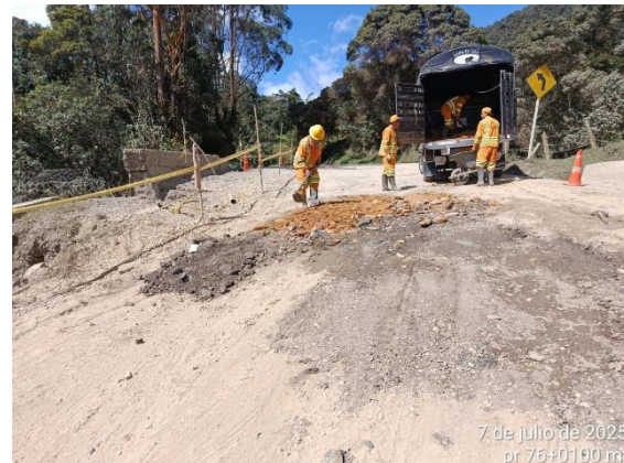
CARRETERA: OTANCHE - CHIQUINQUIRÁ (6007) SITIO: PR76+0100 DESCRIPCIÓN: NIVELACIÓN CON MATERIAL DE AFIRMADO FECHA: 07 de julio de 2025
