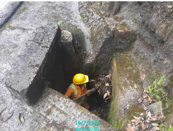
CARRETERA: BARBOSA-TUNJA (6209) SITIO: PR25+0950 DESCRIPCIÓN: LIMPIEZA OBRA DE DRENAJE FECHA: 15 de julio de 2025
