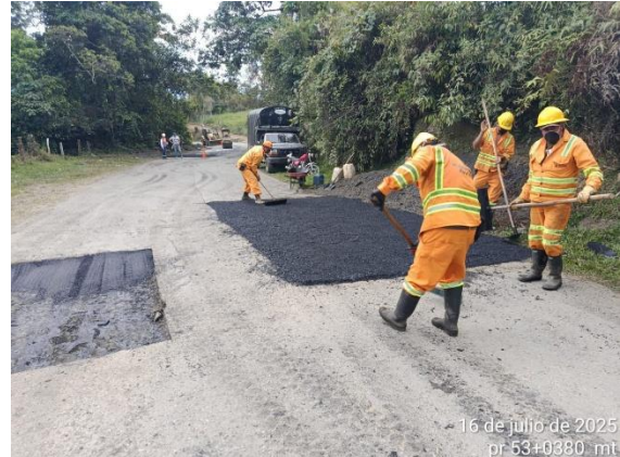
CARRETERA: OTANCHE - CHIQUINQUIRÁ (6007) SITIO: PR53+0380 DESCRIPCIÓN: INSTALACIÓN DE MEZCLA ASFÁLTICA FECHA: 16 de julio de 2025
