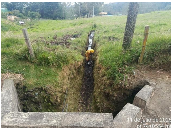
CARRETERA: OTANCHE - CHIQUINQUIRÁ (6007) SITIO: PR74+0554 DESCRIPCIÓN: LIMPIEZA DESCOLES OBRA DE DRENAJE FECHA: 11 de julio de 2025
