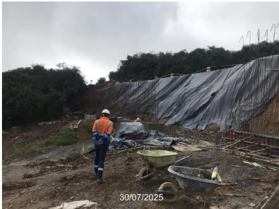
CARRETERA: BARBOSA-TUNJA(6209) SITIO: PR57+0500 DESCRIPCIÓN: SUPERVISION TRABAJOS MANTENIMIENTO RUTINARIO FECHA: 30 de julio de 2025
