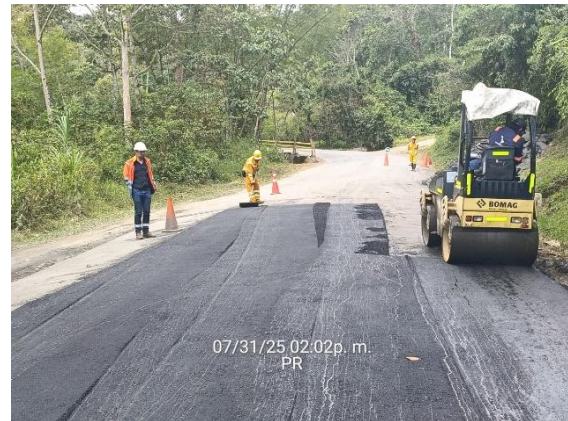
CARRETERA: OTANCHE-CHIQUEQUIRA (6007) SITIO: PR 56+0060 DESCRIPCIÓN: SUPERVISION COMPACTACION MEZCLA ASFALTICA FECHA: 31 de julio de 2025
