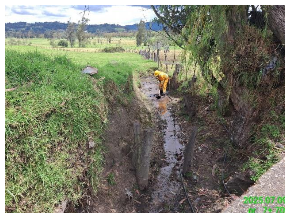
CARRETERA: CHIQUINQUIRÁ - TUNJA (6008) SITIO: PR07+0700 DESCRIPCIÓN: LIMPIEZA DESCOLES OBRAS DE DRENAJE FECHA: 09 de julio de 2025
