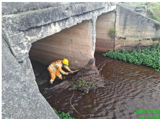
CARRETERA: CHIQUINQUIRÁ - TUNJA (6008) SITIO: PR05+0090 DESCRIPCIÓN: LIMPIEZA OBRA DE DRENAJE FECHA: 08 de julio de 2025
