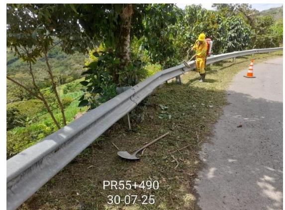
CARRETERA: OTANCHE - CHIQUINQUIRA (6007) SITIO: PR55+0490 DESCRIPCIÓN: LIMPIEZA DE DEFENSAS METÁLICAS FECHA: 30 de julio de 2025
