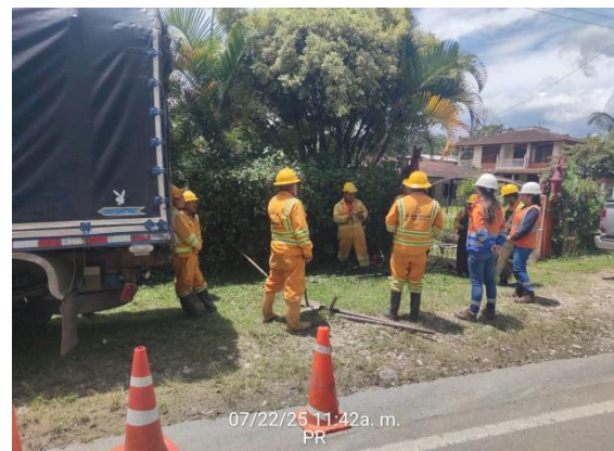
07/22/25 11:42a. m. PR CARRETERA: BARBOSA-TUNJA(6209) SITIO: PR01+0750 DESCRIPCIÓN: SUPERVISION TRABAJOS MANTENIMIENTO RUTINARIO FECHA: 22 de julio de 2025
