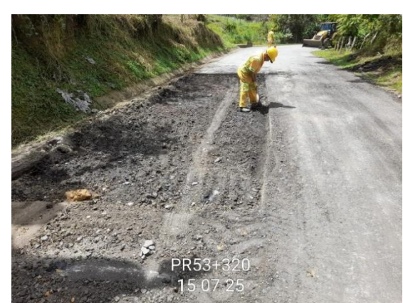
CARRETERA: OTANCHE - CHIQUINQUIRÁ (6007) SITIO: PR53+0320 DESCRIPCIÓN: CONFORMACIÓN DE CAJAS PARA PARCHEO FECHA: 15 de julio de 2025
