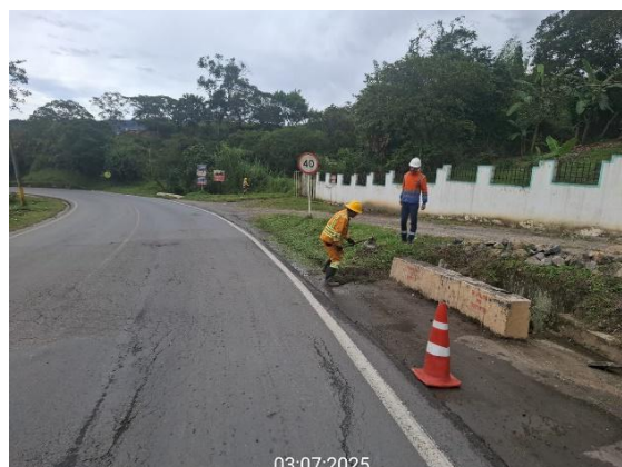
CARRETERA: BARBOSA - TUNJA (6209) SITIO: PR09+0400 DESCRIPCIÓN: SUPERVISION TRABAJOS MANTENIMIENTO RUTINARIO FECHA: 03 de julio de 2025
