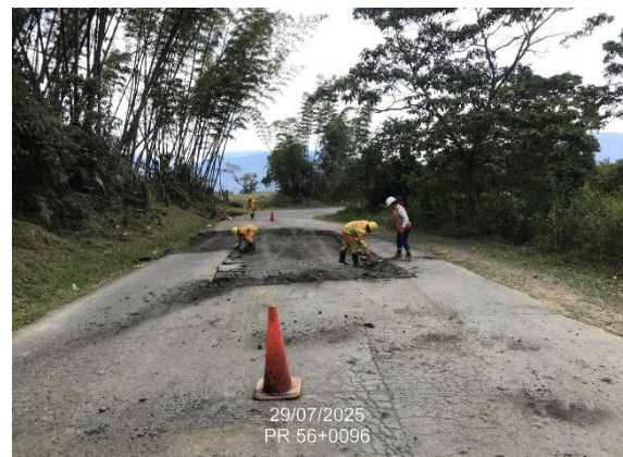
CARRETERA: OTANCHE - CHIQUINQUIRA (6007) SITIO: PR56+0096 DESCRIPCIÓN: CONFORMACIÓN DE CAJAS PARA PARCHEO FECHA: 29 de julio de 2025
