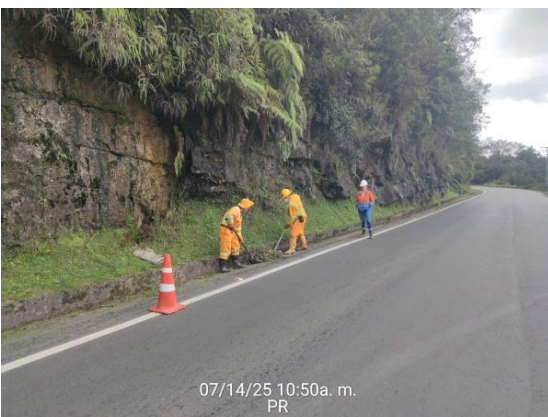
CARRETERA: BARBOSA - TUNJA (6209) SITIO: PR21+0750 DESCRIPCIÓN: SUPERVISIÓN TRABAJOS MANTENIMIENTO RUTINARIO FECHA: 14 de julio de 2025
