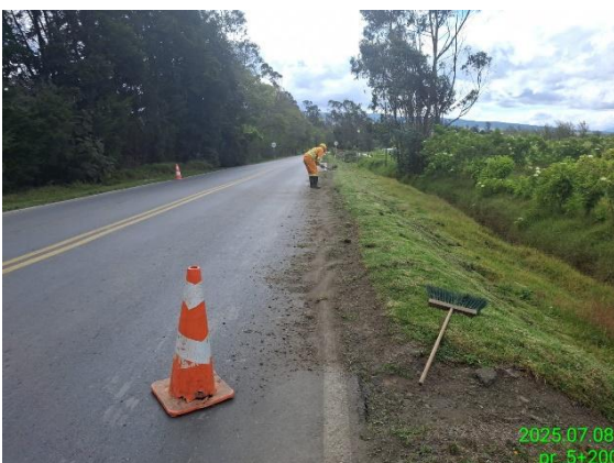
CARRETERA: CHIQUINQUIRÁ - TUNJA (6008) SITIO: PR05+0200 DESCRIPCIÓN: CONFORMACIÓN DE CUNETA EN TIERRA FECHA: 08 de julio de 2025
