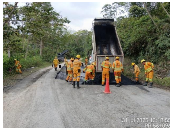
CARRETERA: OTANCHE - CHIQUINQUIRA (6007) SITIO: PR56+0096 DESCRIPCIÓN: INSTALACIÓN MEZCLA ASFÁLTICA FECHA: 31 de julio de 2025
