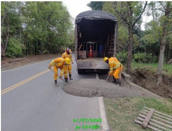
CARRETERA: CHIQUINQUIRÁ - TUNJA (6008) SITIO: PR23+0480 DESCRIPCIÓN: LIMPIEZA DE CALZADA FECHA: 24 de julio de 2025
