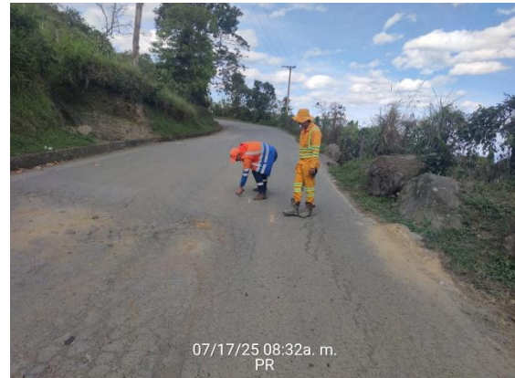
CARRETERA: OTANCHE - CHIQUINQUIRA (6007) SITIO: PR57+0000 DESCRIPCIÓN: DEMARCACIÓN PARA CORTE ASFALTO FECHA: 17 de julio de 2025
