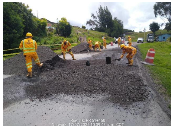
CARRETERA: BARBOSA-TUNJA (6209) SITIO: PR51+0450 DESCRIPCIÓN: RENIVELACIÓN PUNTO CRITICO FECHA: 17 de julio de 2025
