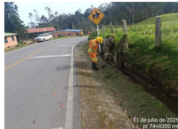
CARRETERA: OTANCHE - CHIQUINQUIRÁ (6007) SITIO: PR74+0300 DESCRIPCIÓN: LIMPIEZA DE CUNETAS REVESTIDAS FECHA: 11 de julio de 2025
