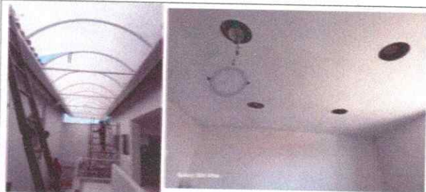
FECHA FOTO: 19-02-2026 DESCRIPCIÓN: Resane, estuco, pintura e instalacion de paneles led.
