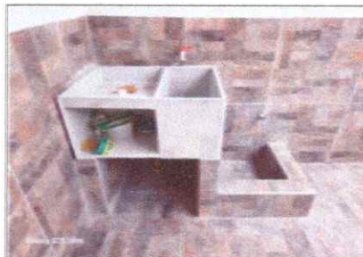
FECHA FOTO: 26-04-2026. DESCRIPCIÓN: Enchape piso y pared patio e instalacion lavadero.
