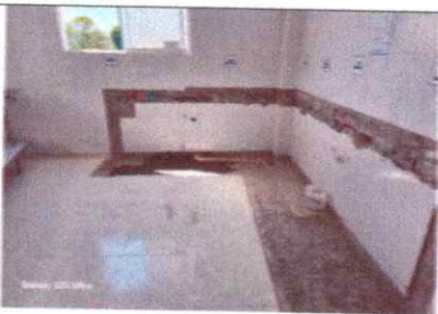
FECHA FOTO: 19-02-2026 DESCRIPCIÓN: Demolicion piso y meson existente.
