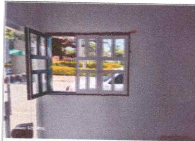
FECHA FOTO: 14-02-2026 DESCRIPCIÓN: Desmonte Ventaaas Fachada.
