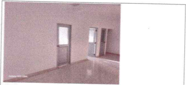
FECHA FOTO: 13-04-2026. DESCRIPCIÓN: Areas terminadas segundo nivel.
