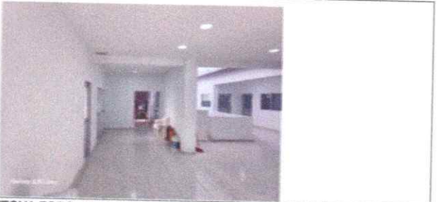
FECHA FOTO: 18-04-2026. DESCRIPCIÓN: Areas segundo nivel terminadas.
