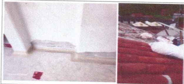
FECHA FOTO: 15-02-2026 DESCRIPCIÓN: Resane Paredes y Desmonte cubierta teja existente.
