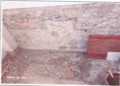
FECHA FOTO: 15-02-2026 DESCRIPCIÓN: Demolicion baldosa pisos y paredes.
