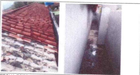
FECHA FOTO: 15-01-2026 DESCRIPCIÓN: Desmonte teja Existente
