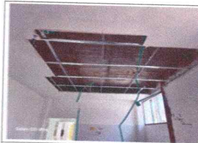
FECHA FOTO: 20-01-2026 DESCRIPCIÓN: instalacion cielo raso drainwall
