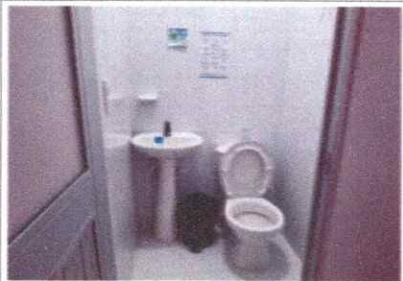
FECHA FOTO: 26-04-2026. DESCRIPCIÓN: Baño Terminando.
