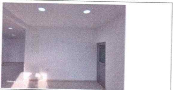
FECHA FOTO: 15-04-2026. DESCRIPCIÓN: Areas terminadas primer nivel.
