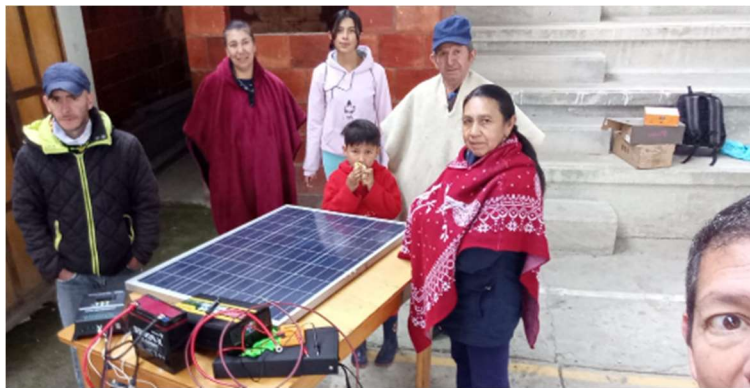
Implementación de sistemas solares fotovoltaicos autónomos ficha 3482902 Guatavita Carbonara
