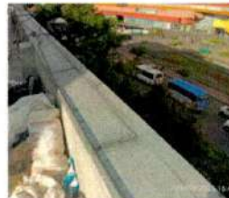
Vista de los flanches con juntas. Autoría propia, 2025.
