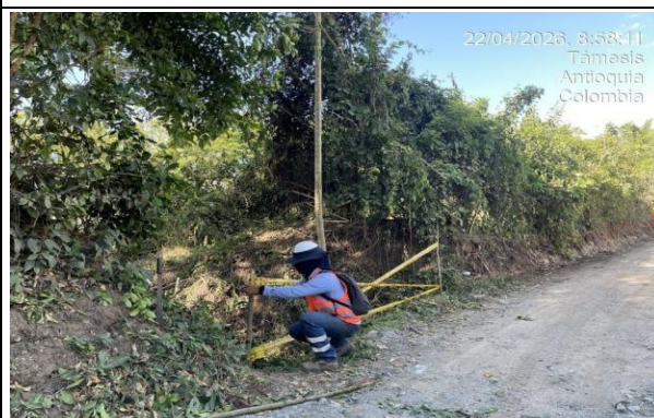
Foto 42. Señalización de puntos críticos
