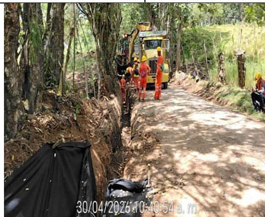
Fotografía 14 Construcción de filtro tipo francés 30/4/2026
