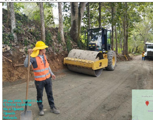
Fotografía 8 Excavación y mejoramiento de la subrasante con material adicionado tipo crudo 28/4/2026
