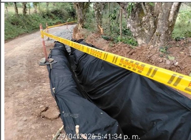
Fotografía 13 Revisión de lote de material geotextil en campo 30/4/2026
