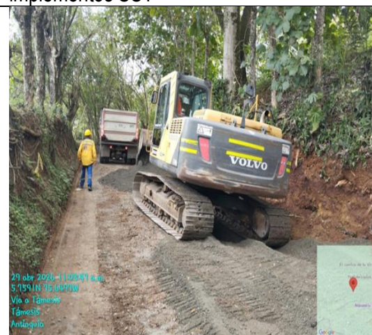
Fotografía 8 Excavación y mejoramiento de la subrasante con material adicionado tipo crudo 28/4/2026
