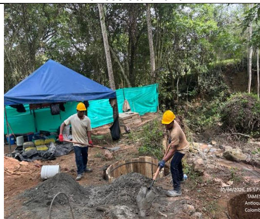
Fotografía 14 Construcción de filtro tipo francés 30/4/2026
