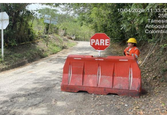
Foto 14. Punto de Control PMT PR K6+800
