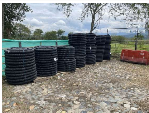
Foto 9: Zona de Acopio Campamento Contratista – 20/03/2026
