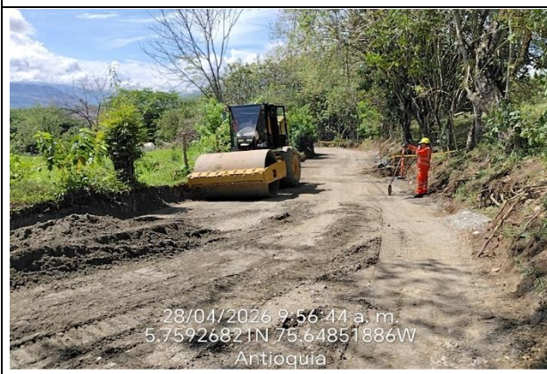
Fotografía 7 Excavación y mejoramiento con material adicionado 27/4/2026
