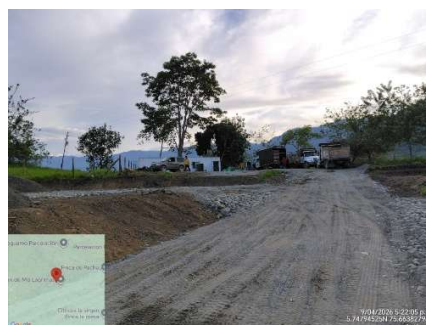
Foto 12: Campamento de obra contratista
