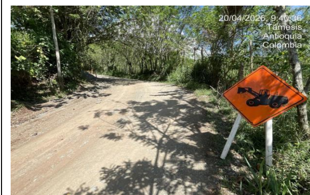
Foto 37. Instalación de PMT
