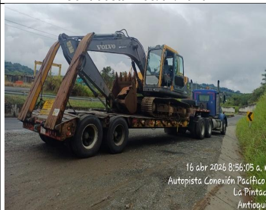
Fotografía 4 Traslado de equipo al frente de trabajo 16/4/2026
