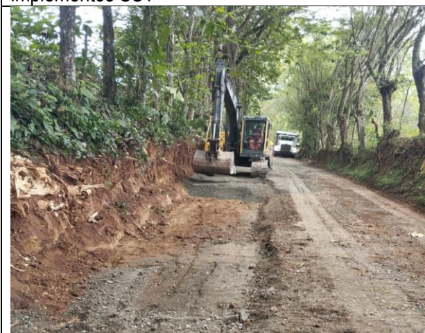
Fotografía 7 Excavación y mejoramiento con material adicionado 27/4/2026
