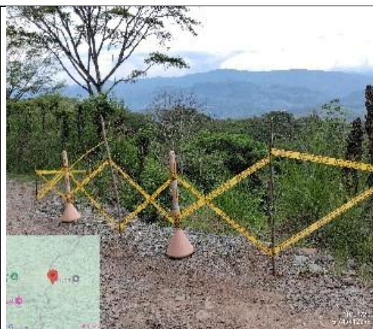
Fotografía 2 Señalización en obra Contratista – 09/04/2026
