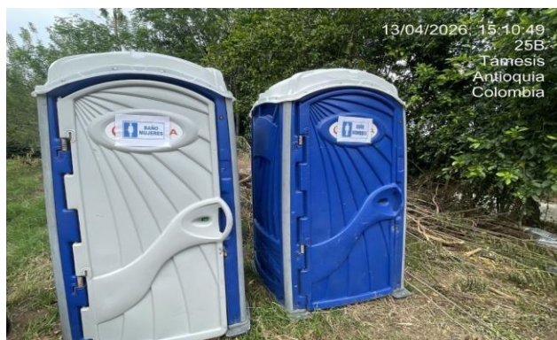
Foto 13. Instalación de Unidades Sanitarias en el PR K6+400.
