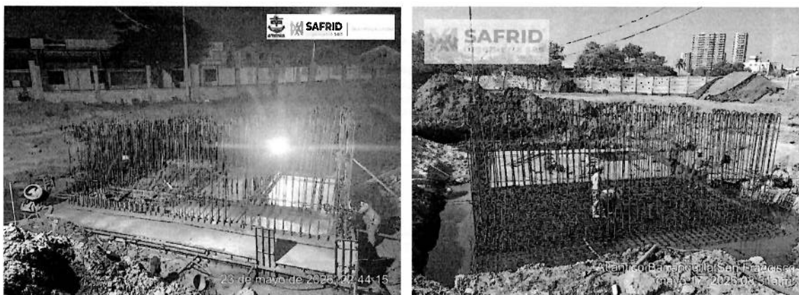
Figura 1 y 2. Armado de tanque
