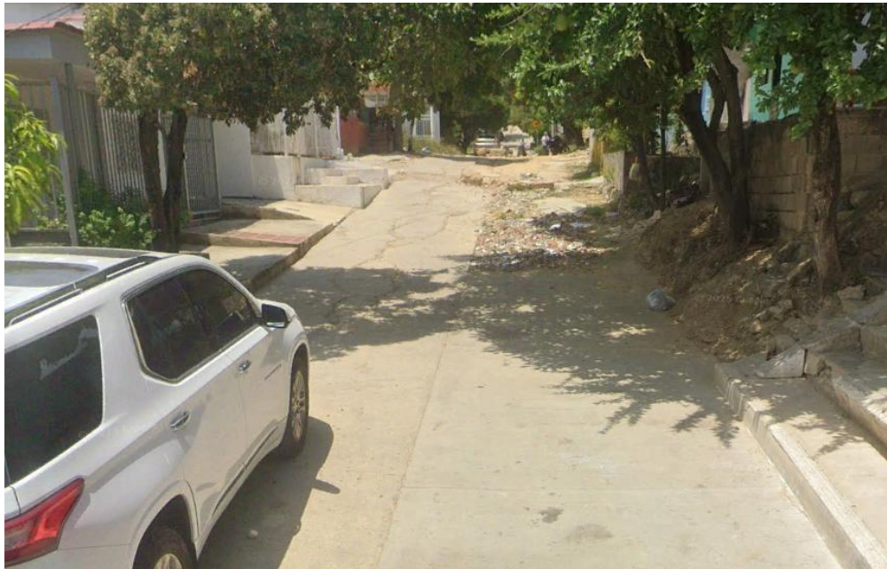
Imagen 11. Calle 8 entre carrera 3 y 5
