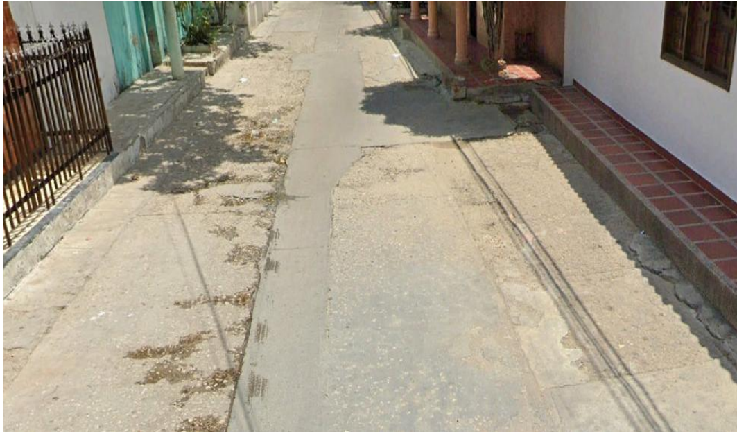
Imagen 13. Calle 8 entre carrera 9 y 10
