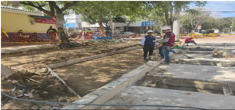
ADECUACION TERRENO PARA CONCRETO BAHIA PARQUEADEROS CRA 45
