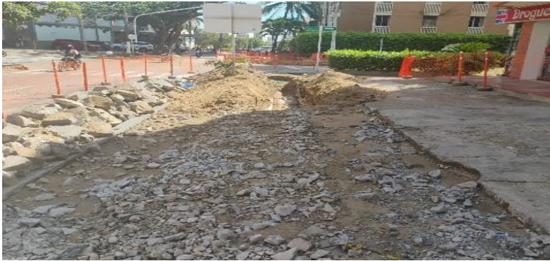
EXCAVACION PARA INSTALACION DE TUBERIA DE BANCO DE DUCTOS ENTRE CRAS 58 Y 57
