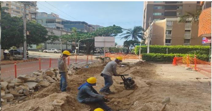
COMPACTACION TERRENO SOBRE TUBERIA DE BANCO DE DUCTOS ENTRE CRAS 58 Y 57
