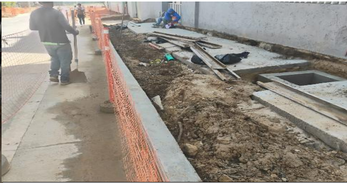
FUNDIDA BORDILLO AMPLIACION VIA ENTRE CRAS 59B Y 59
