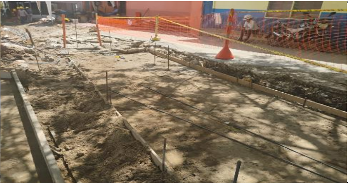
ADECUACION TERRENO PARA PLANTILLA ANDEN CRA 45
