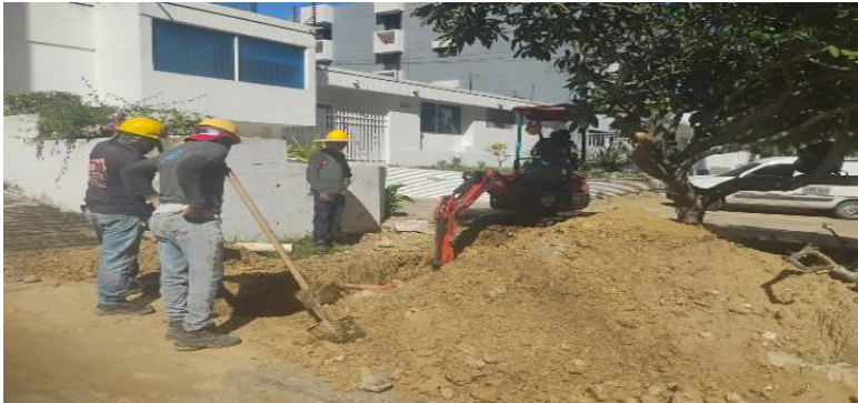
EXCAVACION PARA INSTALACION DE TUBERIA DE BANCO DE DUCTOS CRA 47 ENTRE CALLES 85 Y 86
