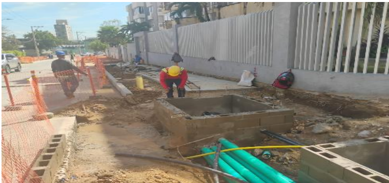
CONSTRUCCION DE REGISTRO DE BANCO DE DUCTOS ENTRE CRAS 59B Y 59
