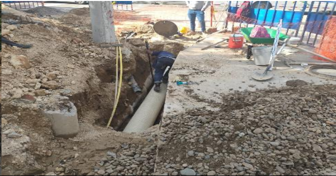
INSTALACION TUBERIA DE ALCANTARILLADO ENTRE CRAS 59B Y 59
