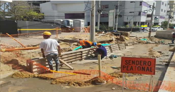
COLOCACION FORMALETA PARA BORDILLOS VIA ENTRE CRAS 46 Y 47
