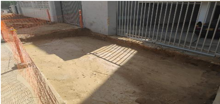
ADECUACION TERRENO PARA RAMPA ACCESO A PREDIOS ENTRE CRAS 59B Y 59
