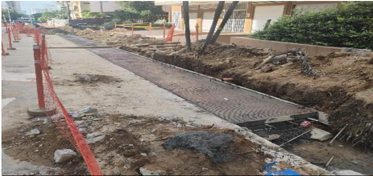
FUNDIDA AMPLIACION VIA ENTRE CRAS 59 Y 58
