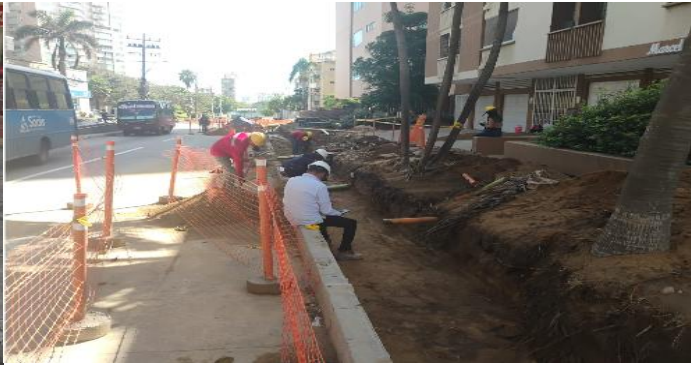
ADECUACION TERRENO PARA AMPLIACION VIA ENTRE CRAS 59 Y 58
