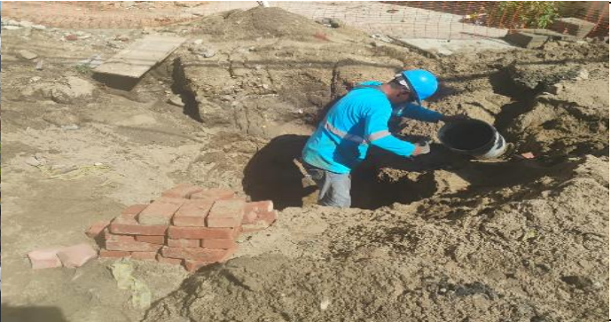
CONSTRUCCION DE REGISTRO DOMICILIARIO ALCANTARILLADO CRA 45
