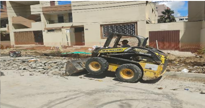
LIMPIEZA DE OBRA CRA 45
