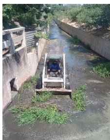
Limpieza y retiro de residuos sólidos sobre el canal entre K0+000 a K0+120 Afluente 3.
