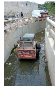
Limpieza y retiro de residuos sólidos sobre el canal entre K0+560 a K0+678 Tramo principal.
