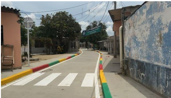
CALLE 98C ENTRE CARRERAS 7B Y 7E - LAS MALVINAS
