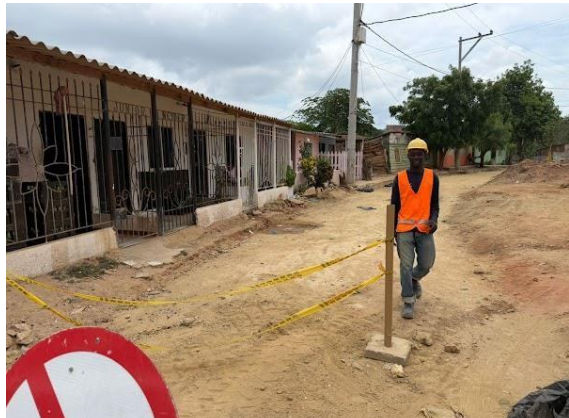
CALLE 72C ENTRE CARERAS 15G Y 15F - LA ESMERALDA
