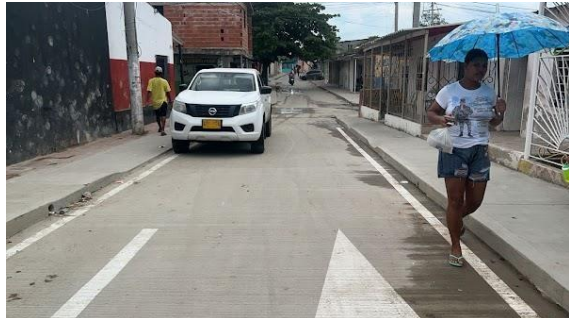
CALLE 97 ENTRE CARRERAS 8 Y 8C - LAS MALVINAS
