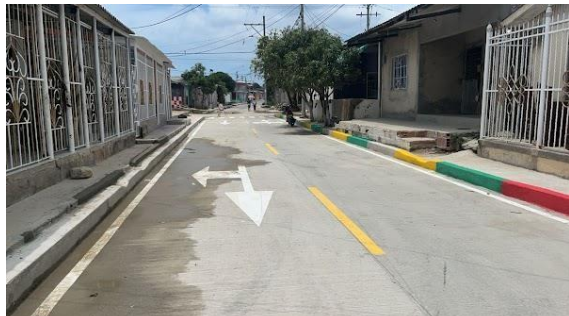
CALLE 99C ENTRE CARRERAS 7B Y 8E - LAS MALVINAS
