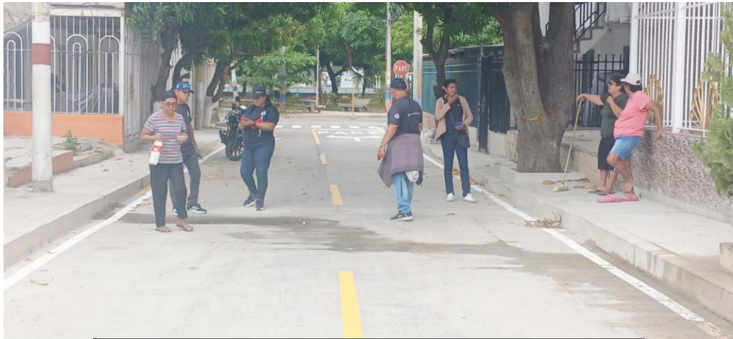
CALLE 35A ENTRE CARRERAS 5B Y 6B (RECONSTRUCCION) CARRERA 6 ENTRE CALLES 35A y 36B (Reconstrucción)
