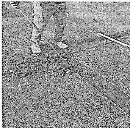
Apique de verificación estado de base y sub base del pavimento asfáltico
