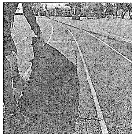
Desprendimiento del tapete sintético, pérdida de adherencia entre capas, fisuración reflejada, cristalización del material y pérdida de cohesión del sistema
