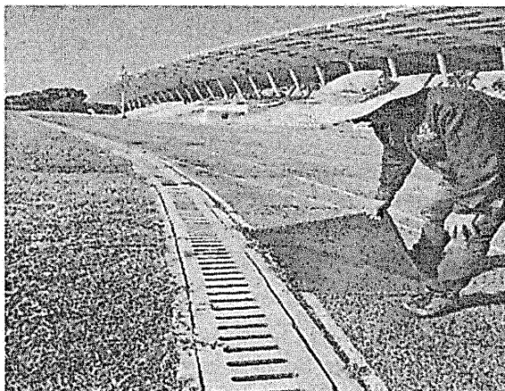
Desprendimiento del tapete sintético, pérdida de adherencia entre capas, fisuración reflejada, cristalización del material y pérdida de cohesión del sistema
