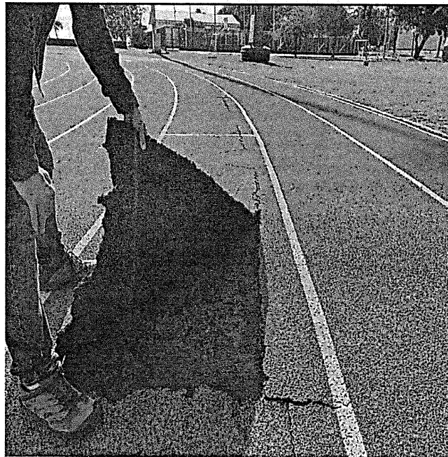
Imagen7. Inspección visual y manual. Imagen tomada del informe de INFORME TÉCNICO – JUSTIFICACIÓN DE REPOSICIÓN TOTAL DE PISTA DE ATLETISMO. Localización: Pista de atletismo ENAP
