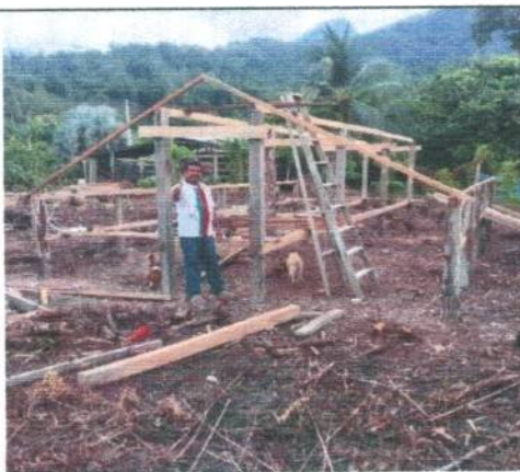
Ilustración 3 .Construcción de beneficiaderos de cacao. Vereda Nazareth
