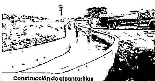
Construcción de alcantarillas
