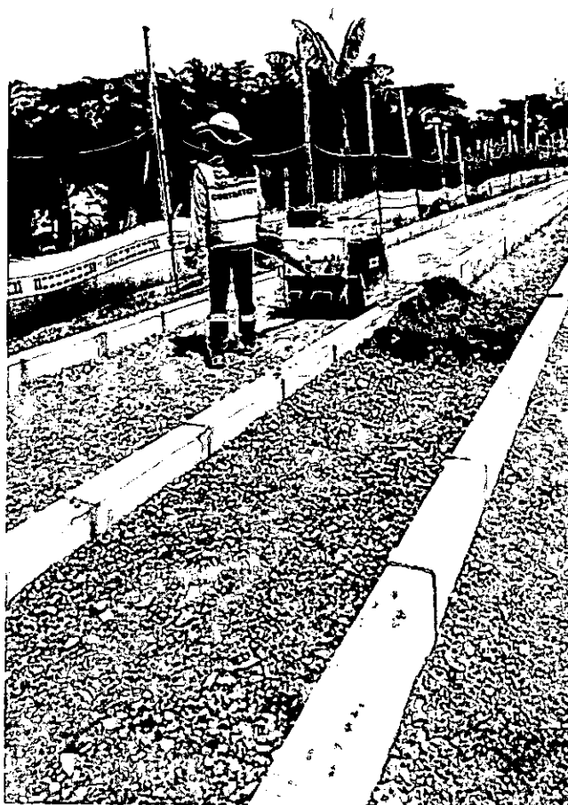
Imagen 10. Instalación de Sardineles y Conformación de cicloruta y zonas peatonales
