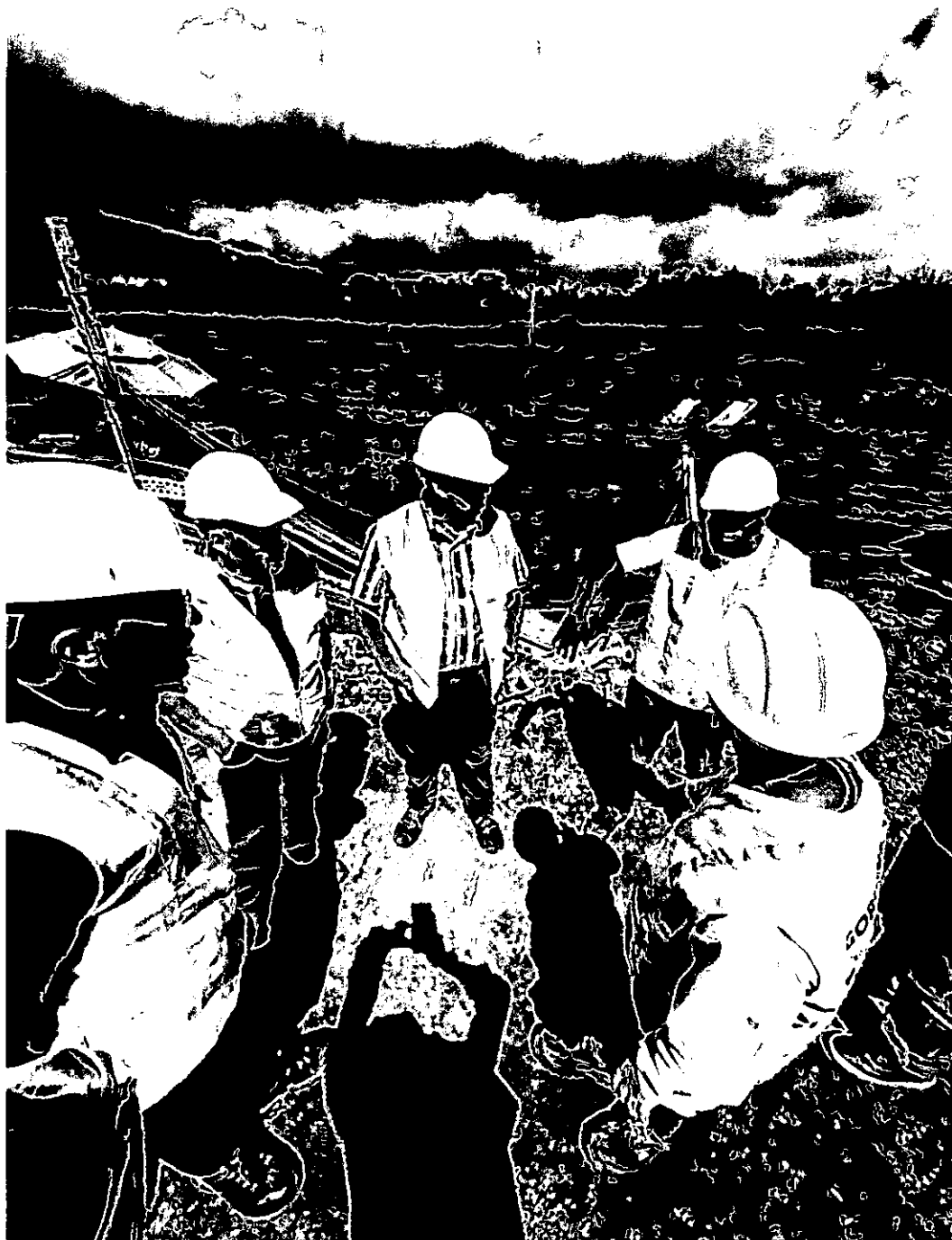
Comité de seguimiento en obra
