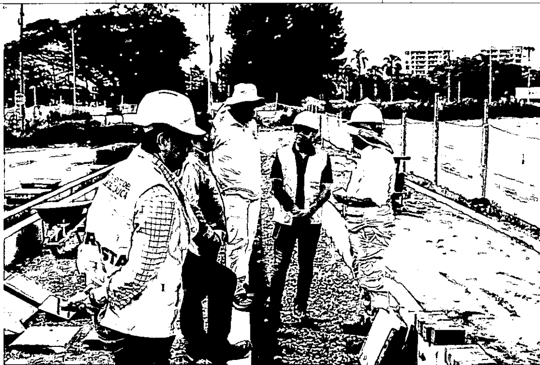
Comité de seguimiento en obra
