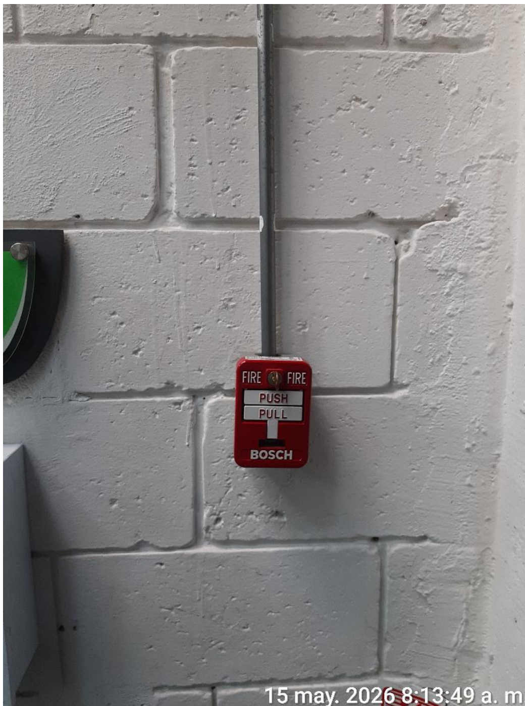
Foto 19. Verificación de los sistemas de seguridad (alarma contra incendios) en cumplimiento de la obligación 15 del contrato.
