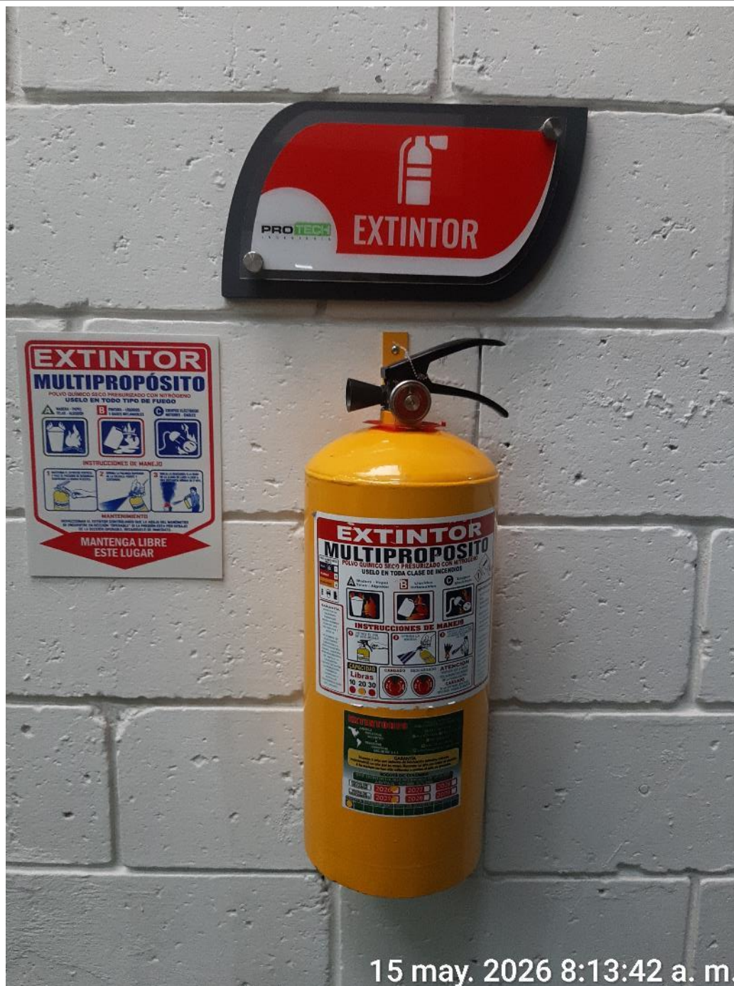
Foto 16. Verificación de los sistemas de seguridad (extintor), en cumplimiento de la obligación 15 del contrato.
