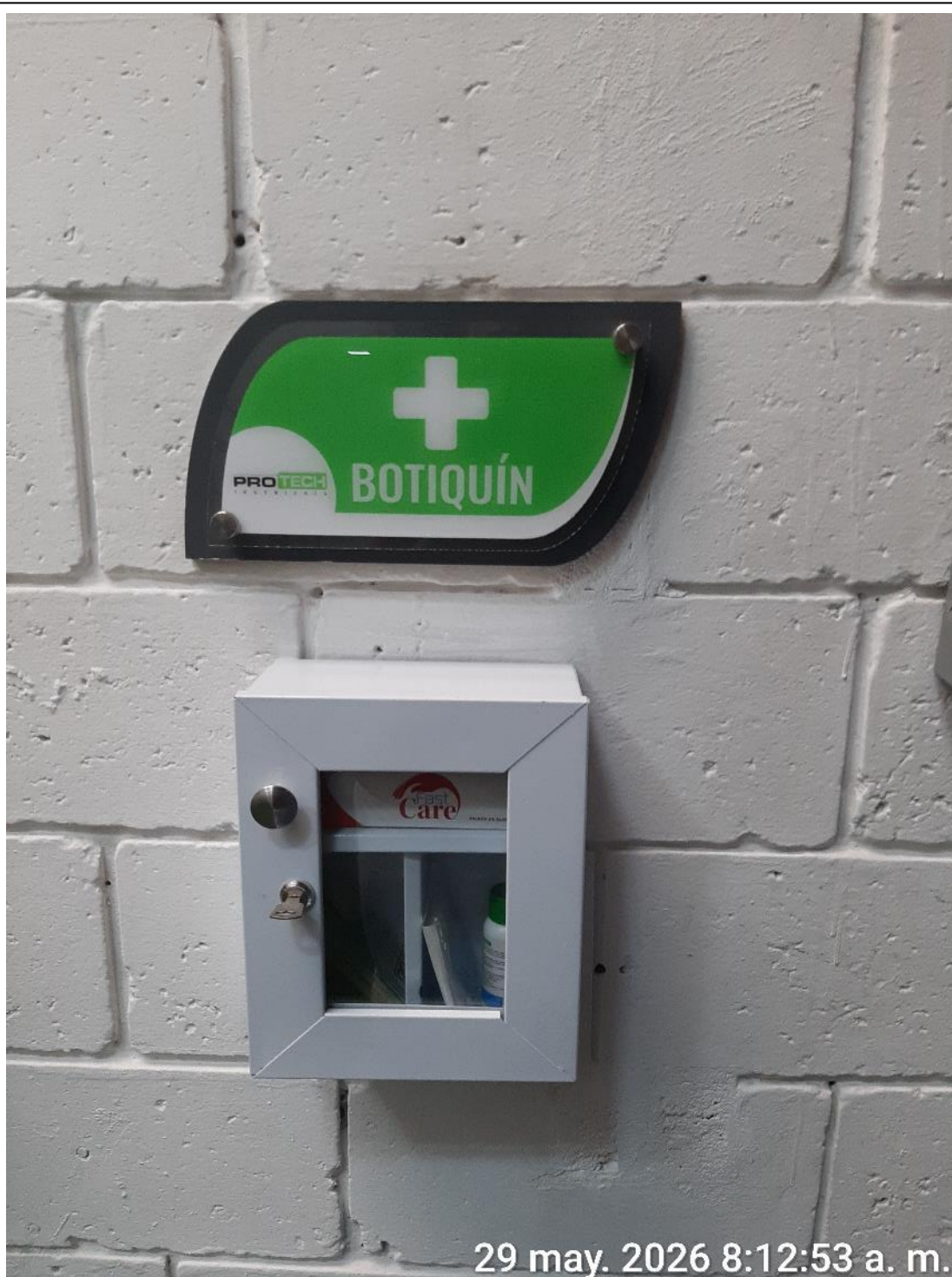
Foto 23. Verificación de los sistemas de seguridad (botiquín), en cumplimiento de la obligación 15 del contrato.
