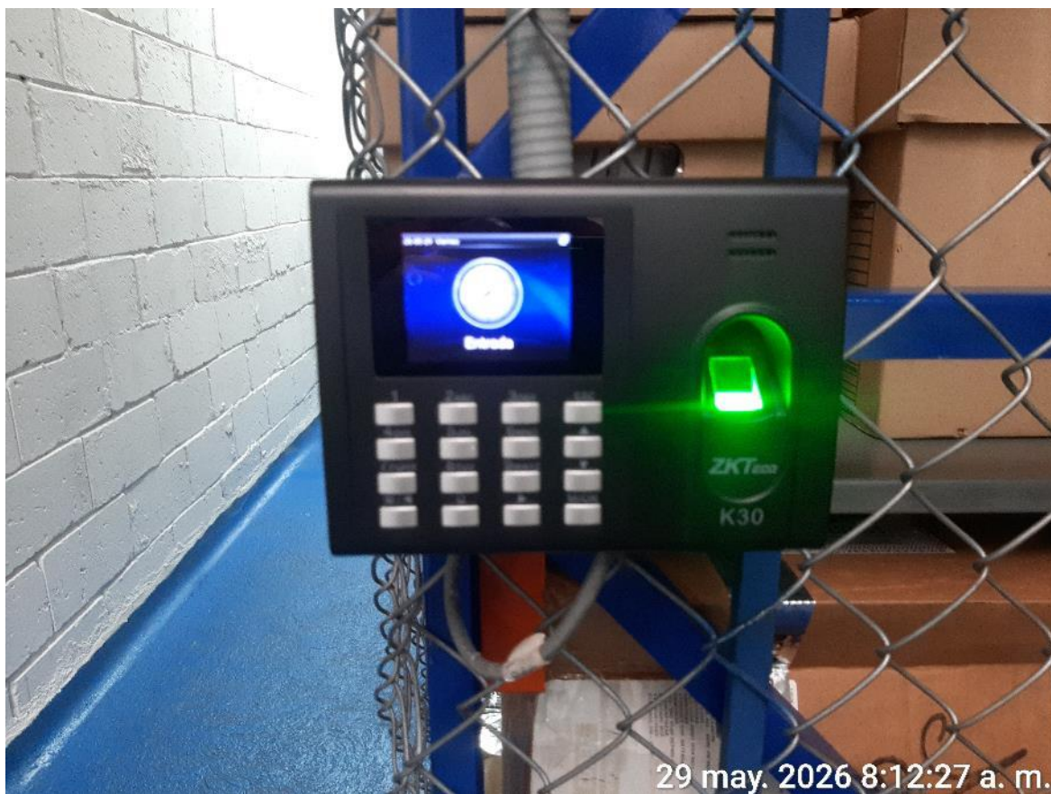
Foto 15. Verificación de los sistemas de seguridad (ingreso), en cumplimiento de la obligación 15 del contrato.
