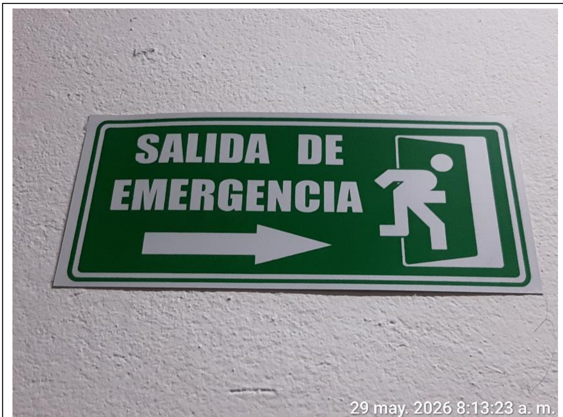
Foto 22. Verificación de los sistemas de seguridad (señalización), en cumplimiento de la obligación 15 del contrato.
