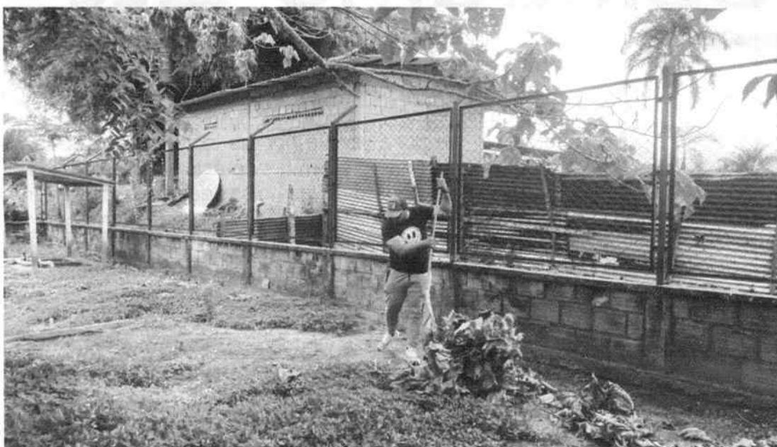
Se realiza limpieza de la zona de la PTAR como el barrido de hojas
