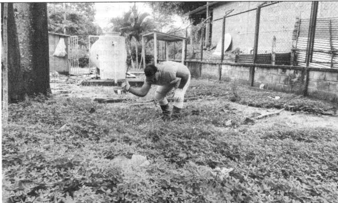
Se realizo la limpieza y poda de la maleza en PTAR manualmente
