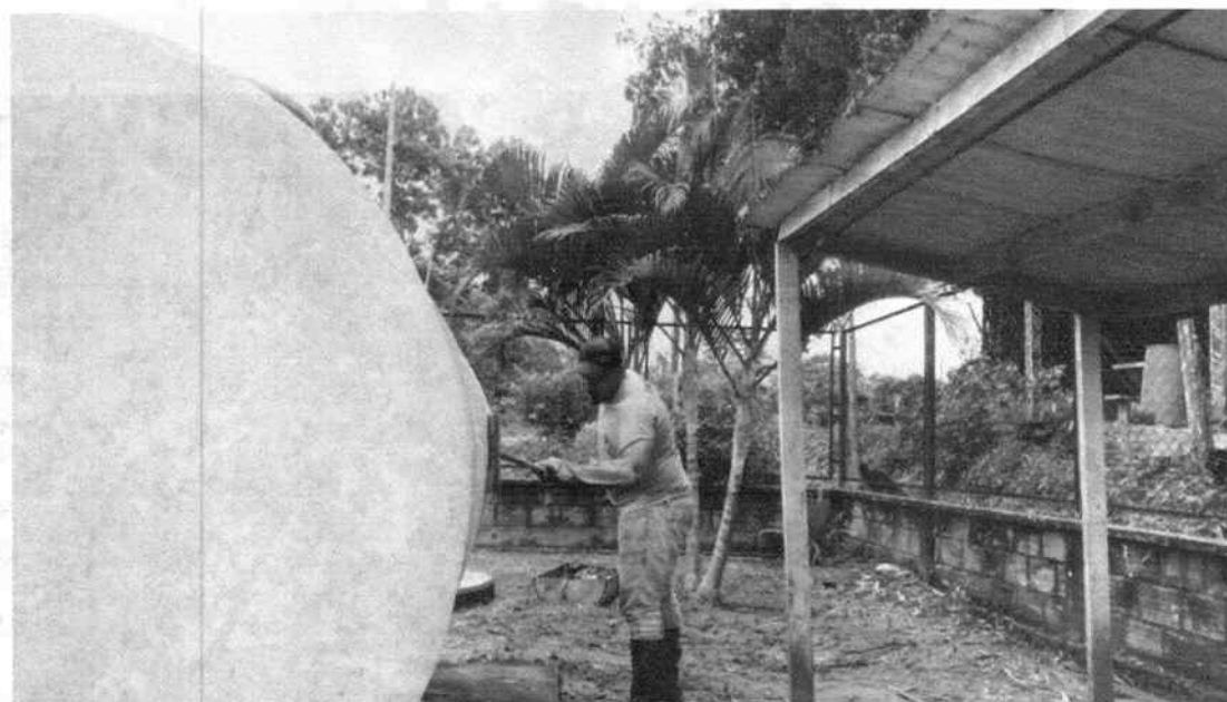
Lavado del tanque de aireación con el fin de remover lama, musgo para evitar la concentración de malos olores
