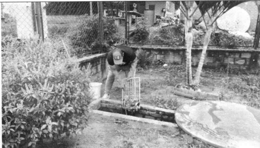
Limpieza y lavado de rejillas del sistema de cribado
