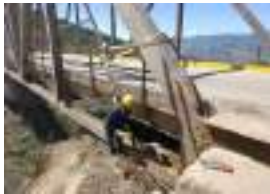
Limpieza abrasiva para estructura metálica
