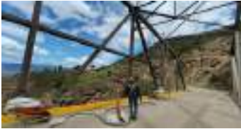
Limpieza abrasiva para estructura metálica
