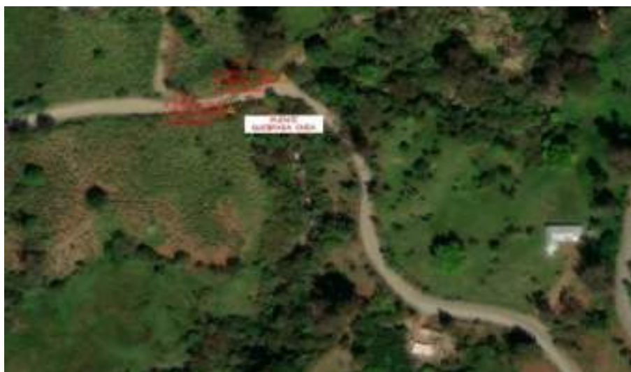
Puente Quebrada La Honda – Municipio de Buenavista – Provincia de Occidente
