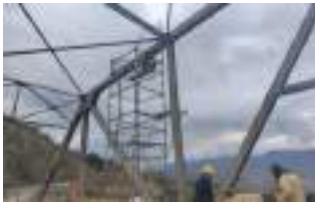
Limpieza abrasiva para estructura metálica
