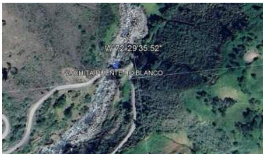
Puente de Lo Blanco – Municipio de Chita – Provincia de Valderrama
