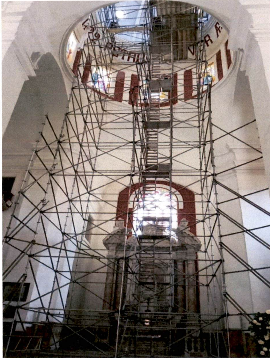
Ilustración 13: Realización de desmontaje de andamios
