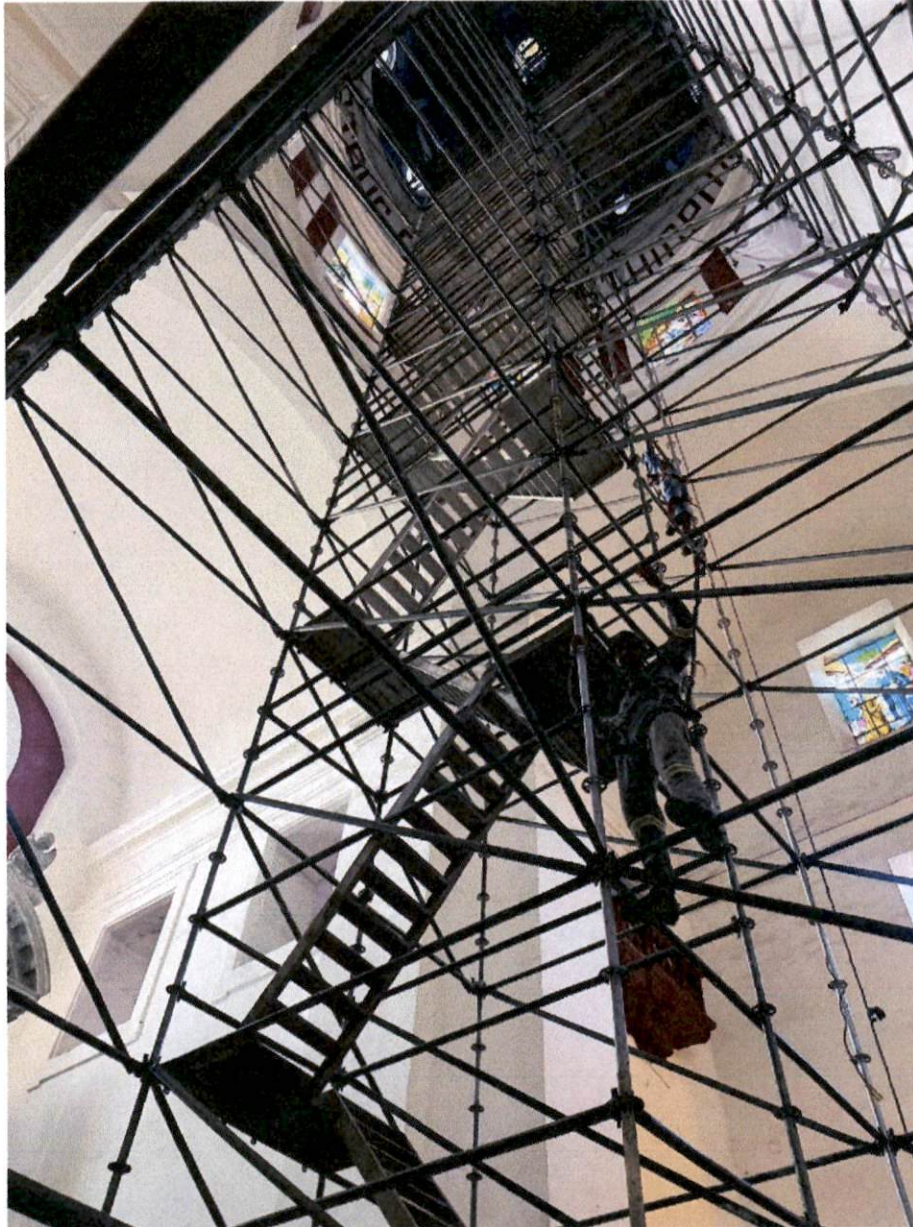
Ilustración 02: Realización de montaje de andamios
