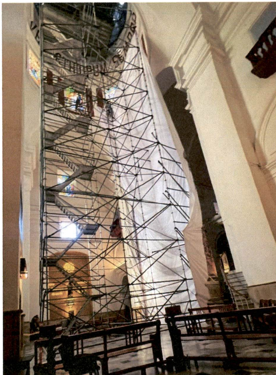
Ilustración 09: Realización de IMPRESIÓN Y MONTAJE FOTOGRAFICO
