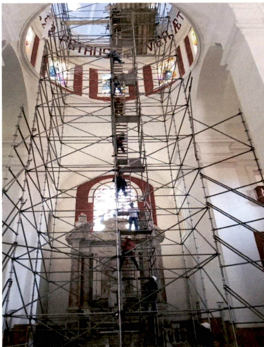
Ilustración 15: Realización de desmontaje de andamios
