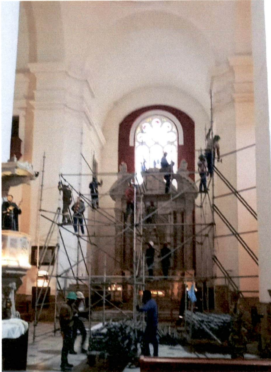
Ilustración 17: Realización de desmontaje de andamios
