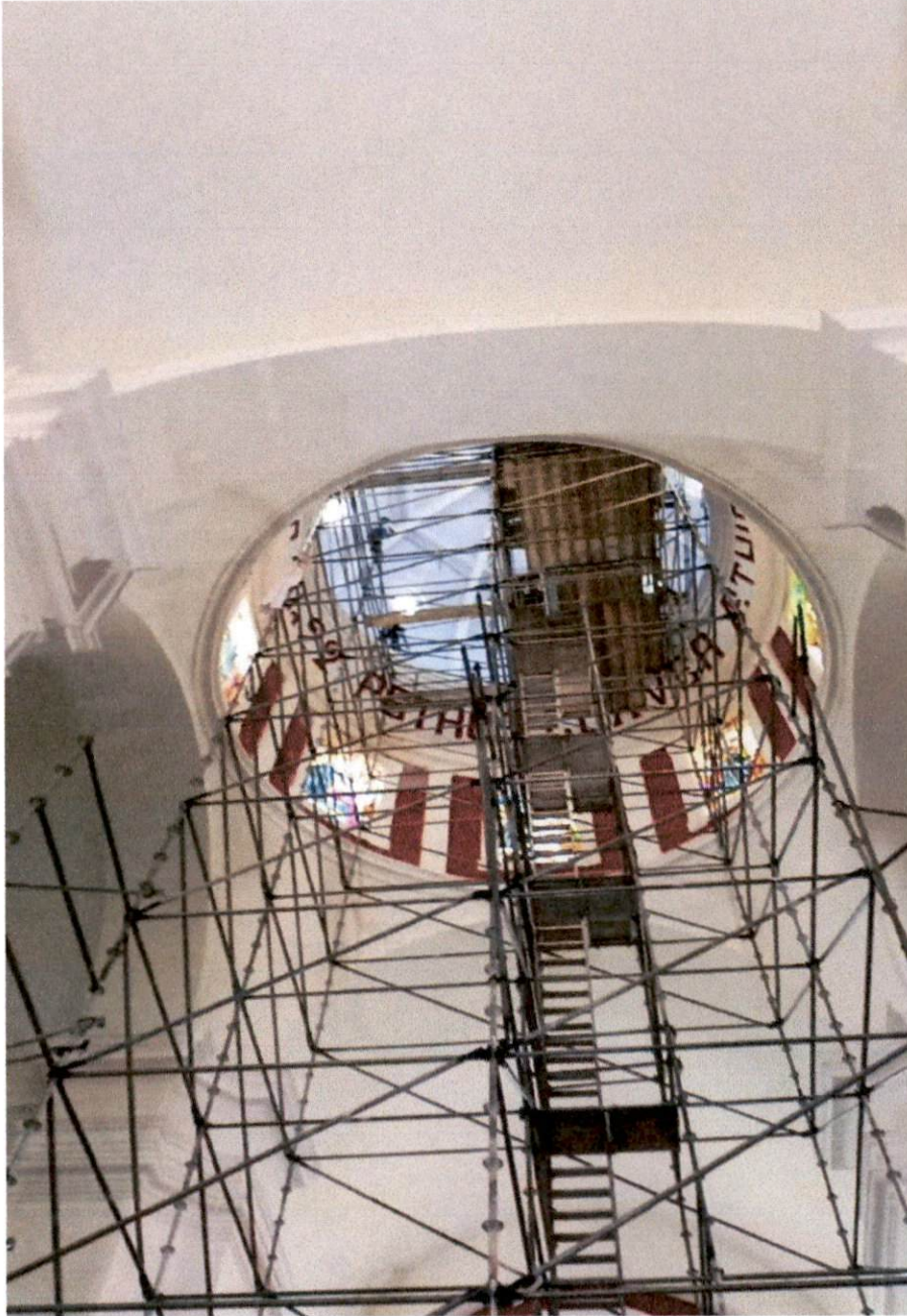
Ilustración 14: Realización de desmontaje de andamios
