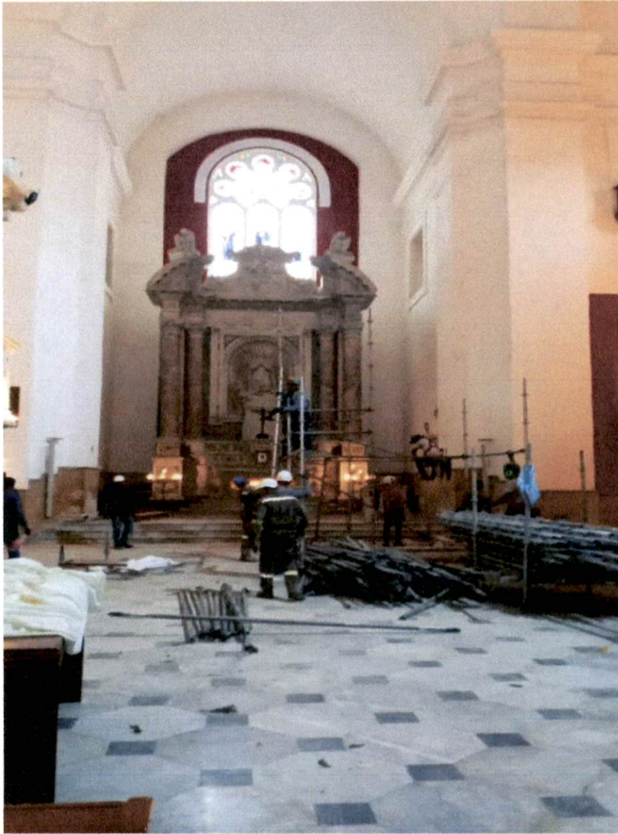
Ilustración 16: Realización de desmontaje de andamios
