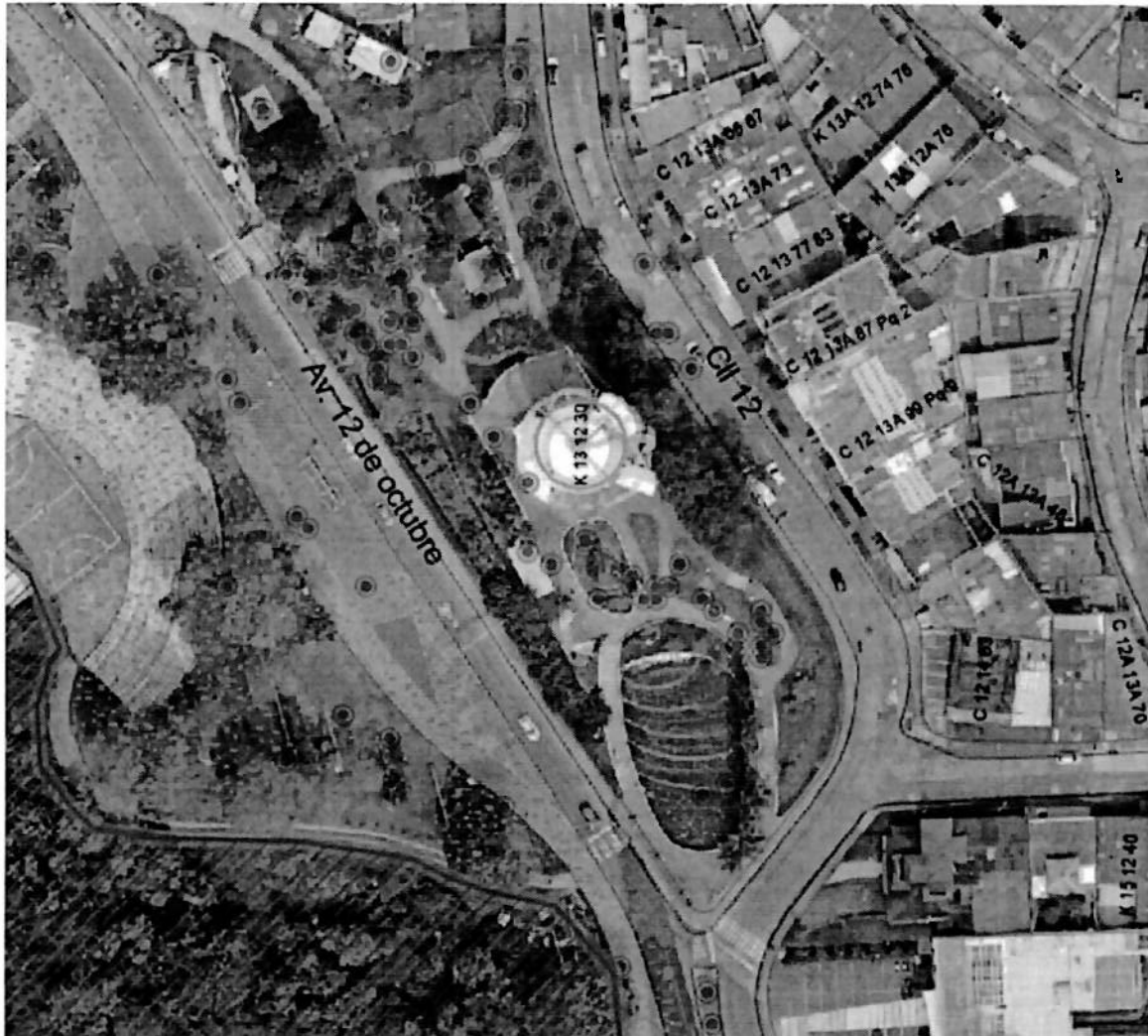
Figura 1.1. Ortofoto Torre de Chipre.
