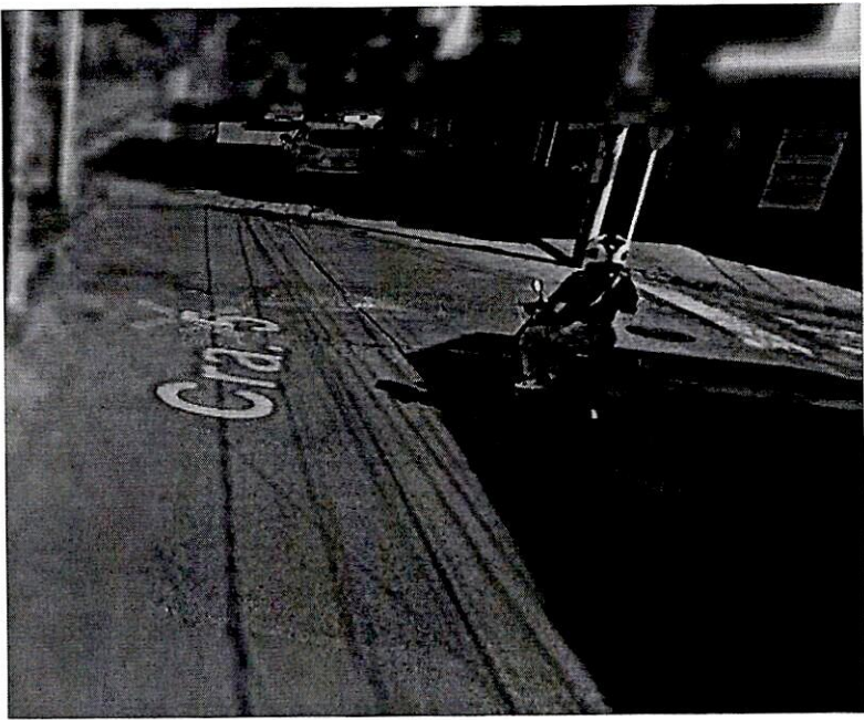
Imagen 2. Cra 5-Calle 8ª intersección
