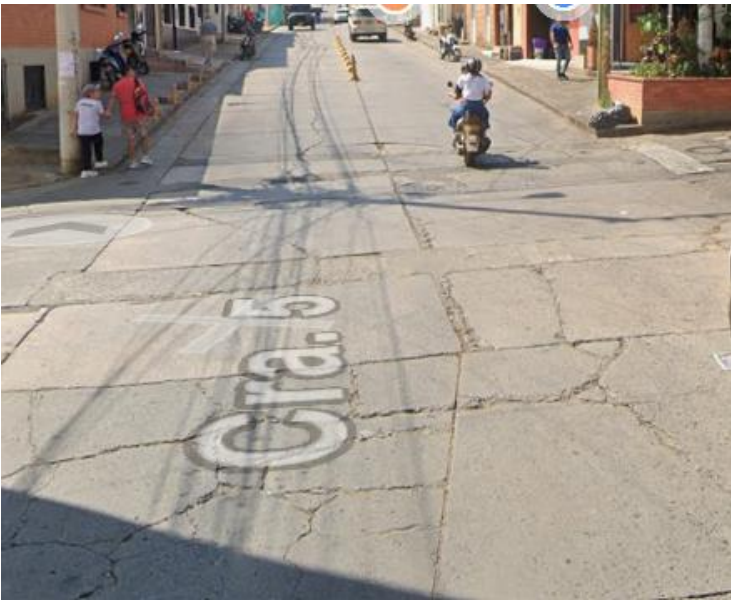
Imagen 1. Cra 5-Calle 5 intersección
