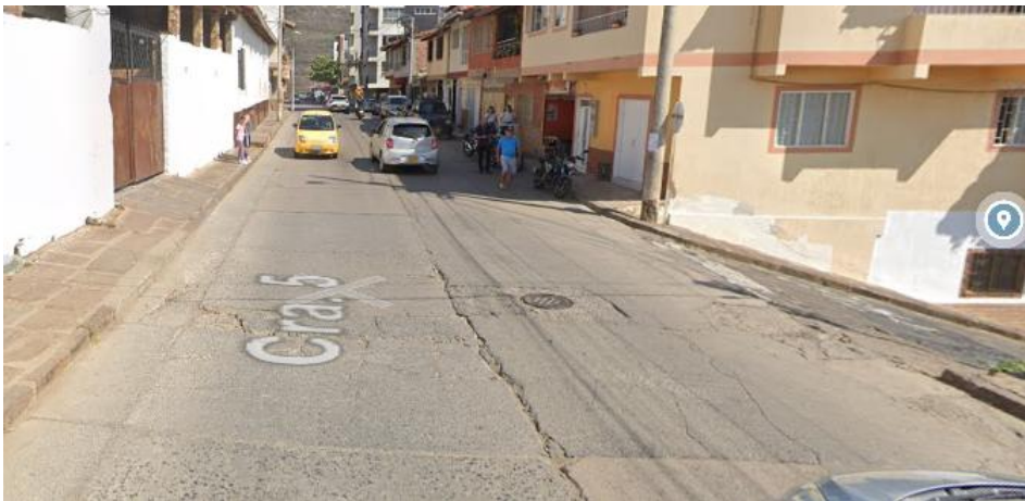
Imagen 3. Cra 5-Calle 9 intersección
