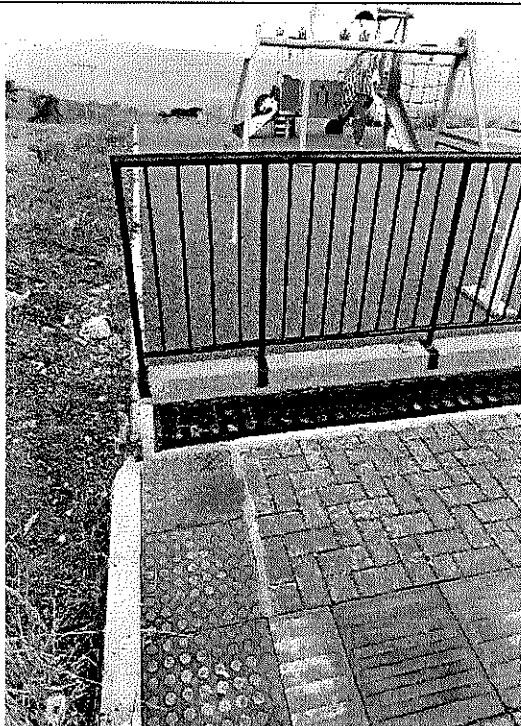
FOTOGRAFÍA 27 – AMOJONAMIENTO SOLICITADO PARA EL INICIO DE LA TOPOGRAFIA
