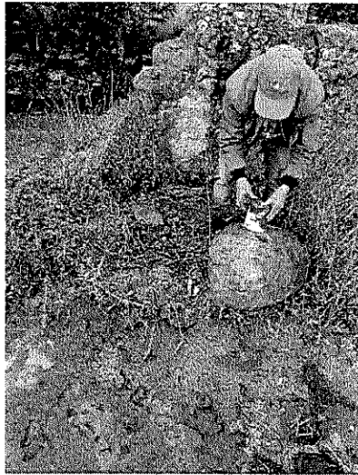
FOTOGRAFÍA 15 – AMOJONAMIENTO SOLICITADO PARA EL INICIO DE LA TOPOGRAFIA
