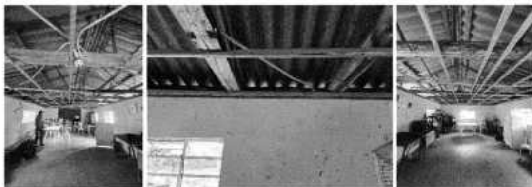
DESMONTE DE CIELO FALSO EN MADERA, (NO INCLUYE DESMONTE DE ESTRUCTURA). (INCLUYE RETIRO Y ACARREO LIBRE HASTA 5 KM.)
