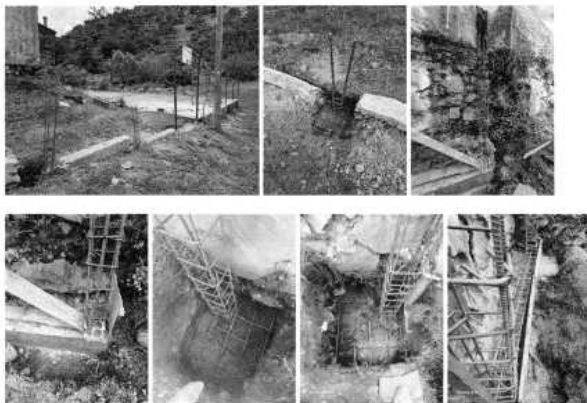
SUMINISTRO FIGURADO Y ARMADO DE ACERO DE REFUERZO 60000 PSI 420 MPA
