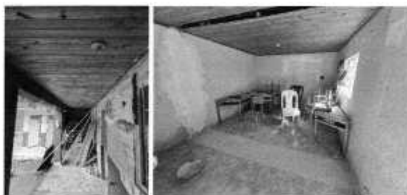
DESMONTE CUBIERTAS TEJA DE ASBESTO Y/ O ASBESTO CEMENTO. (INCLUYE RETIRO - ACARREO LIBRE HASTA 5 KM.)
