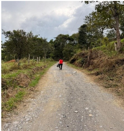
Punto inicial K5+319 ( 74^{\circ}17'19.10''\text{O} 5^{\circ}0'40.08''\text{N} ) Tramo sin obras de drenaje, con una pendiente aproximada de 5.5%.
