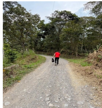
Punto intermedio K5+349 74^{\circ}17'19.93''\text{O} 5^{\circ}0'39.56''\text{N} , tramo sin obras de arte con poco recebo difícil acceso
