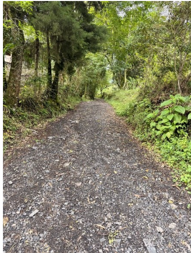
Punto inicial K4+197 ( 74^{\circ}17'1.20''W 4^{\circ}56'29.10''N ) Tramo sin obras de drenaje, con una pendiente aproximada de 5.5%.
