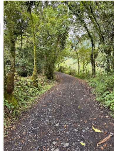
Punto intermedio K4+237 74^{\circ}17'1.47''O 4^{\circ}56'28.50''N , tramo sin obras de arte con poco recebo difícil acceso
