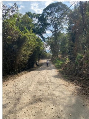
K2+797 74°16'52.07"W 4°59'11.87"N Punto intermedio afirmado en buen estado no contiene obras de arte ni
