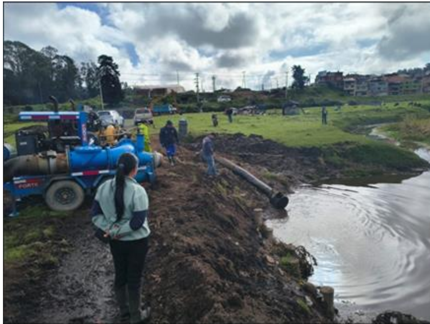
Fotografía 10. Vista cercana del punto de ruptura con pilotes y material de protección, utilizada como referencia del trabajo de encajonamiento del boquete. Fuente: propia.
