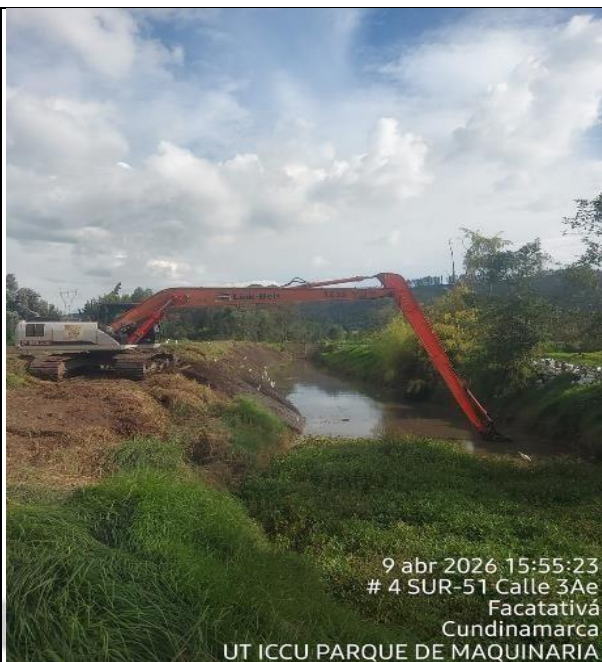
Extracción de material vegetal y material colmatado de río
