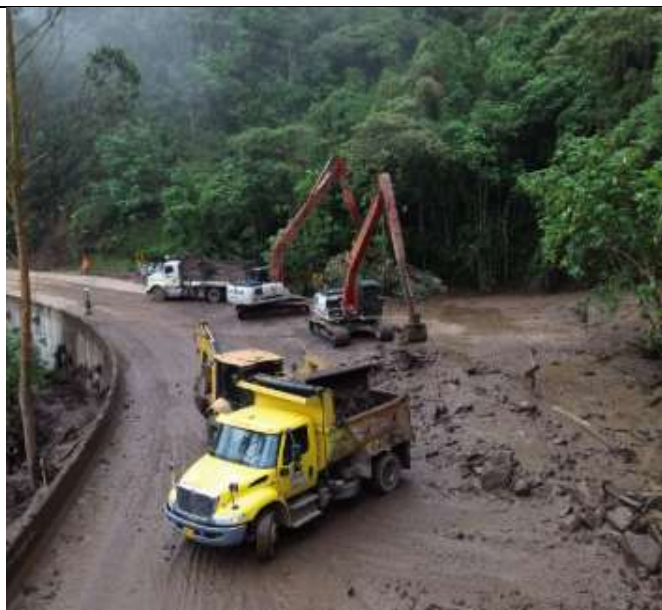
Cargue de material
