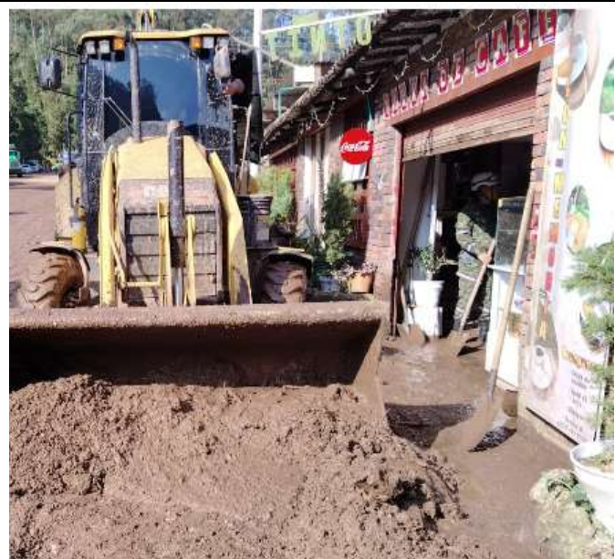
Limpieza de andenes
