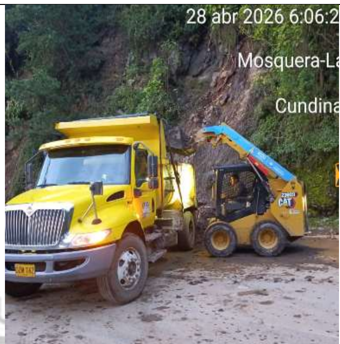
Cargue de material
