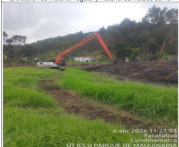
Conformación de jarillon.
