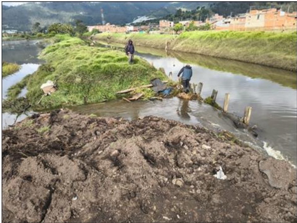
Fotografía 6. Descarga de la línea de bombeo y personal de apoyo en un tramo del borde intervenido, con lámina de agua todavía presente en el área de inundación.
