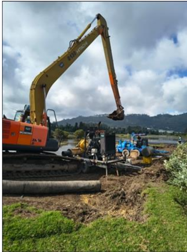
Fotografía 12. Vista general de la excavadora y de los equipos de apoyo en la zona intervenida, durante labores de perfilado, soporte a boquetes y restitución del jarillón.
