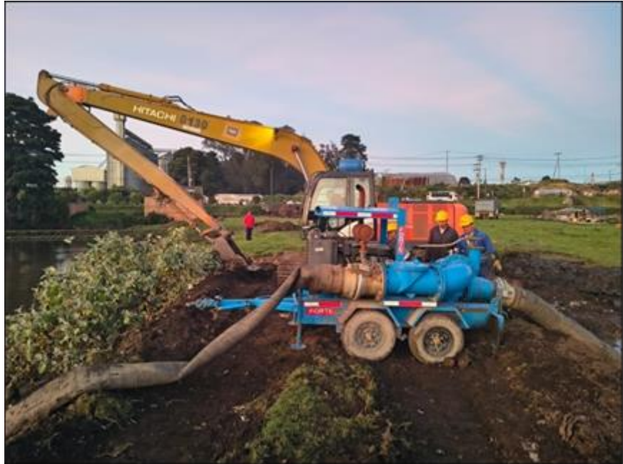
Fotografía 5. Vista lateral de la excavadora y de una unidad de bombeo en la zona de trabajo, evidenciando la articulación entre intervención mecánica y motobombeo.
