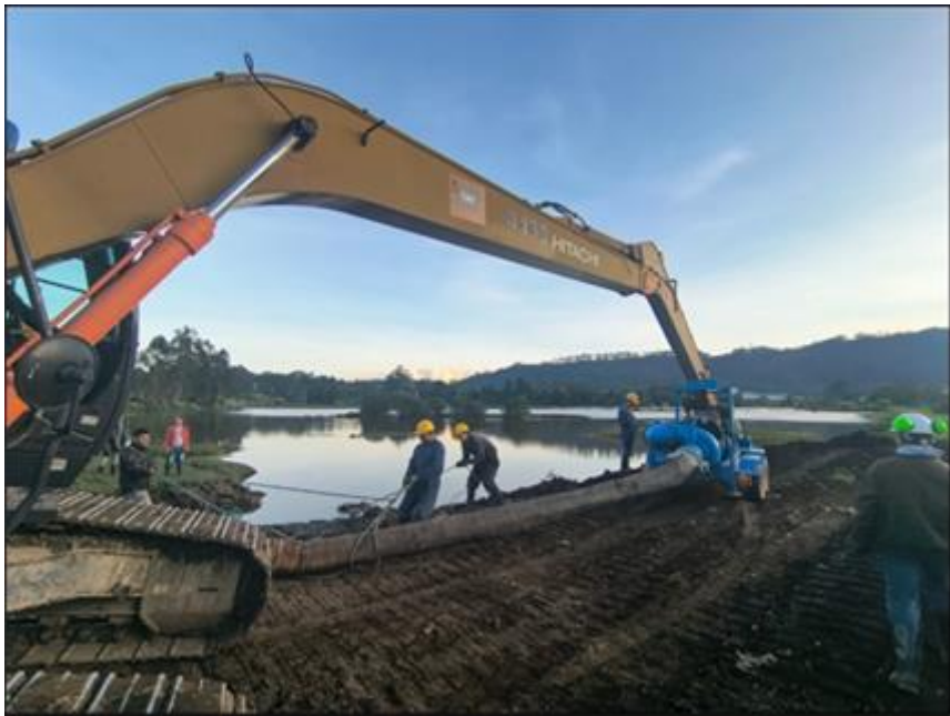
Fotografía 4. Operación conjunta de excavadora sobre orugas y equipo de bombeo en el borde del área inundada, durante maniobras de abatimiento de lámina de agua y apoyo a la estabilización del sector.
