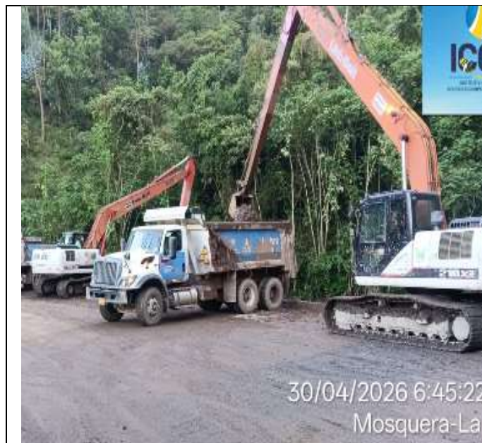
Cargue de material
