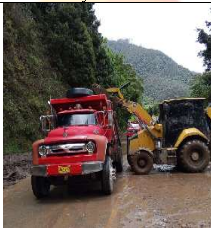
Cargue de material
