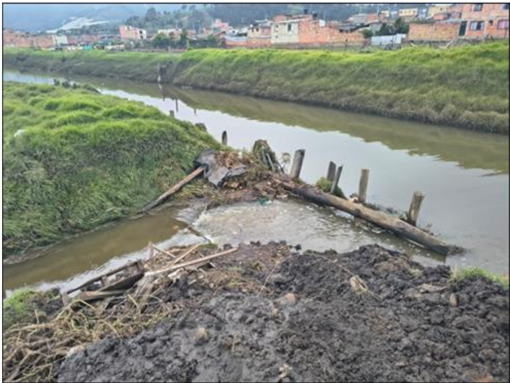
Fotografía 7. Detalle de la excavadora, motobomba y accesorios operativos utilizados durante la atención de la emergencia. Fuente: propia.
