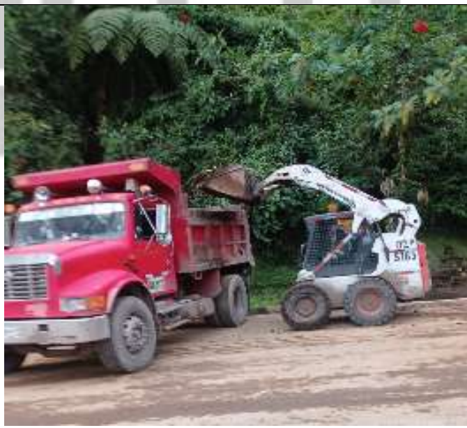
Cargue de material
