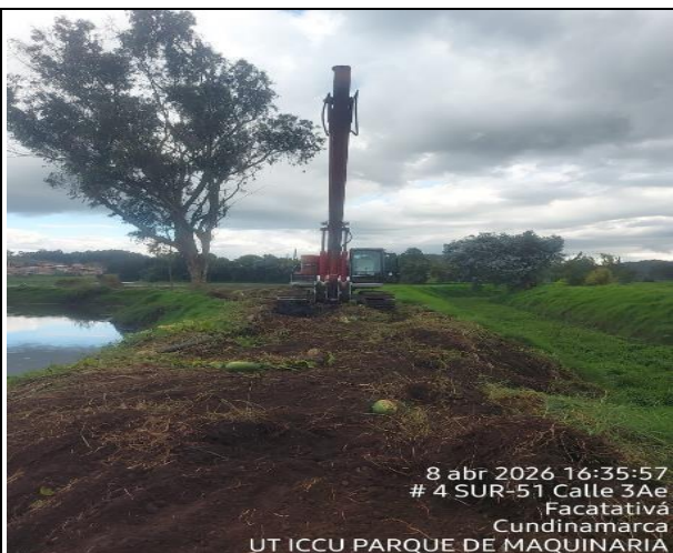
Retiro de material sobrante.
