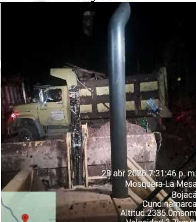
Cargue de material
