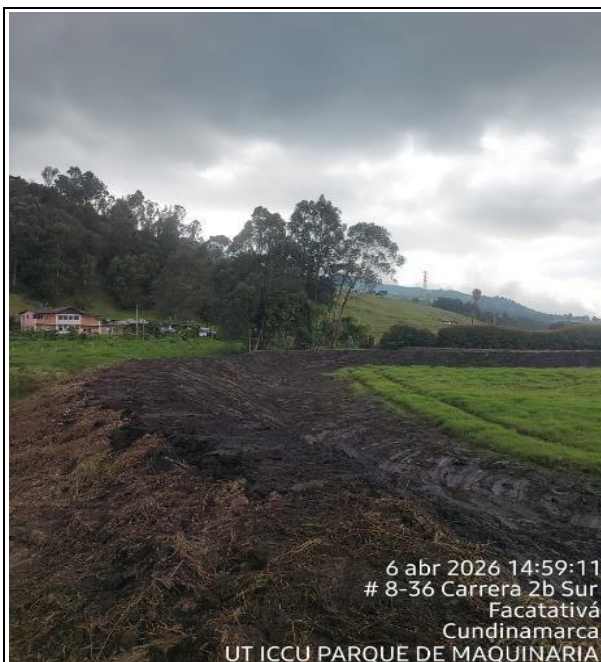
Conformación de jarillon
