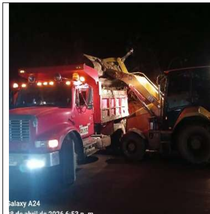
Cargue de material
