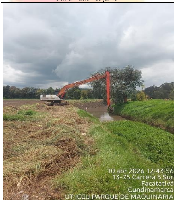
Conformación de jarillon
