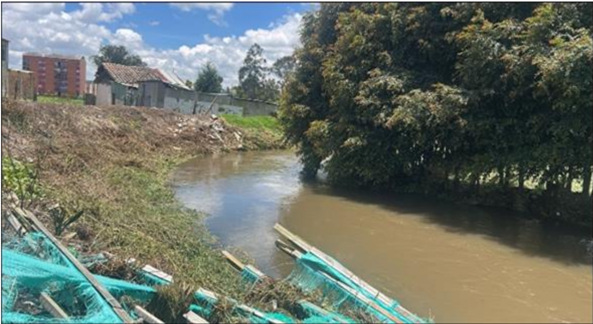
Fotografía 3. Imagen donde la zona del río Botello en el barrio Sauzalito. Fuente: propia
