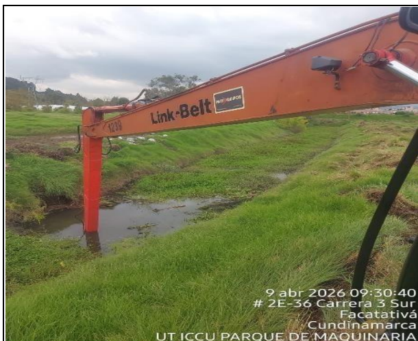
Extracción de material vegetal y material colmatado de río.
