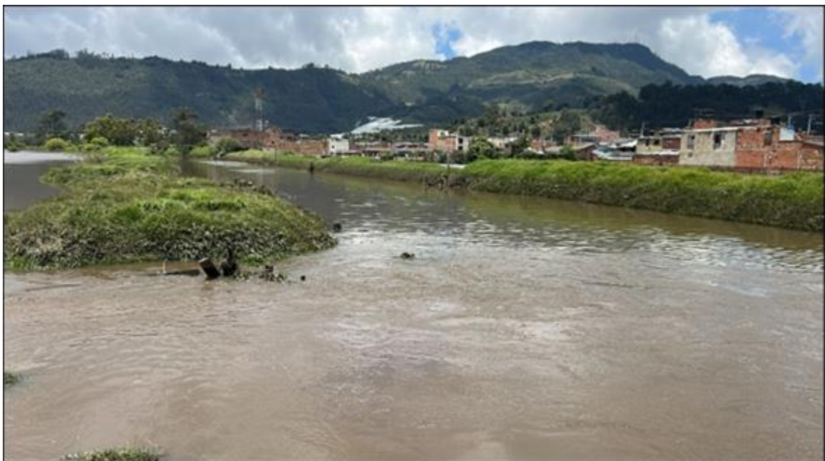
Fotografía 2. Imagen donde se evidencia el alto nivel del río Botello a la altura del puente Los Micos, así como la ruptura del talud en el margen derecho e izquierdo de la fuente hídrica. Fuente: propia
