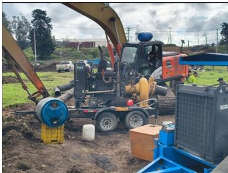
Fotografía 11. Detalle de motobomba, tuberías y accesorios dispuestos para el sistema de succión y descarga durante la operación de emergencia. Fuente: propia.
