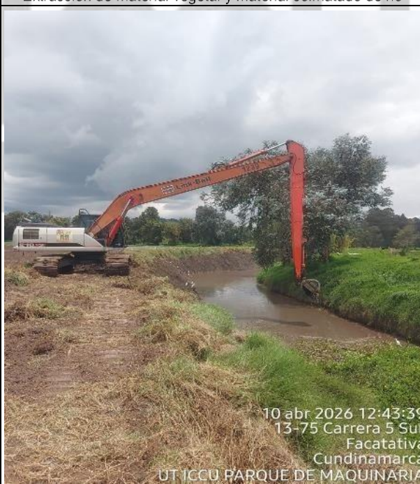
Extracción de material vegetal y material colmatado de río
