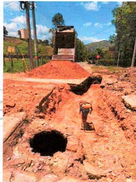
RELLENO TIPO 2 RECEBO (Imagen 2)
