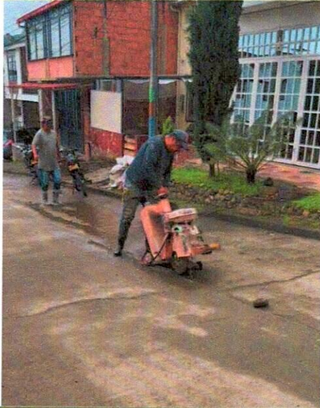
CORTE DE PAVIMENTO
