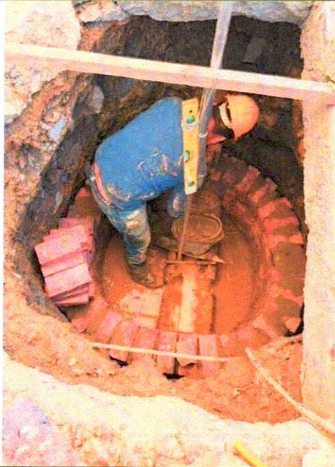
CILINDRO POZO EN LADRILLO TOLETE (Imagen 1)
