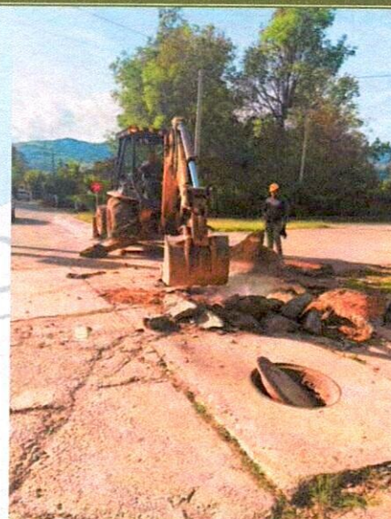
EXCAVACIONES VARIAS A MAQUINA Imagen 1
