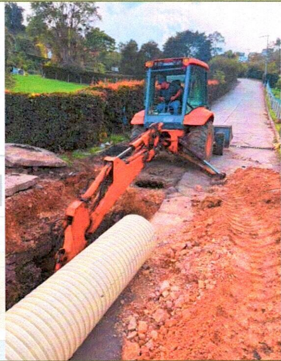
INSTALACIÓN DE TUBERÍA PVC 20" (imagen 2)
