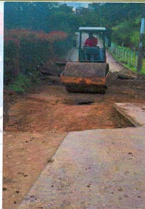
SUB BASE COMPACTADA (Imagen 2)
