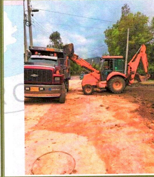
RETIRO DE MATERIAL PROCEDENTE DE EXCAVACION (Imagen 2)
