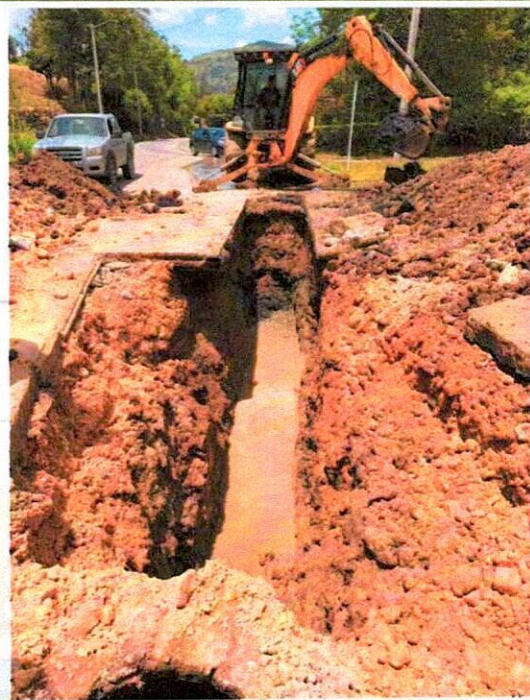
EXCAVACIONES VARIAS A MAQUINA (Imagen 3)
