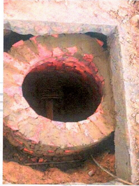
CILINDRO POZO EN LADRILLO TOLETE (Imagen 2)
