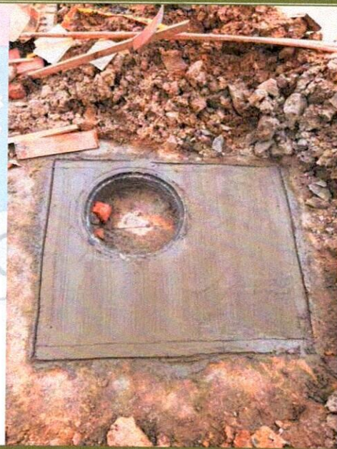
CUBIERTA POZO (Imagen 2)
