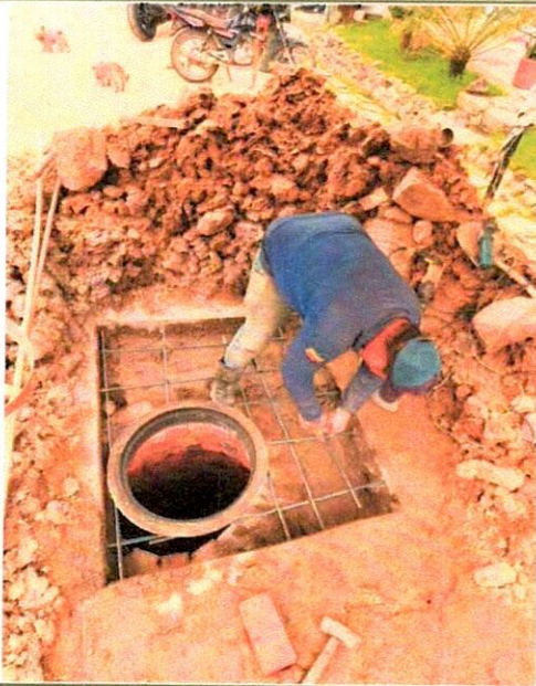
CUBIERTA POZO (Imagen 1)
