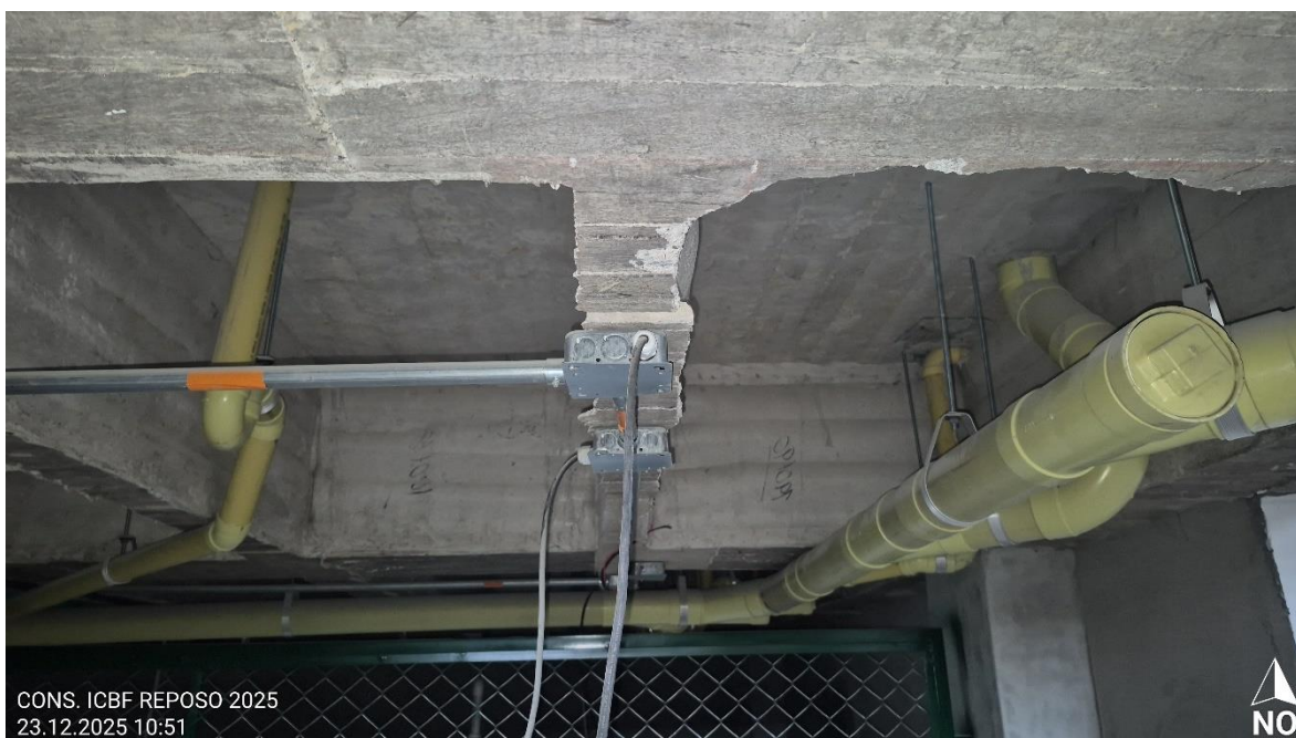
Imagen 5. Parqueadero N 0.00 – 7.00 m: Redes y ductos existentes en zona de parqueadero, cuarto de tanque.
