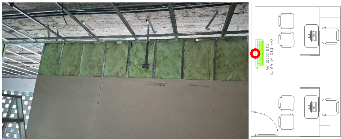
Imagen 1. Instalación de salida eléctrica para evaporadora de aire acondicionado en módulo de trabajo ICBF.
