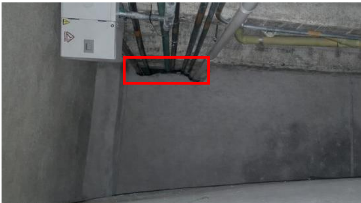
Imagen 3. Parqueadero N 0.00 – 7.00 m: Redes y ductos existentes en zona de parqueadero, cuarto de tanque. Se señala el espacio usado para redes existentes.
