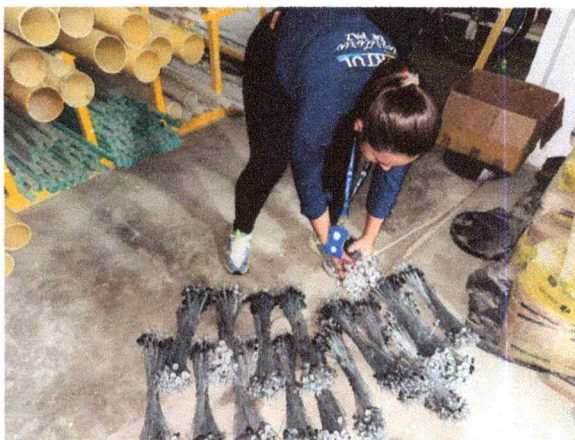
Evidencia Fotográfica: 7-8 Amarres metálicos
