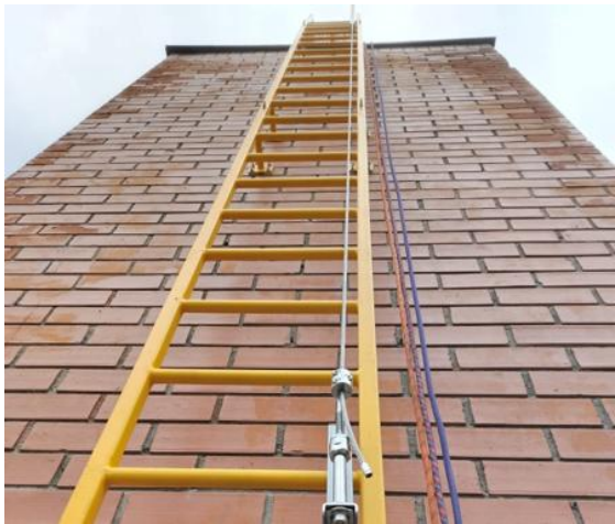
3.02 Suministro e instalación de cable de acero inoxidable Ø8 mm dispuesto en sentido vertical, tensado entre anclajes.
