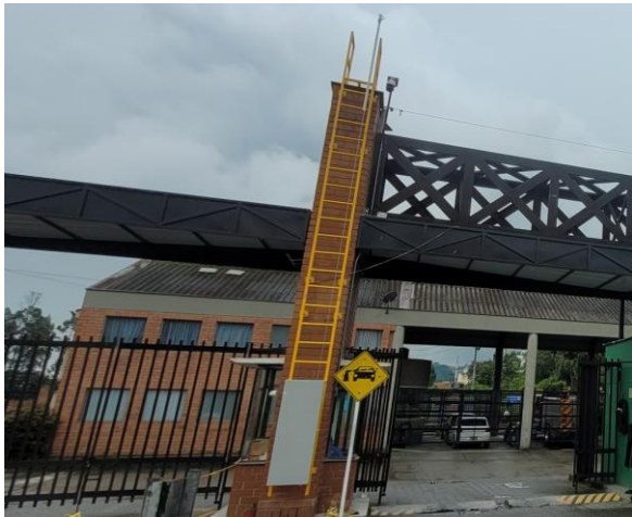
3.02 Suministro e instalación de cable de acero inoxidable Ø8 mm dispuesto en sentido vertical, tensado entre anclajes.
