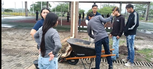
PRACTICA DE DOSIFICACION Y ELABORACION DE CONCRETO
