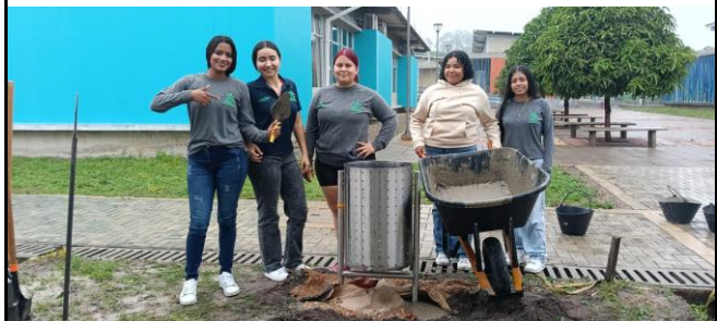
PRACTICA SOBRE ELBAROCION DE CONCRETO, SENTADA CANECA BASURA DAÑADA
