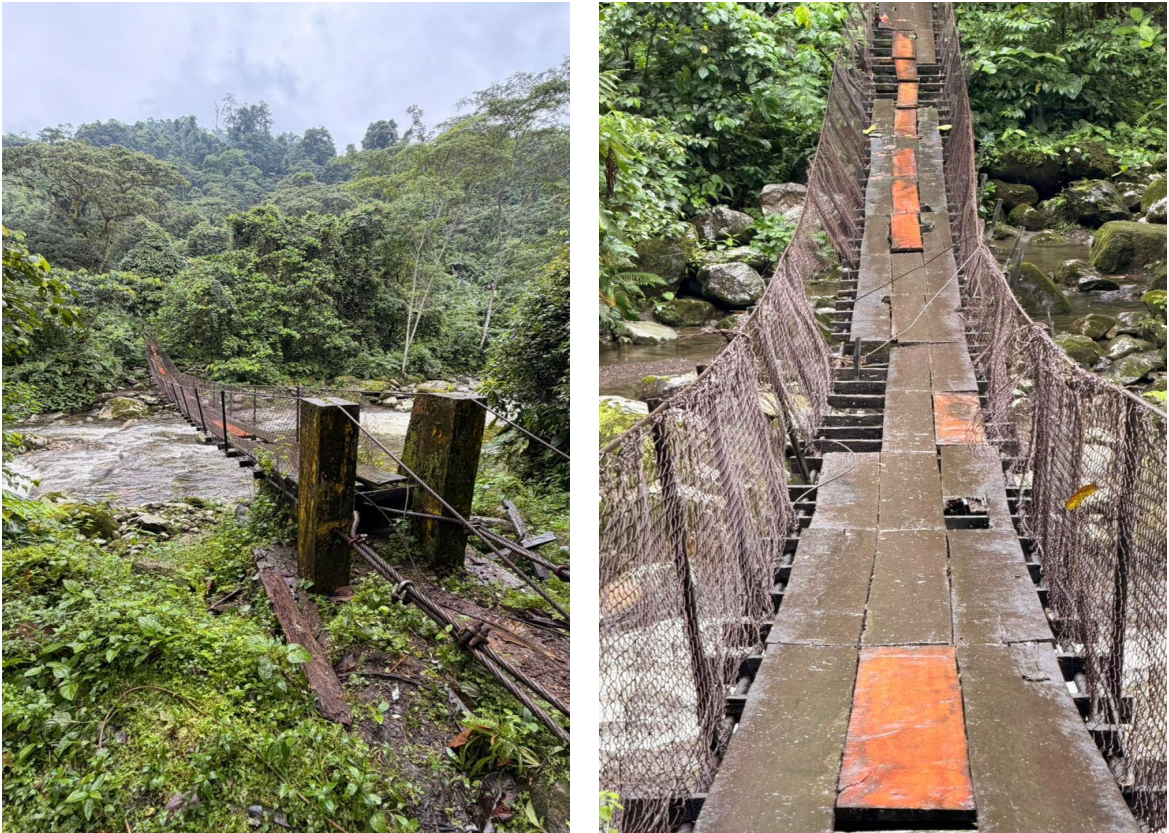
Figura 1.2. Estado actual del Puente Hamaca. Fuente: Sec. Planeación y Obras Públicas (2026).
