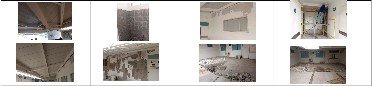
VERIFICACIÓN DE ALCANCE TÉCNICO EN LOS FRENTES DE OBRA DEL CONTRATO.
