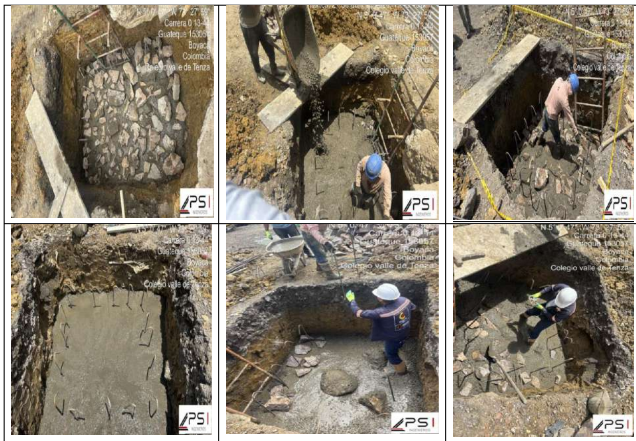
Ilustración 10: Instalación de concreto ciclópeo a zapatas ejes ay b cubierta
