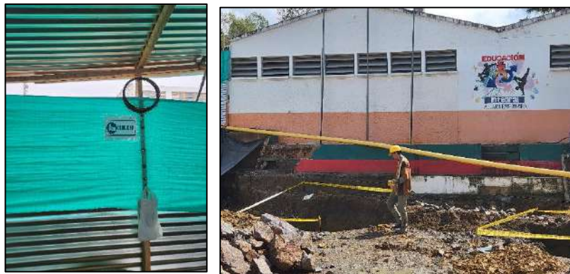
Ilustración 5. Señalización y demarcación en obra
