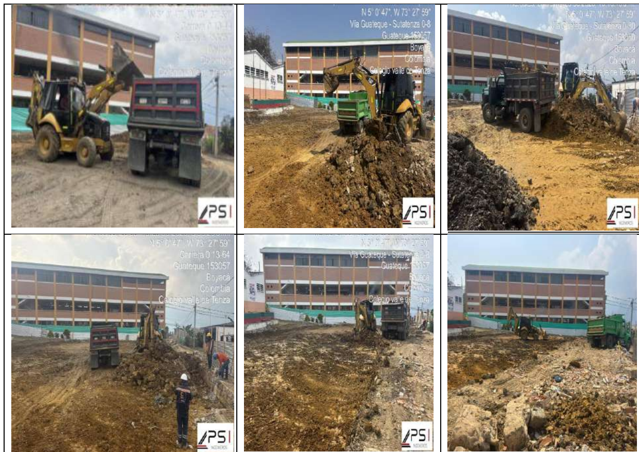
Ilustración 6. Cargue y transporte de materiales sueltos:
