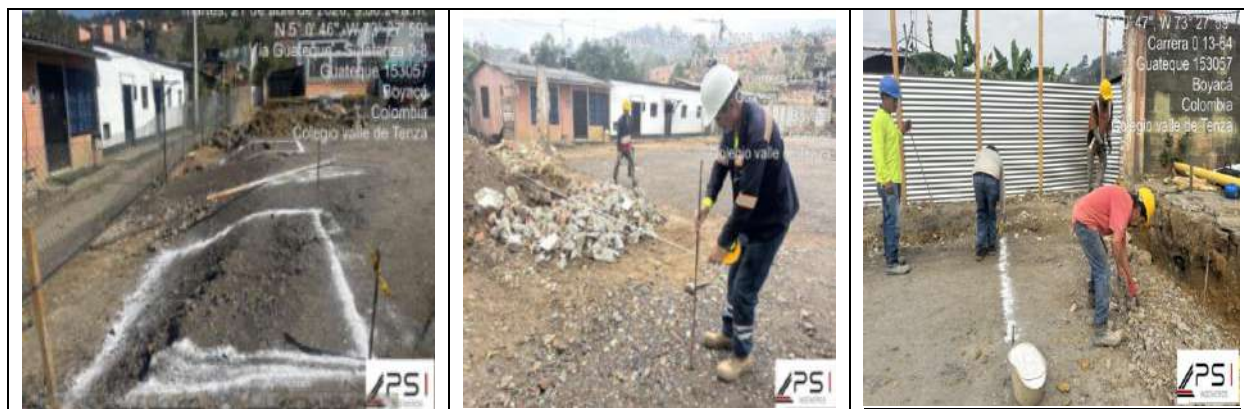
Ilustración 3: Replanteo de obra arquitectónica
