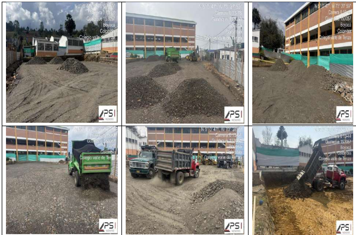
Ilustración 9: Transporte de materiales granulares
