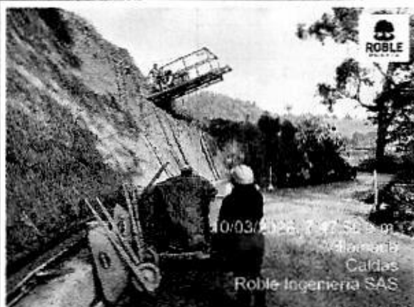
Ilustración 91. Supervisión de construcción de pantalla reticular- Tramo 3.
