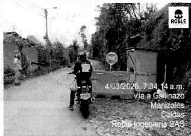
Ilustración 110. Regulación de tránsito. Tramo 1 Ternium.
