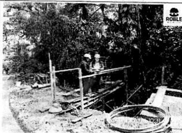
Ilustración 90. Supervisión construcción de caisson- Tramo 3 sector el Pontón.
