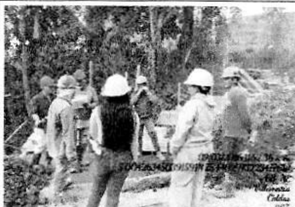
Ilustración 96. Divulgación del procedimiento seguro de construcción de Caisson
