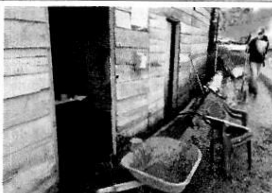
Ilustración 124. Limpieza y aseo- Campamento
