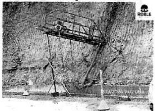
Ilustración 21. Equipo para perforaciones Horizontales
