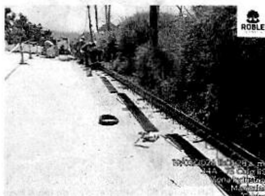
Ilustración 58 Acero de refuerzo Bordillo
