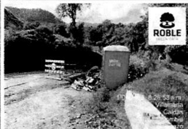
Ilustración 118. Señalización PMT, Tramo 3.
