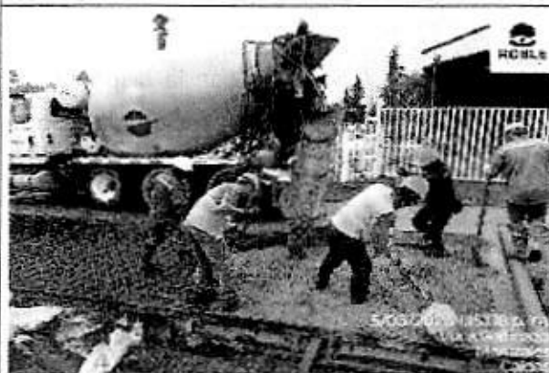
Ilustración 99. Uso de EPP- Vaciado de concreto- Tramo 1.
