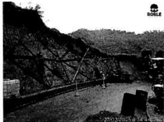
Ilustración 72 Vigas pantalla reticular
