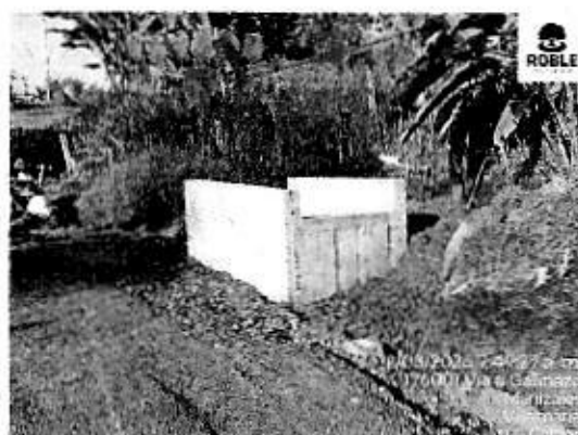
Ilustración 12. Poceta de Encole transversal
