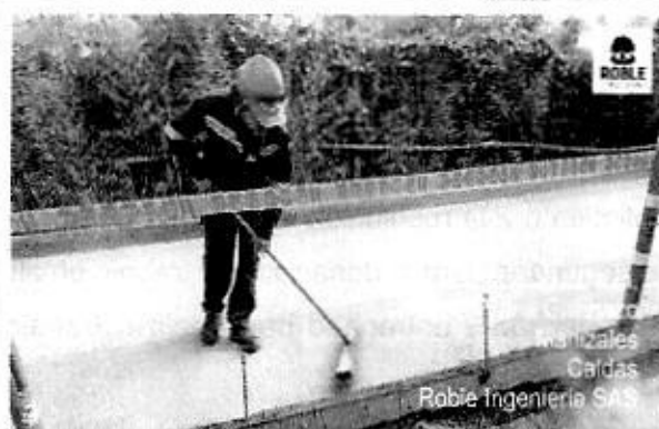
Ilustración 121. Orden y Aseo, Tramo 1, Ternium.
