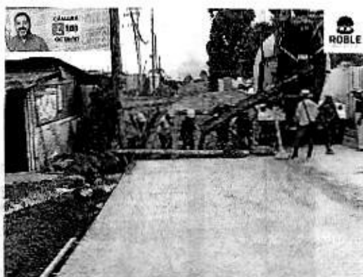
Ilustración 35. Vaciado pavimento Rígido MR45
