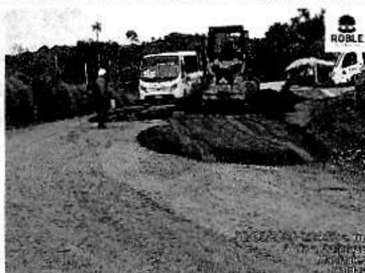
Ilustración 76. Instalación Subbase Granular
