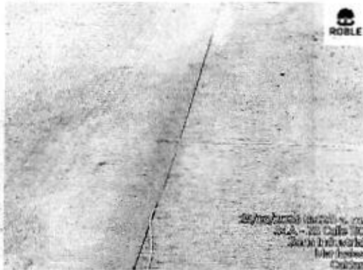
Ilustración 65 Corte y sello de losas
