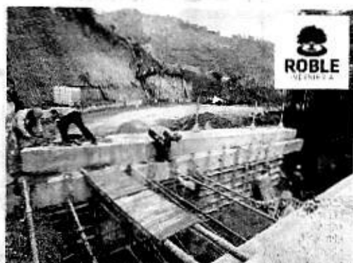
Ilustración 27. Instalación Formaleta pantalla Pontón
