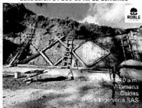
Ilustración 56 Vigas Pantalla Reticular
