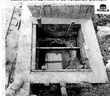
Ilustración 64 Caja para manejo de aguas lluvias
