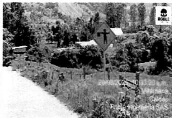
Ilustración 114. Señalización tramo 2. Tarmales
