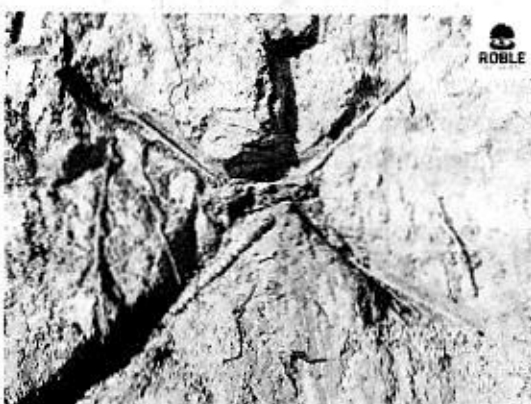
Ilustración 15. Anclaje Pasivo Pantalla Reticular
