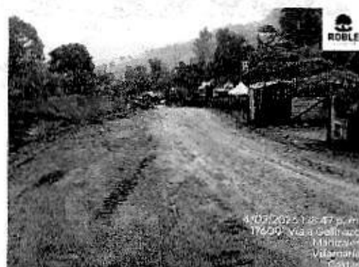
Ilustración 28. Instalación subbase tramo 02
