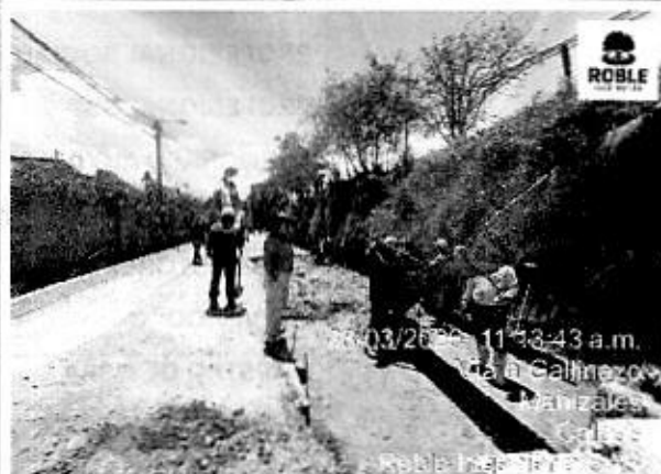
Ilustración 92. Supervisión de vaciado de concreto tramo 1 Sector Ternium.
