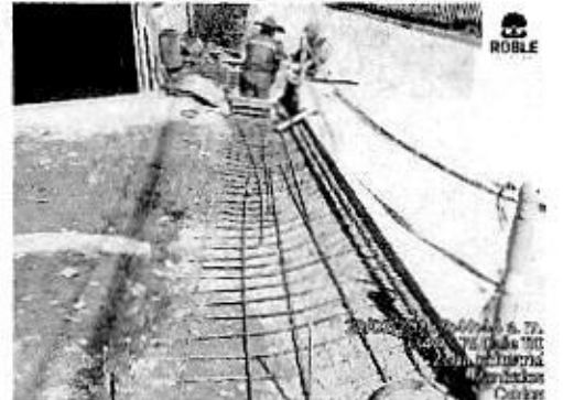
Ilustración 74 Acero de refuerzo entrada parqueaderos
