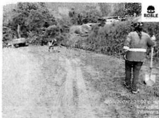
Ilustración 31. Aplicación de estructura por cajeo
