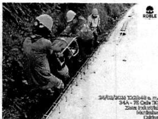
Ilustración 63 Conformación de talud tramo 1
