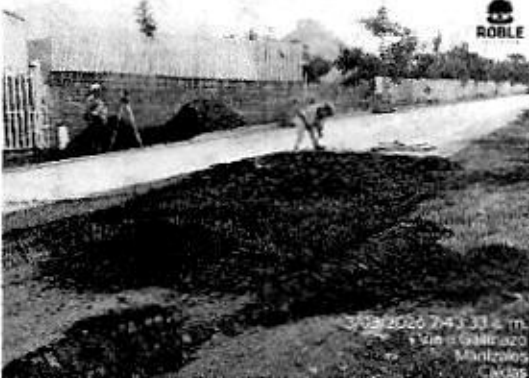
Ilustración 19. Chequeo Topográfico empalme pavimento Rígido
