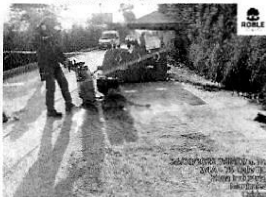
Ilustración 69 Corte pavimento rígido
