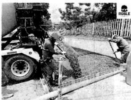
Ilustración 47. Aplicación de concreto
