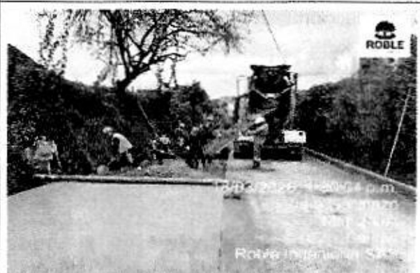
Ilustración 101. Uso de EPP- Tramo 1- Sector Ternium.
