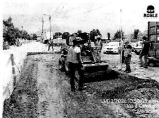
Ilustración 22. Instalación Subbase granular tramo 01
