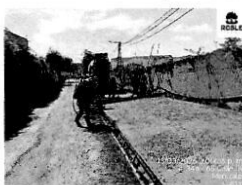
Ilustración 50. Aplicación pavimento Rígido MR45
