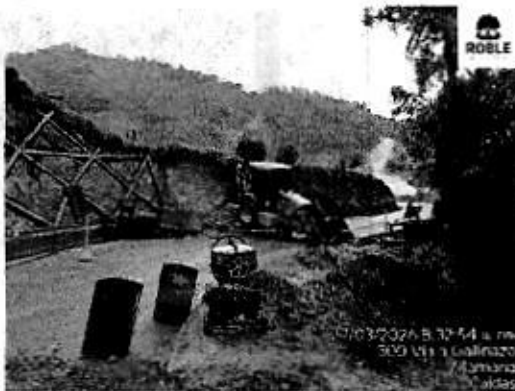
Ilustración 71 Corte talud mejoramiento geométrico
