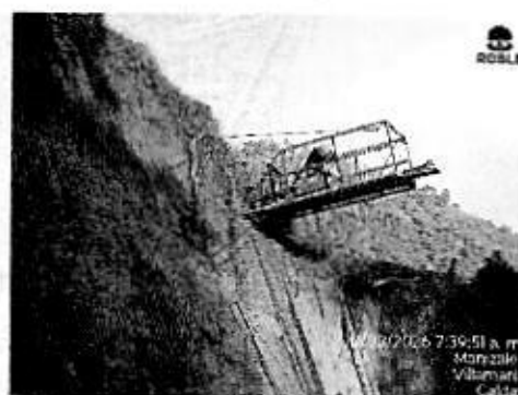
Ilustración 44. Perforación para anclaje pasivo
