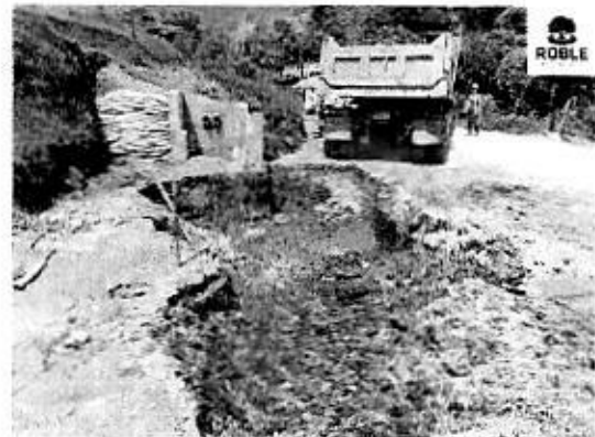
Ilustración 18. Cajero para sustitución de estructura de soporte
