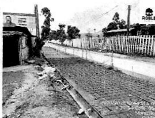
Ilustración 34. Acero de refuerzo y Canastillas de dovelas
