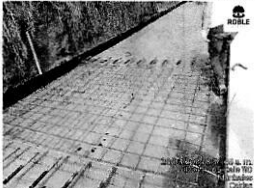
Ilustración 73 Acero de refuerzo pavimento rígido
