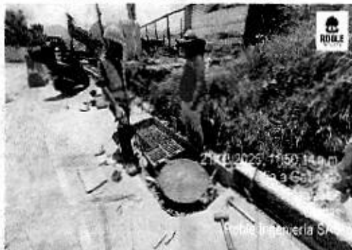
Ilustración 61 Construcción sumidero
