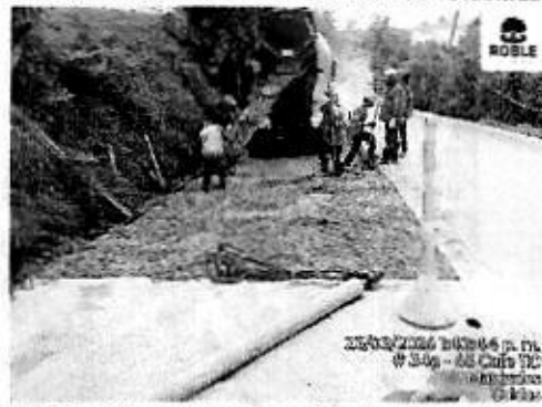
Ilustración 68 Vaciado pavimento rígido MR45
