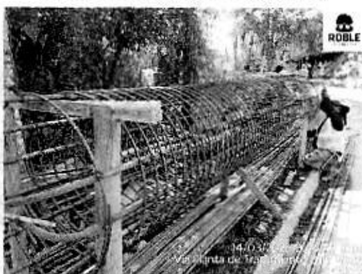
Ilustración 51. Acero de refuerzo Caisson
