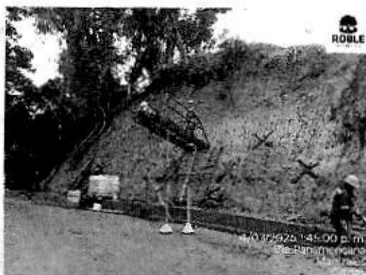
Ilustración 29. Perforación para anclajes Pasivos
