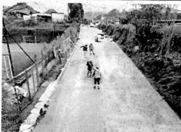
Ilustración 88. Supervisión de vaciado de concreto tramo 1 Sector Ternium.
