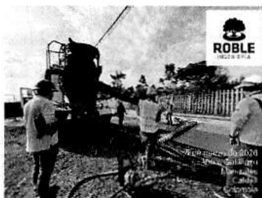
Ilustración 36. Vaciado pavimento Rígido MR45
