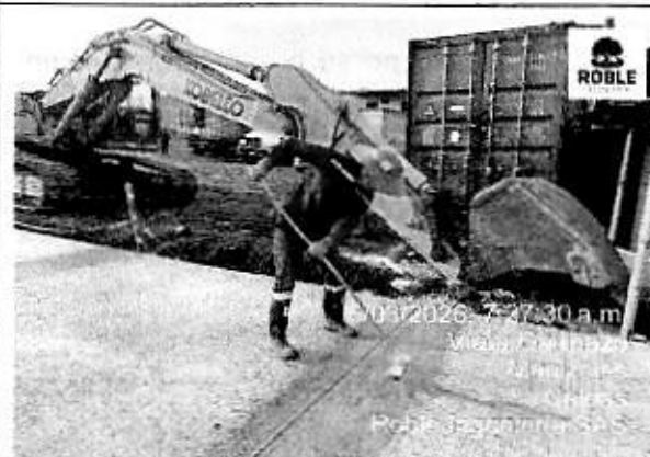
Ilustración 119. Orden y Aseo, Tramo 1, Ternium.
