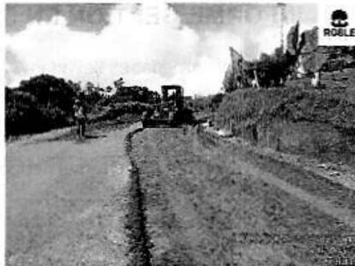
Ilustración 78 Instalación subbase granular
