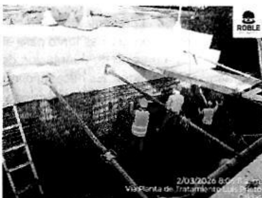
Ilustración 13. Instalación de acero Pantallas Pontón
