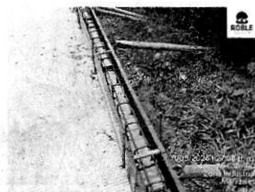
Ilustración 49. Acero de refuerzo Bordillo
