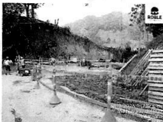
Ilustración 39. Demarcación y señalización con cinta de seguridad
