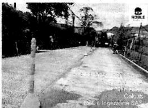
Ilustración 55 Aplicación pavimento rígido MR45
