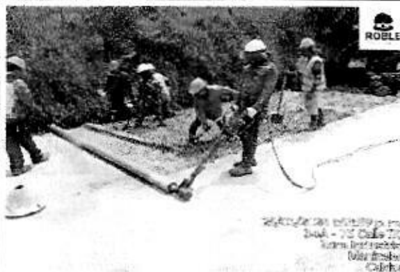
Ilustración 102. Uso de EPP- Tramo 1- Sector Ternium.
