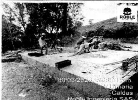
Ilustración 104. Uso de EPP- Vaciado de Concreto- Tramo 3 El Pontón.
