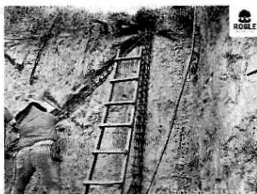
Ilustración 48. Acero de refuerzo viga Pantalla Reticular
