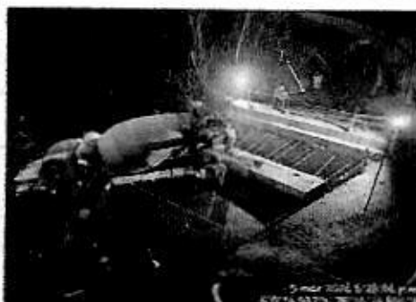
VACIADO DE CONCRETO- TRAMO 01 TERNIUM
