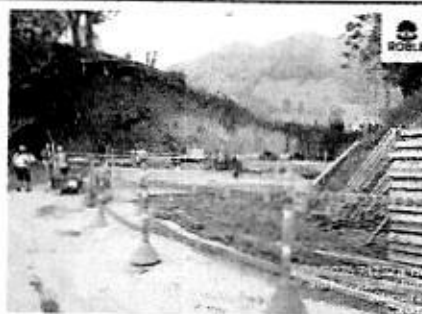
SEÑALIZACIÓN- TRAMO 3 PONTÓN
