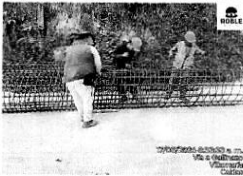
FIGURADO DE ACERO PARA CAISSON - SECTOR PONTÓN
