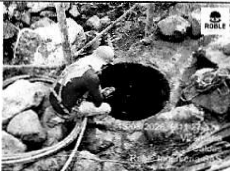
MEDICIONES ATMOSFÉRICAS DE GASES EN ESPACIOS CONFINADOS
