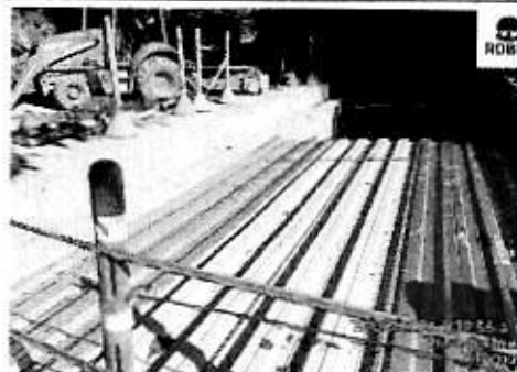
INSTALACIÓN FORMALETA (FONDO) PARA LOSA - SECTOR PONTÓN
