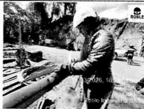
VERIFICACIÓN DE PERMISOS EN ALTURAS Y ESPACIOS CONFINADOS
