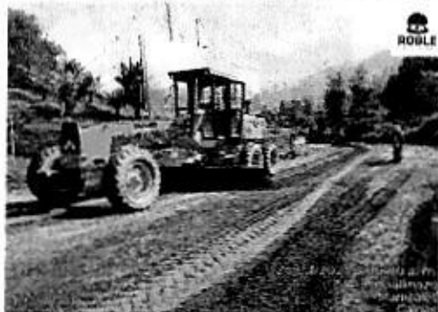
INSTALACIÓN DE SUBBASE - TRAMO 02 TERMALES
