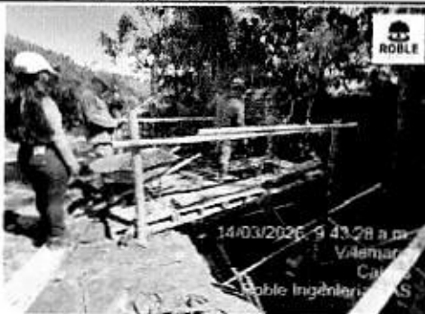
CONSTRUCCIÓN DE CAISSONS
