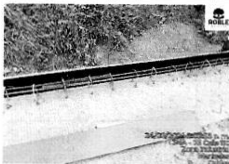
INSTALACIÓN DE FORMALETA PARA BORDILLO - TRAMO 01 TERNIUM
