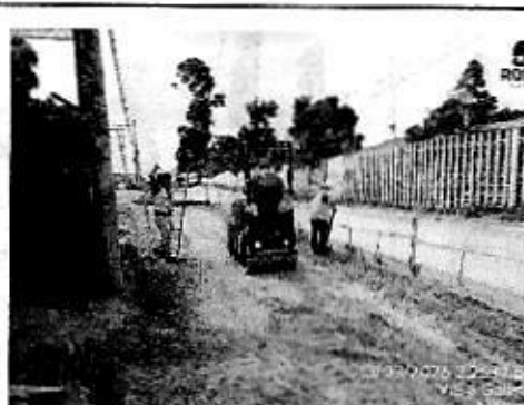
COMPACTACIÓN DE SUBBASE - TRAMO 01 TERNIUM
