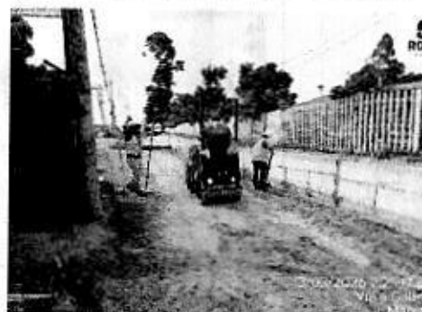
COMPACTACIÓN DE SUBBASE - TRAMO 01 TERNIUM
