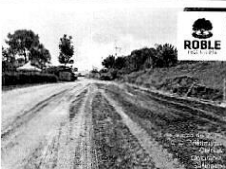
INSTALACIÓN DE SUBBASE - TRAMO 02 TERMALES
