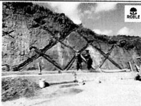
CONSTRUCCIÓN DE PANTALLA RETICULAR
