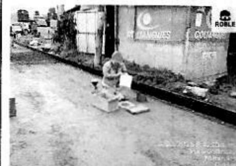
TOMA DE DENSIDADES- TRAMO 01- TERNIUM
