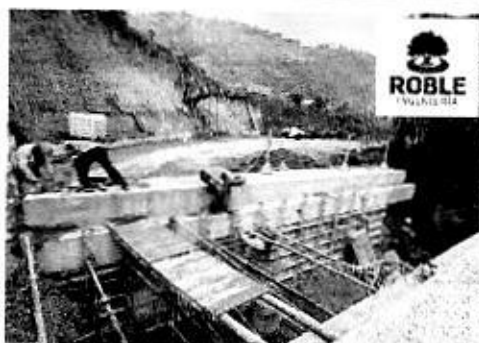
INSTALACION FORMALETA DE PANTALLA CAISSON 1, 2, 3 Y 4 - TRAMO 3
