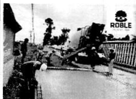
VACIADO DE CONCRETO- TRAMO 01 TERNIUM
