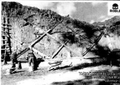
VIGAS RETICULARES - SECTOR PANTALLA
