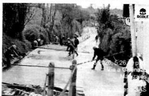
VACIADO DE CONCRETO - TRAMO 1 TERNIUM
