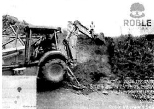
Ilustración 155 Limpieza y perfilado de talud
