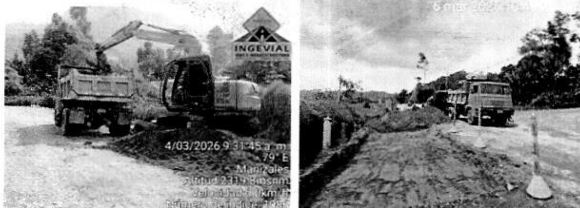
Ilustración 141 Cargue de Volqueta
