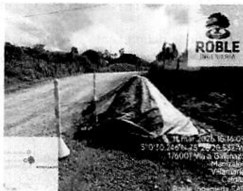
Ilustración 132 Manejo de materiales de construcción
