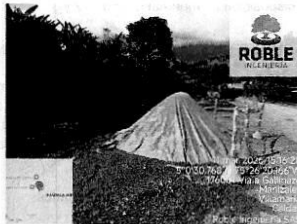
Ilustración 134 Manejo de materiales de construcción
