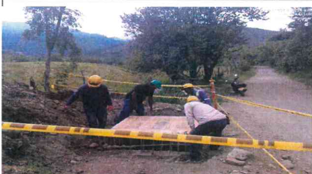
CONSTRUCCION DE CAMARA DE PURGA TRAMO 3
