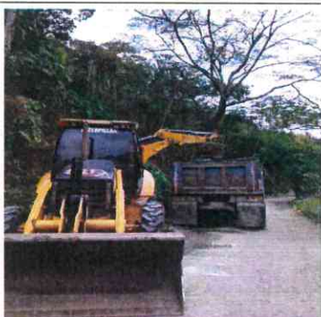
EXCAVACION A MAQUINA TRAMO 1 TUBERIA PEAD 18"
