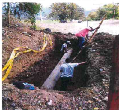
EXCAVACION PARA CAMARA DE QUIEBRA DE PRESION TRAMO 3
