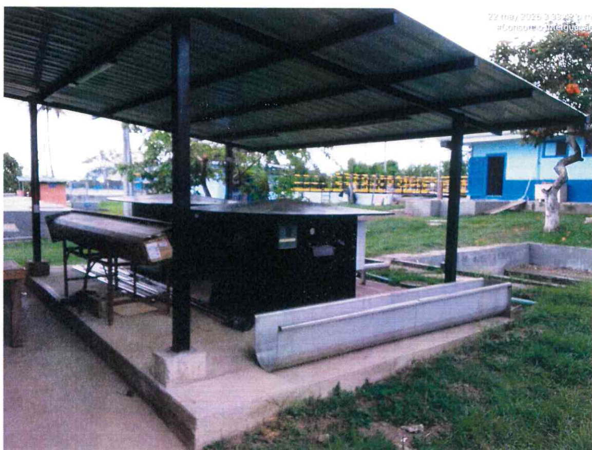
Suministro e Instalación de sopladores -Son dos unidades y en operación para las pruebas de los filtros
