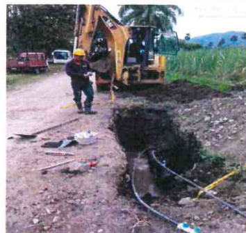
INICIO DE LLENADO DE TUBERIA PARA OTRA PRUEBA HIDROSTATICA PEAD 14" TRAMO 3
