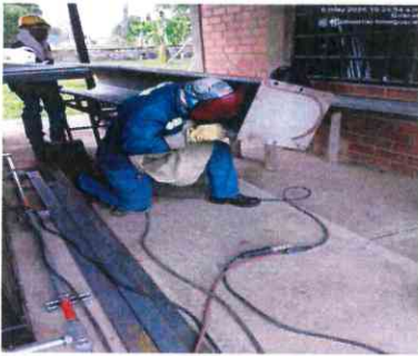
CONSTRUCCION DE CANALETAS EN ACERO INOXIDABLE PARA MODULO A DE FILTRACION EN PTAP GUACARI
