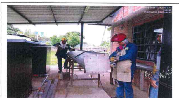
CONSTRUCCION DE CANALETAS EN ACERO INOXIDABLE PARA MODULO A DE FILTRACION EN PTAP GUACARI
