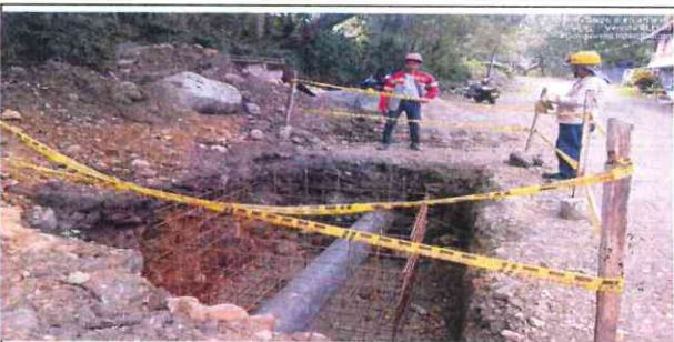
CONSTRUCCION DE CAMARA DE VENTOSA TRAMO 3
