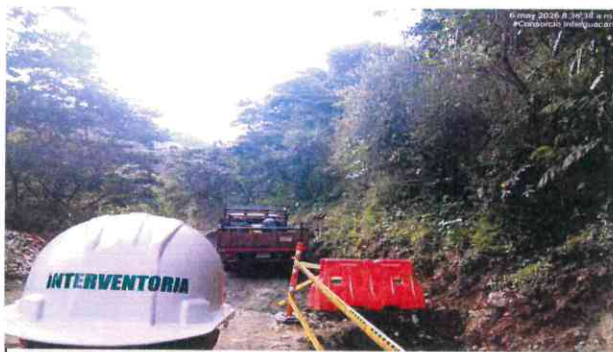
INSTALACION TUBERIA PEAD 18" TRAMO 1
