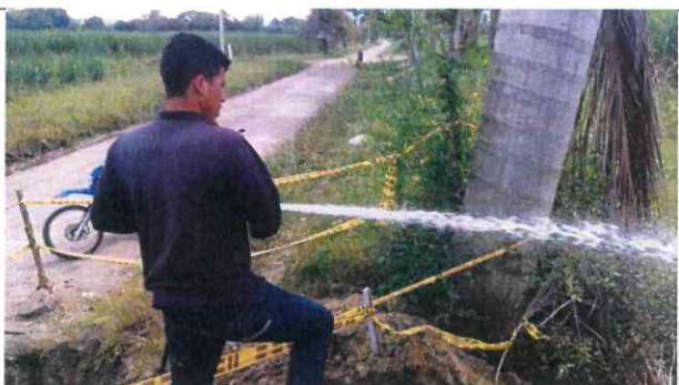
PRUEBA HIDROSTATICA TUBERIA PEAD 14" TRAMO 3
