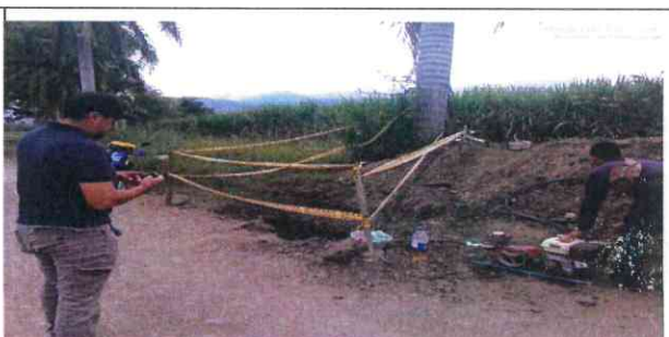
PRUEBA HIDROSTATICA TUBERIA PEAD 14" TRAMO 3
