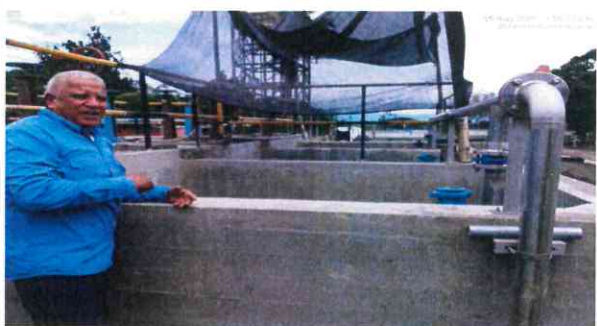
VERIFICACION DEL ESTADO DEL MODULO B CON OPERADOR DE ACUAVALLE PTAP GUACARI
