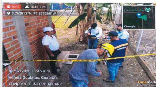
VERIFICACION DE RETIE PTAP GUACARI
