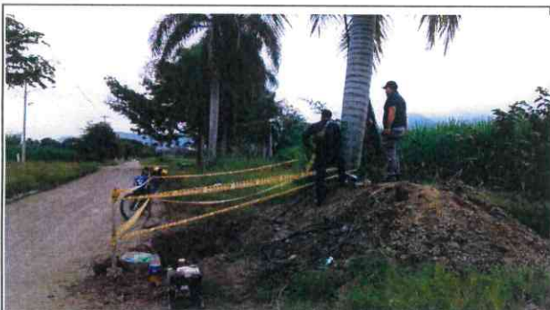
PRUEBA HIDROSTATICA TUBERIA PEAD 14" TRAMO 3
