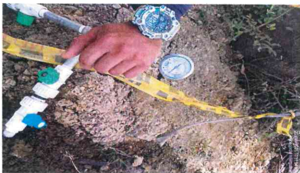
PRUEBA HIDROSTATICA TUBERIA PEAD 14" TRAMO 3
