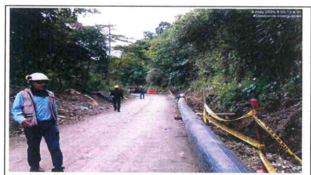
INSTALACION TUBERIA PEAD 18" TRAMO 1
