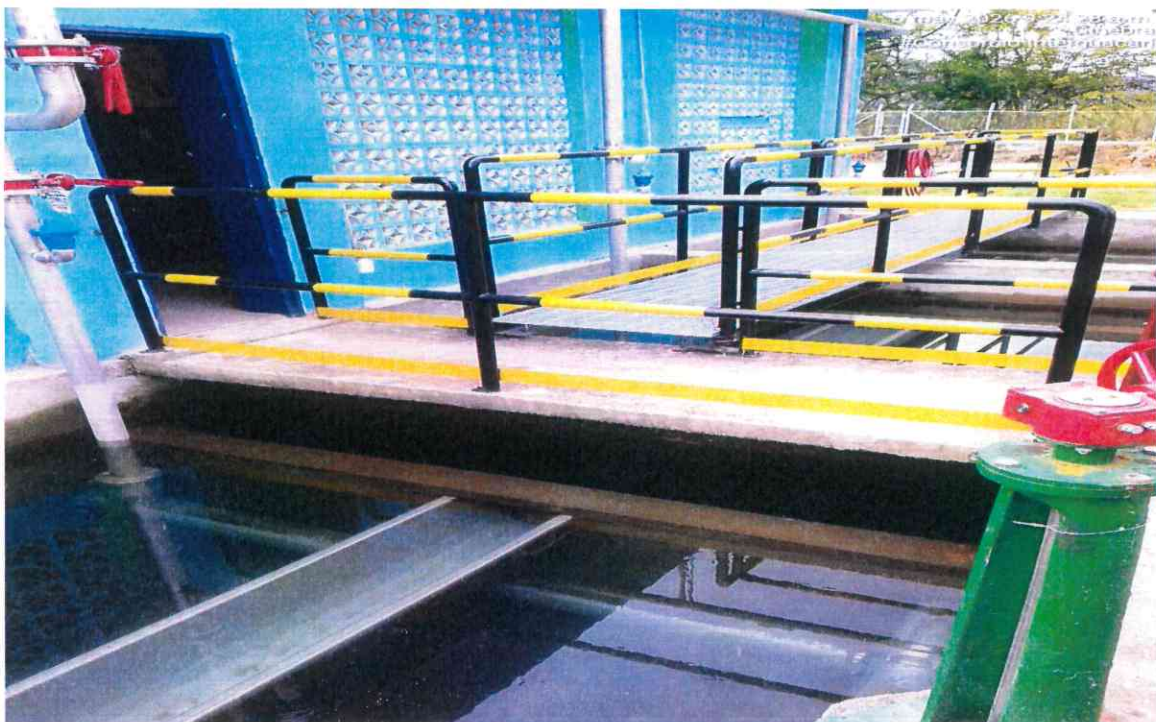
Filtro No. 03: Terminado y en servicio
