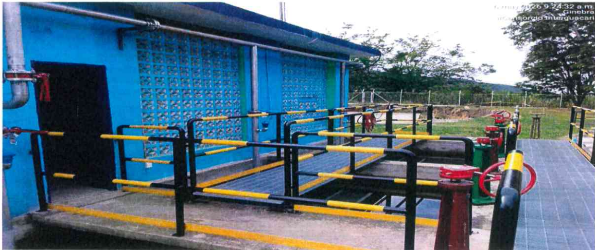
Filtro No. 02: Terminado y en servicio
