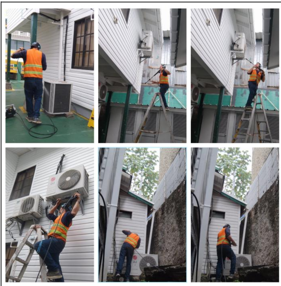
Registro fotográfico APOYO ADMINISTRATIVO, ALMACEN, ARCHIVO. BLOQUE 4 y 5
