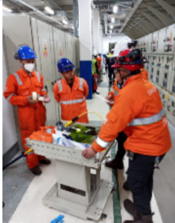
Se validan las 5 reglas de oro en trabajos eléctricos.
