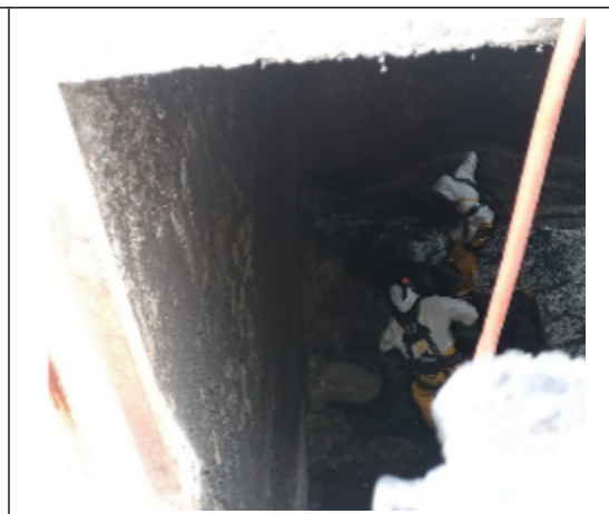
Verificación de uso correcto de EPP en actividades ejecutados en Espacios confinados
