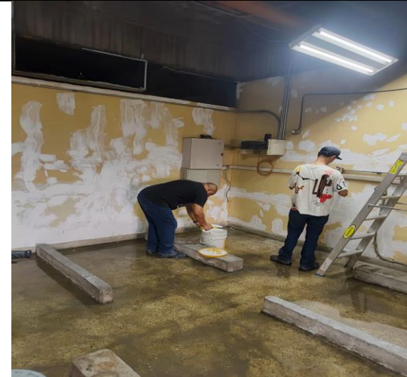
Obras civiles aires - sótano
