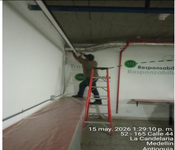
Desmante cielos falsos sótano
