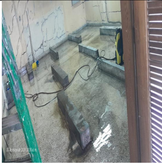
Desobstrucción tubería sótano
