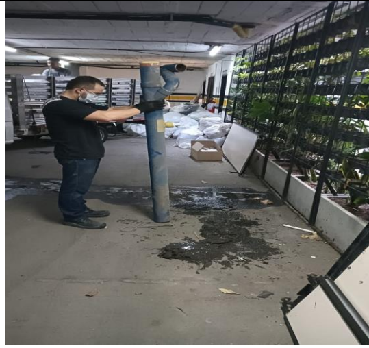
Desmante pared y cielo falso piso 8
