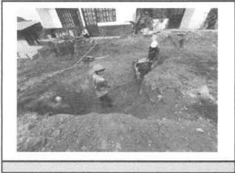
ITEM No.7 Relleno en recebo compactado capas cada 0.30 mt
