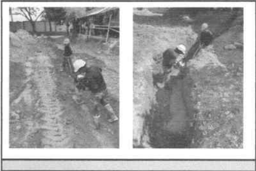
ITEM No.7 Relleno en recebo compactado capas cada 0.30 mt
