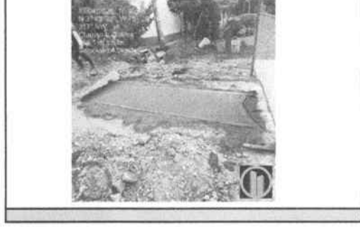
ITEM No.16 Concreto de 4000 psi para reposición de pavimnto
