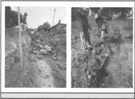
ITEM No.7 Relleno en recebo compactado capas cada 0.30 mt
