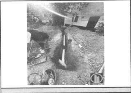
ITEM No.14 Instalación de tubería PVC 6" y accesorios silla Yee
