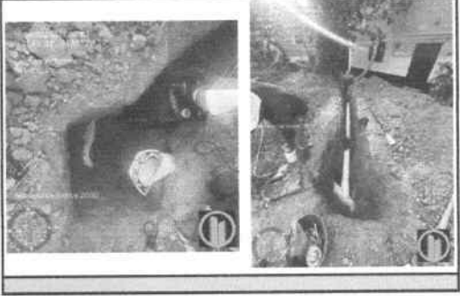
ITEM No.14 Instalación de tubería PVC 6" y accesorios silla Yee
