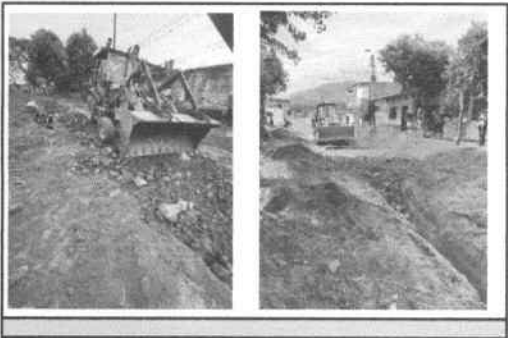
ITEM No.7 Relleno en recebo compactado capas cada 0.30 mt
