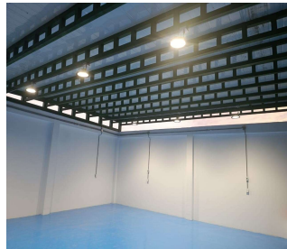
Taller de soldadura
