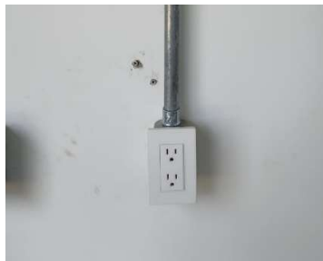
Taller de soldadura
