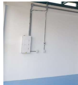
Taller de soldadura
