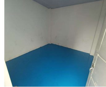
Bodega de cilindros
