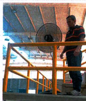
Fotografía N.º 4 — Ítem 71: VENTILACIÓN
