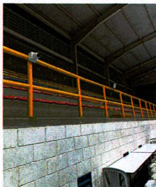
Fotografía N.º 3 — Ítem 22: SEGURIDAD
