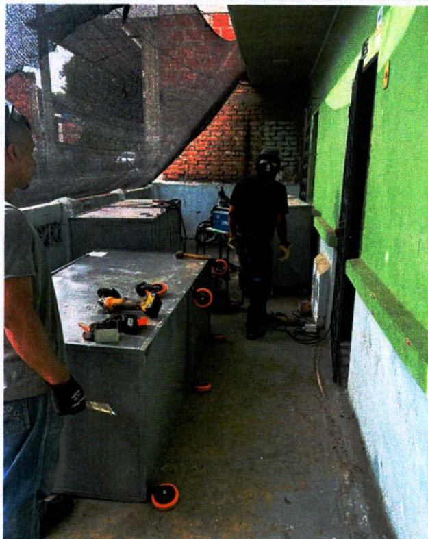
Fotografía N.º 1 — Ítem 66: MANTENIMIENTO
