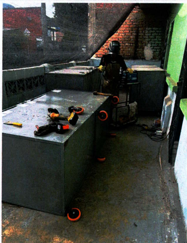
Fotografía N.º 2 — Ítem 66: MANTENIMIENTO
