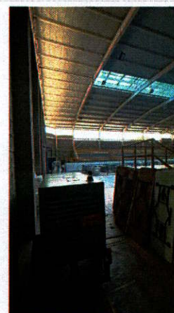
Fotografía N.º 2 — Ítem 21: PLANTA ELÉCTRICA
