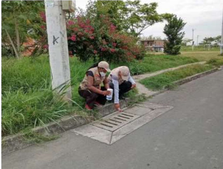
Figura 16. Inspección y tratamiento de sumideros en vía pública
