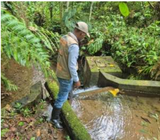
Bocatoma Sistema 5 Maravelez
