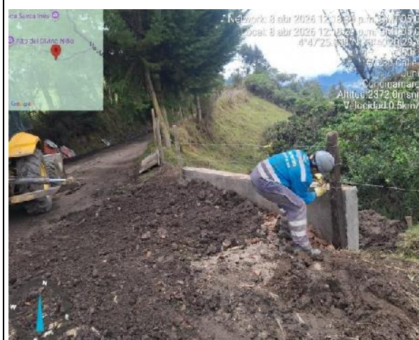
Relleno y compactación
