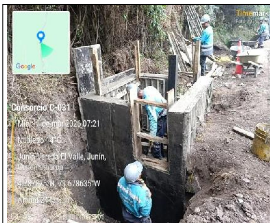
Concreto de 3000 PSI paredes
