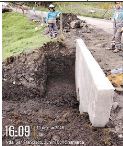
Concreto de 3000 PSI paredes
