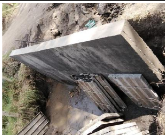
Concreto de 3000 PSI paredes
