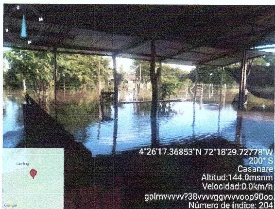
Foto 2. Vista desde interior del PAPS hacia el exterior. Inundación total de la zona circundante. Coord: 4°26'17.37"N 72°18'29.73"W. Índice 204, Garibay, Casanare.
