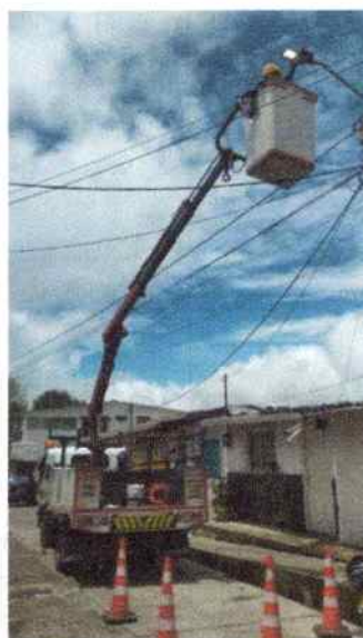
Labores de mantenimiento en el barrio Horizontes
